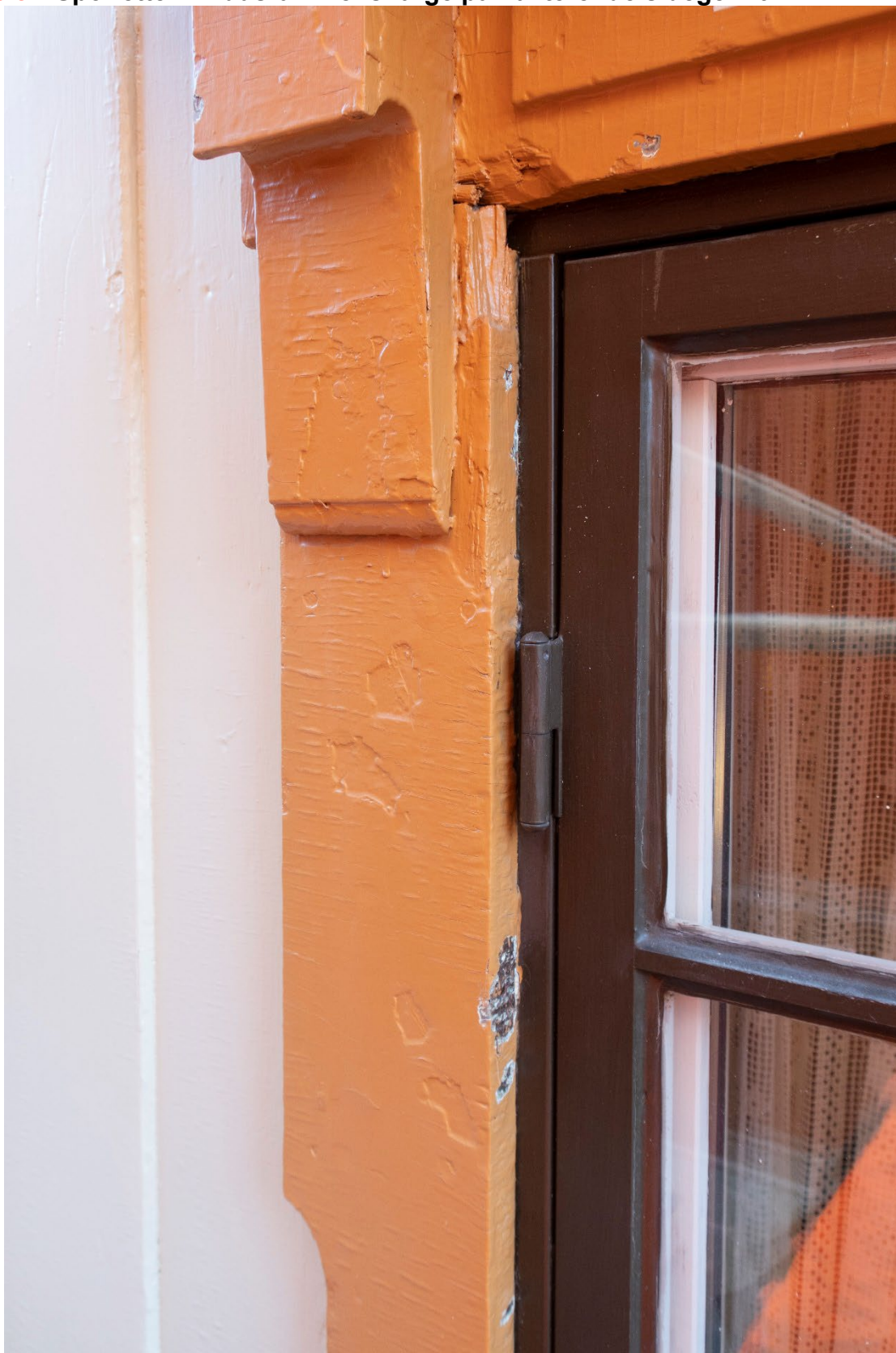
Figur 19 På siden av geriktene (sidegerikter og overgerikt) er det funnet en blank, mørk rødbrun som første lag. Fargen er malt helt ut til kanten og fremstår mer «villet» enn malingsl. Fargen er ikke funnet på framsiden av gerikten eller siden ut mot veggen. Foto: NIKU, 2022.
