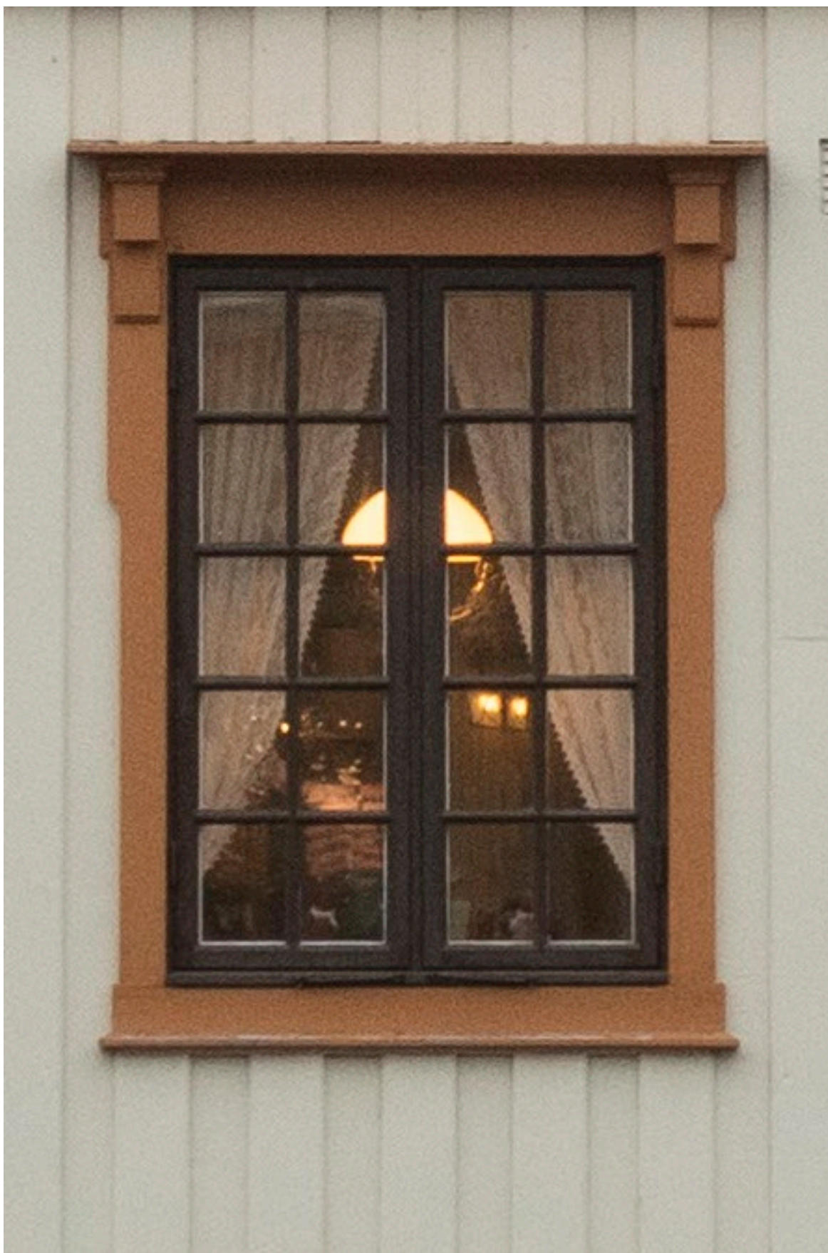
Figur 2 To-rams vindu med 2x5 ruter. Ramme og sidegerikter er sekundære. Foto: NIKU, 15.11.2022.
