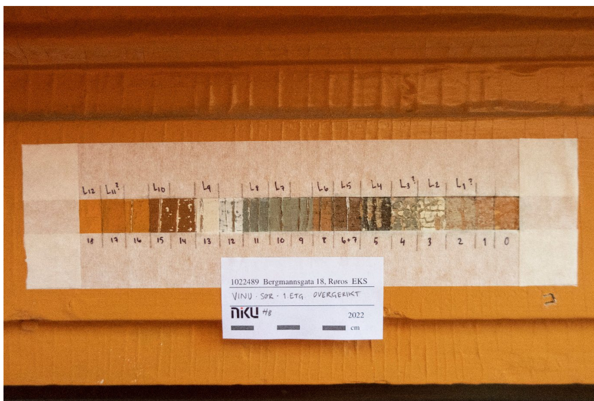
Figur 16 Lagvis avdekking på gerikt på vindu i 1. etasje. Materialprøve til tverrsnitt er tatt under avdekningen, til høyre i bildet. Foto: NIKU, 2022.
