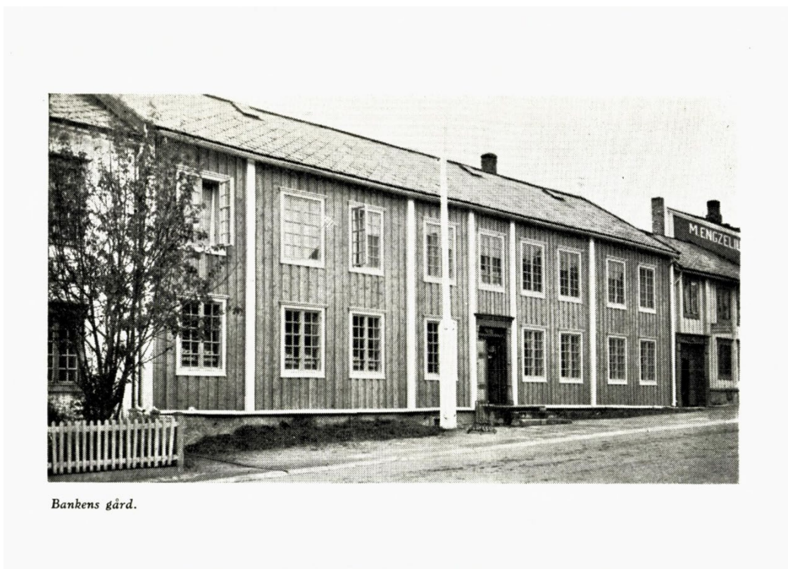
Figur 8 Bergmannsgata 20, 1942. Nr. 18 ses helt til venstre i bildet. De smårutede vinduene er satt inn. Hentet fra: Kvikne, 1942, s. 454.
