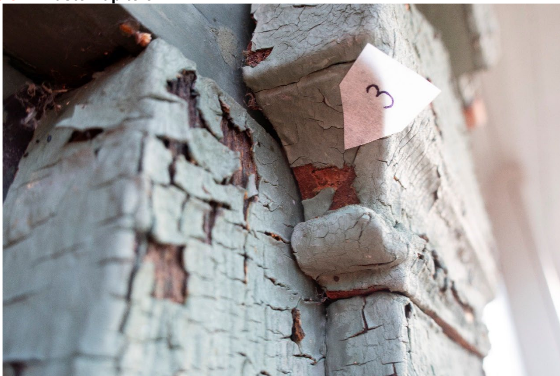
Figur 18 Prøve til tverrsnitt tatt på pilasterens kapitel. Pilen viser plassering av uttaksted. Foto: NIKU, 2022.
