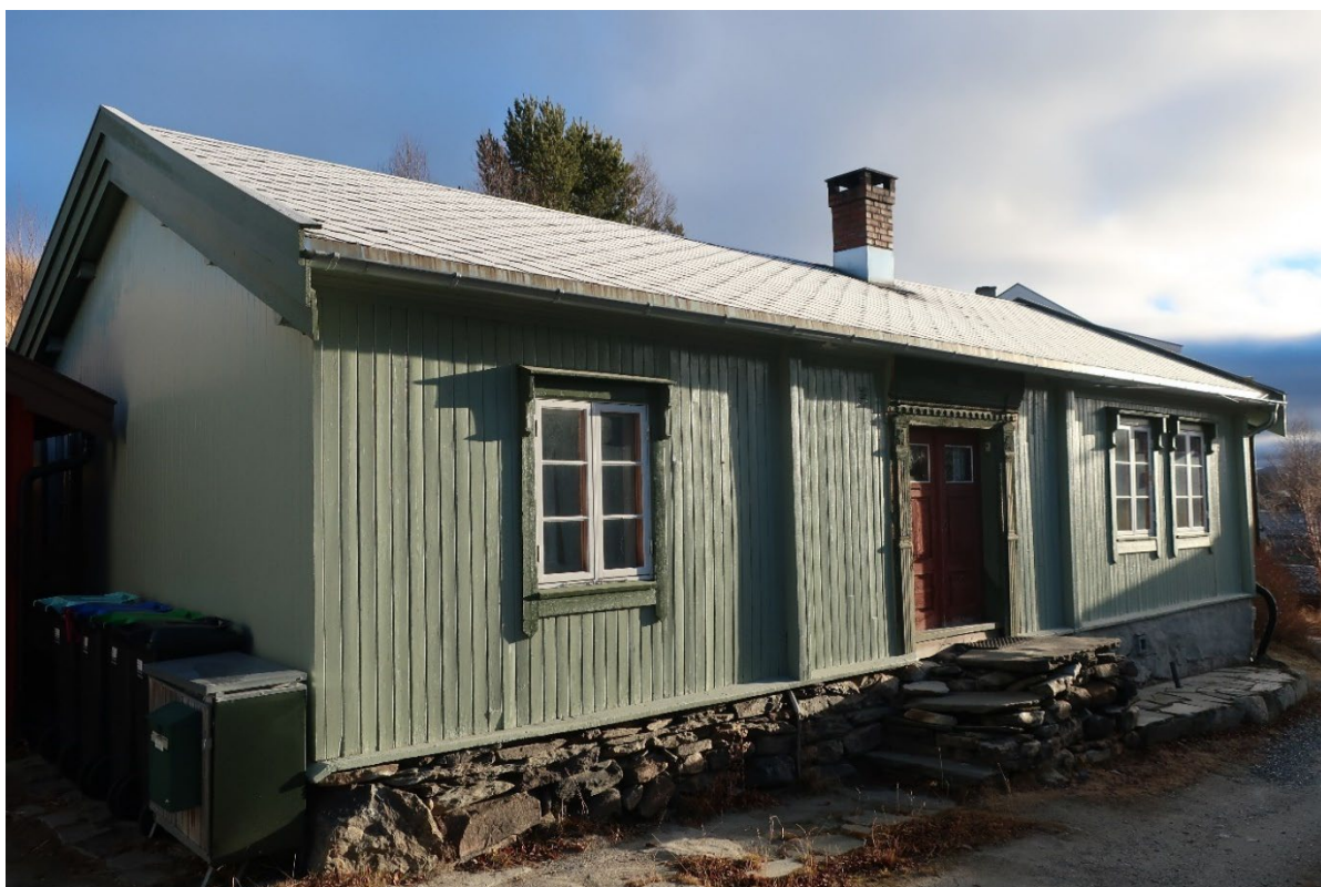
Figur 1 Skansveien 8. Fasade mot sørvest. Foto: NIKU, 16.11.2022.
