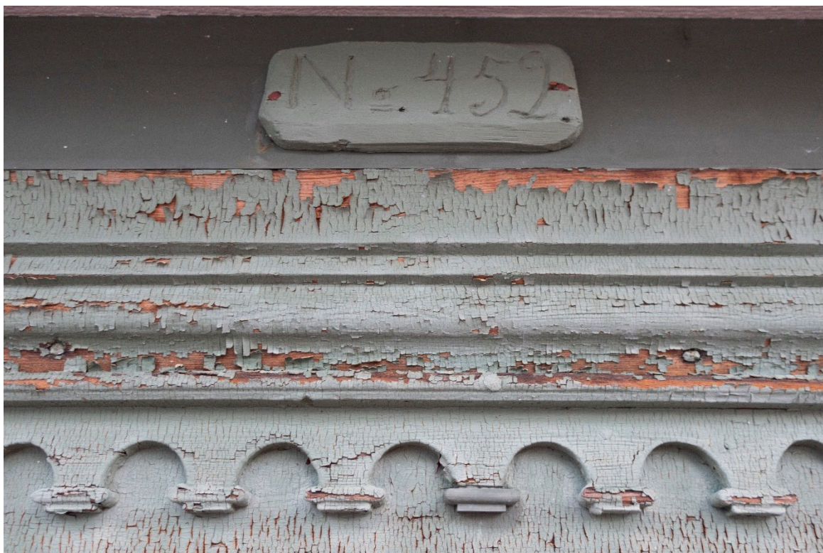
Figur 3 Overligger med kraftig profilering og buelist med profilering nederst. Eldre nummerskilt på sekundært toppstykke. Foto: NIKU, 16.11.2022.
