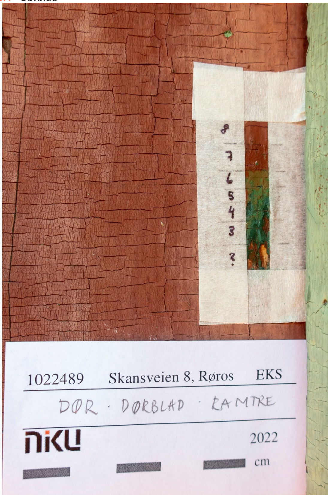
Figur 20 Lagvis avdekking på høyre dørblad. Avdekkingen er gjort på ramtreet til høyre for vinduet, ut mot karmen. Foto: NIKU, 2022.
