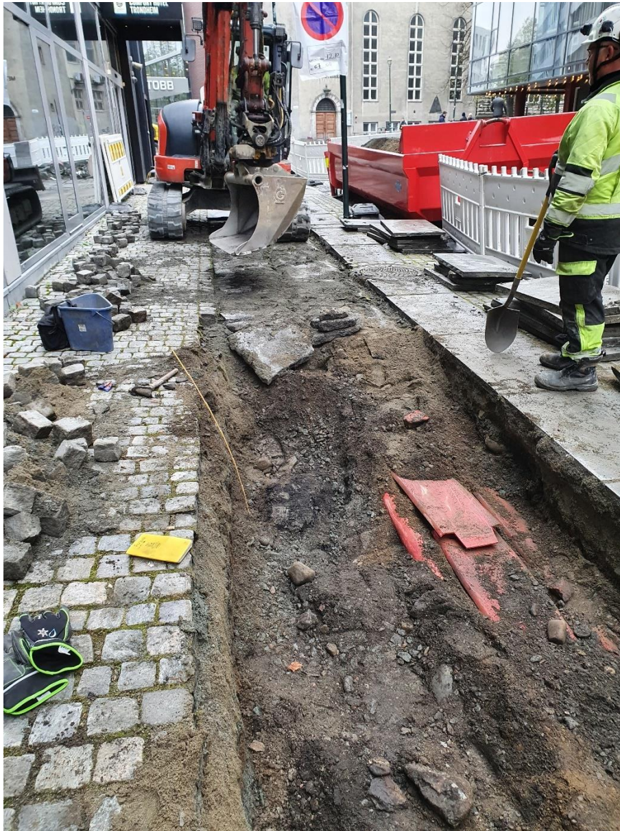
Figur 43: Eksisterende trasé for fjernvarme åpnes. Bilde tatt mot sør.
