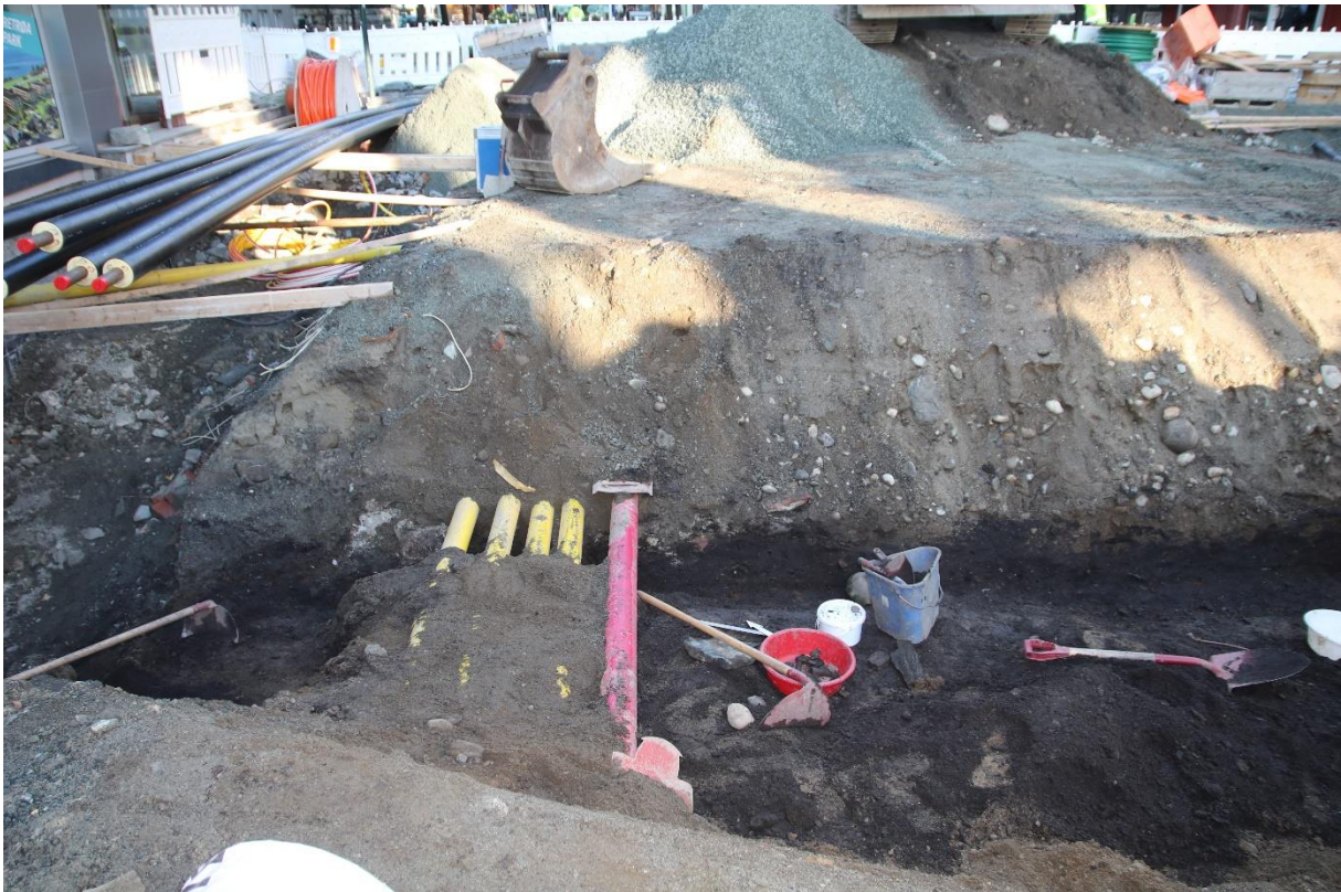
Figur 20: Oversiktsbilde som viser plassering av den øst-vest gående kabeltraséen. Da_62848_099.
