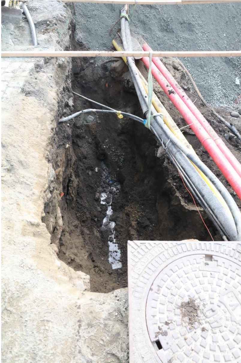
Figur 10: Arbeidsbilde: graving av gammel rørgrøft, sjakt 3 (VK1). Sett mot øst. Da_62848_042.
