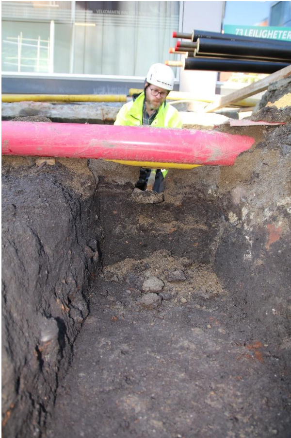
Figur 21: Kulturlag under rørtraséer fjernes. Sett mot sør. Da_62848_101.
