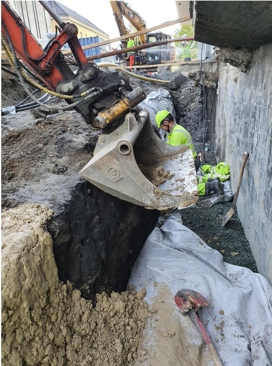
Figur 4: Profil med intakte middelalderske lag nord for Krabugata 1 blir dekket med ikke-marin leire før igjenfylling. Bilde tatt mot øst.
