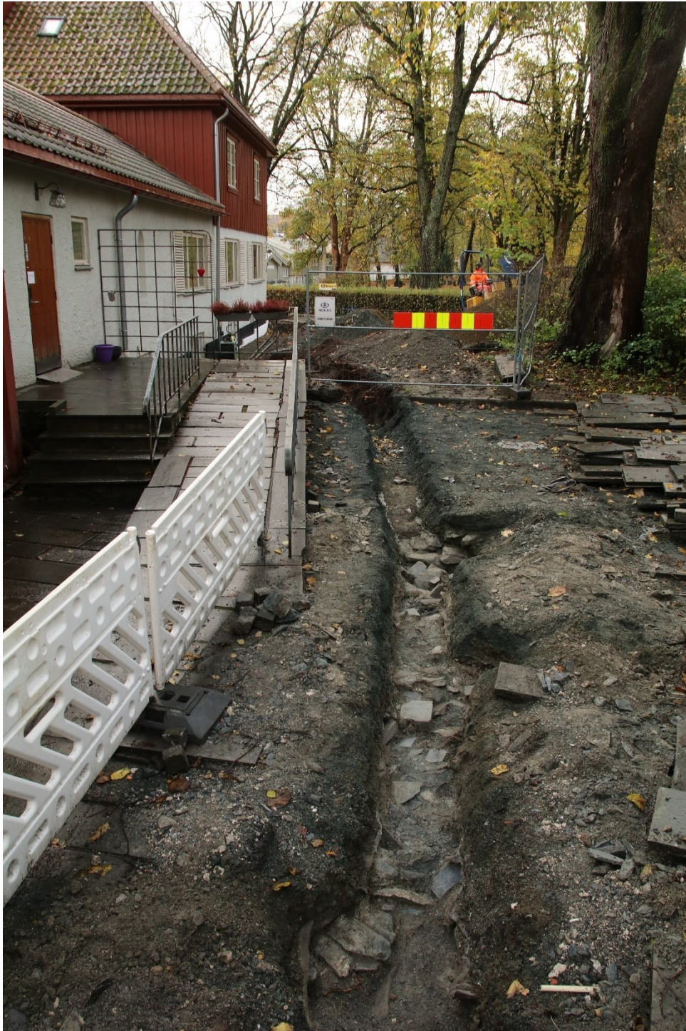
Figur 11. Murresten på vestsiden av bispeboligen, sett mot sør. Da63959_073.
