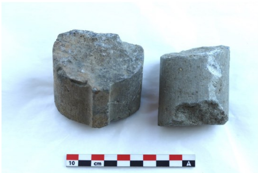
Figur 2. To deler av 'vulstar' fra en rik, gotisk profil, kanskje fra en kveld, en portal eller en vindusomramming. Det ene har et 'pålagt bånd' (eng. fillet) som skaper en rikere lys- og skyggeeffekt. Ø. Ekroll, personlig meddelelse. Foto: NIKU. Løsfunn dreneringsgrøft øst.
