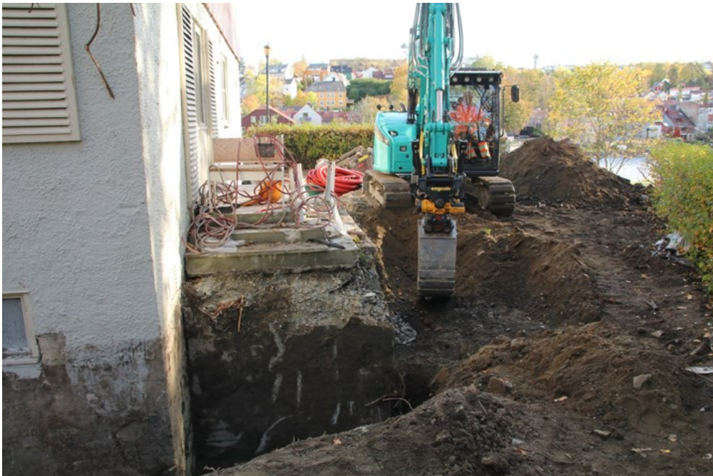
Figur 2. Graving av dreneringsgrøft sør for bispeboligen. Da63959_025.
