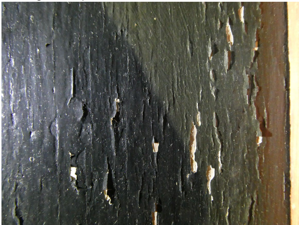
Foto 1: Epitafium, detalj med opp- og avskallinger. Foto: Nina K. Jernæs, NIKU
