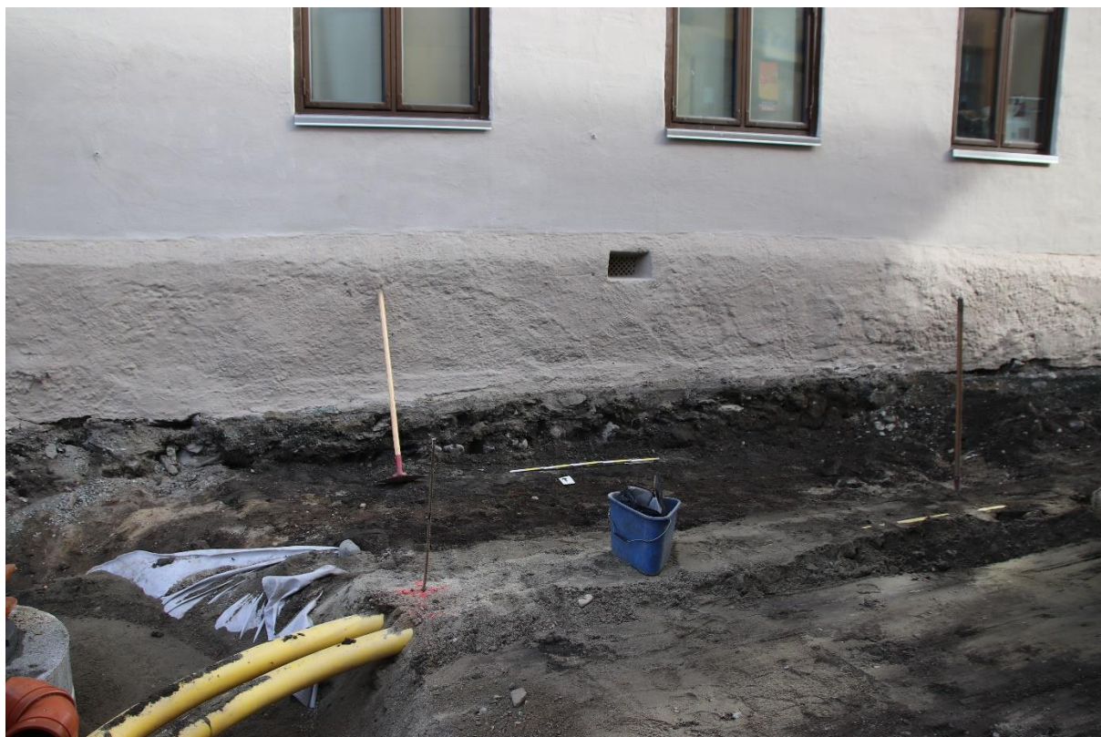
Figur 11. Bevarte parti med mørke kulturlag som ligger inntil fundamentet til Munkegata 17. Sett mot NØ. Da64002_009.
