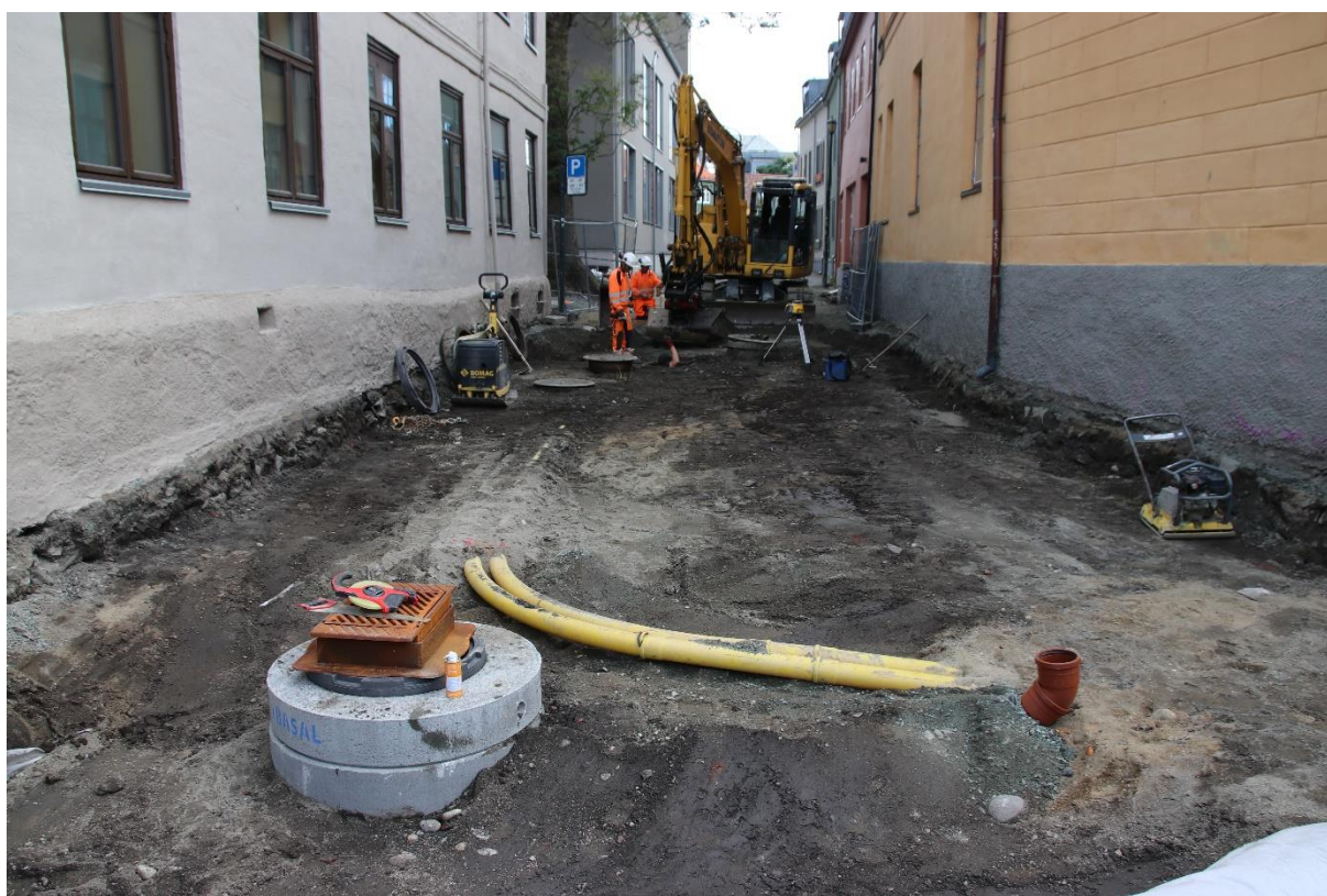
Figur 3. Vestre del av veita etter etablering av ny sandfangkum i gjenfylt Hull 1. Omrørte fyllmasser i moderne ledningsgrøfter synlig i veitas midtparti, mørkere smale striper med intakte kulturlag ved kantene i sør og nord. Sett mot Ø. Da64002_011.
