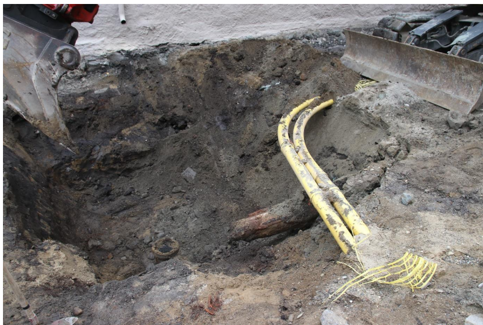
Figur 18. Hull 1 under graving med påvist del av gammelt vannrør i tre. Sett mot N. Da64002_002.
