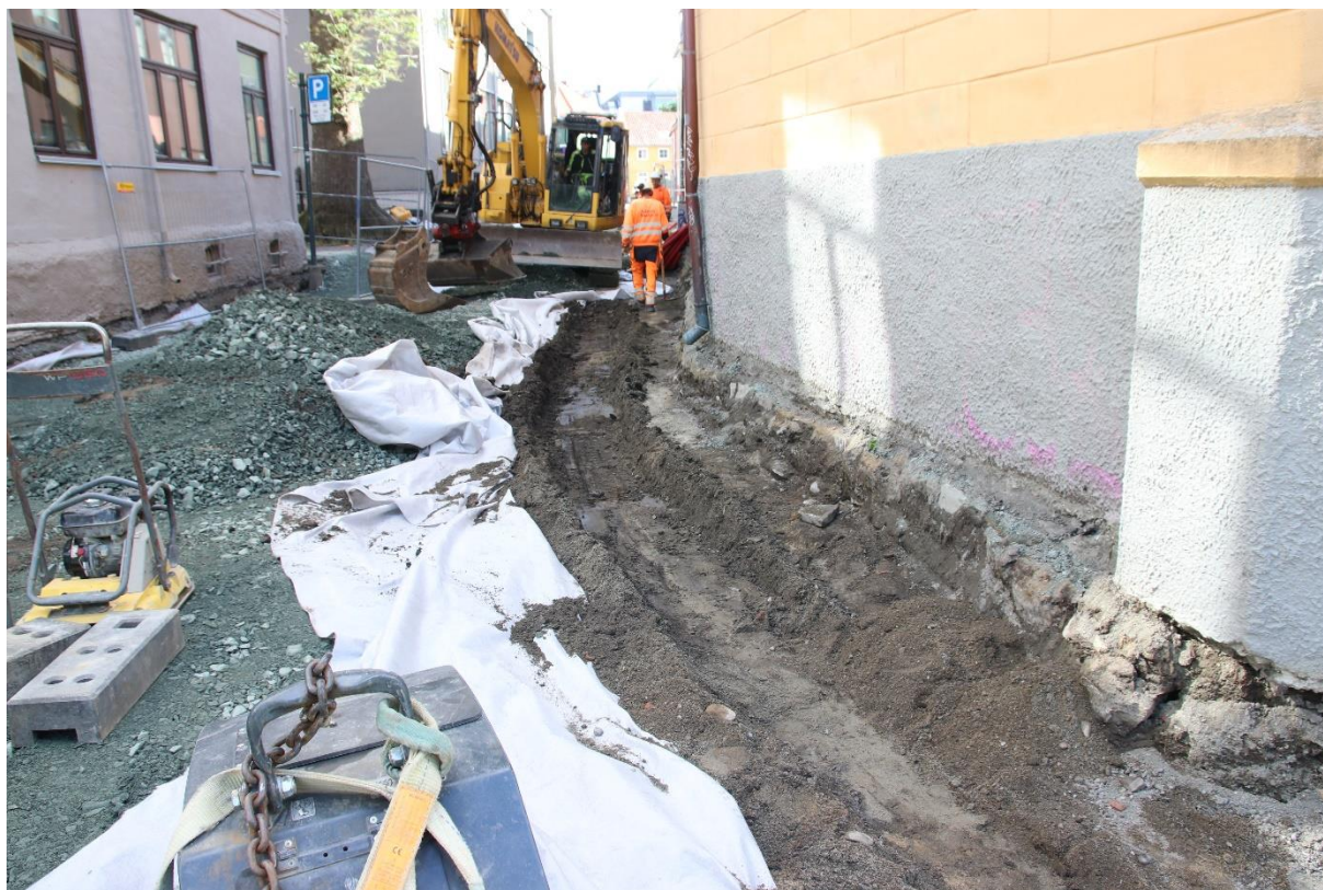
Figur 15. Grøften gravd for gatelys kabel parallelt med fundamentet til Munkegata 15. Sett mot Ø. Da64002_013.
