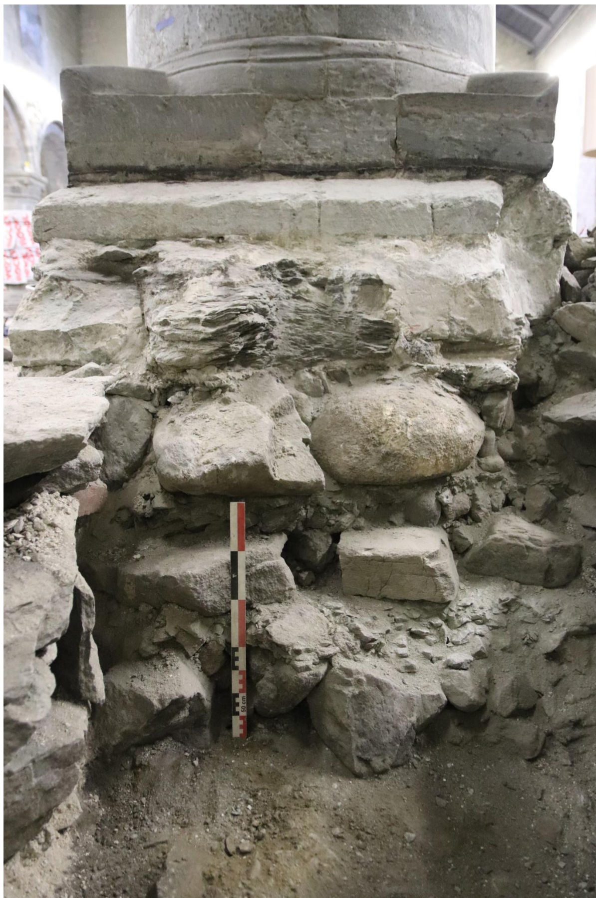
Figur 77. Eksponert fundament på vestsiden av søyle D3. Sett mot Ø. Foto Sf209965.
