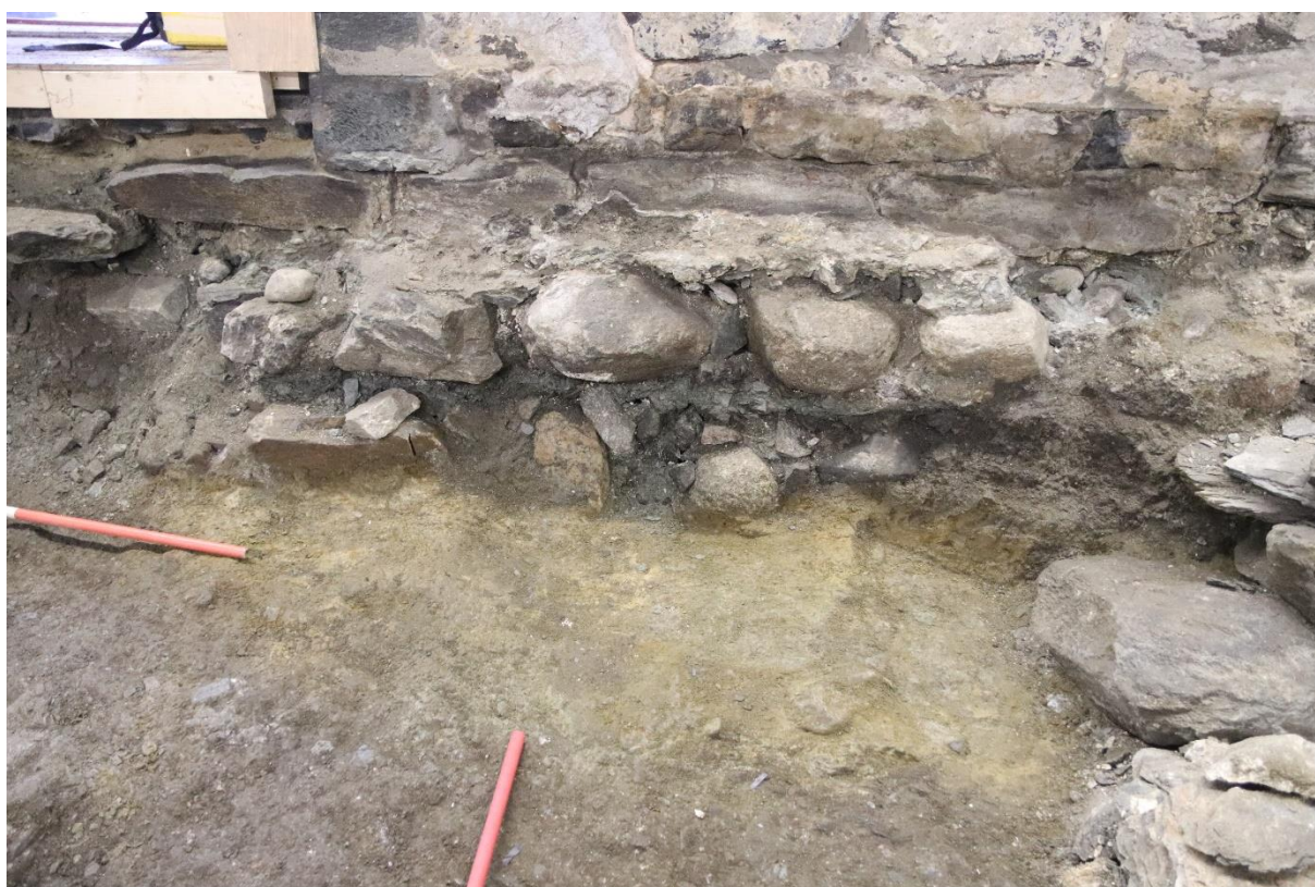
Figur 80. Eksponert fundament på sørsiden av nordveggen i skipet, i kammer A4. Sett mot N. Foto Sf209213.
