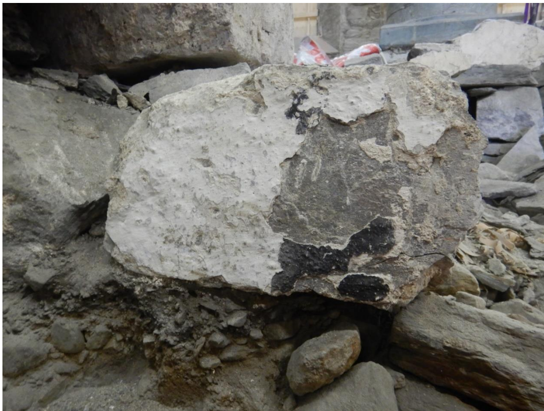
Figur 108. Bygningsstein med flere tynne lag med kalkslemming og hvitting. Et av de underliggende lagene har en mørk farge som kan være innfarging med kjønørk. En annen mulig forklaring er at det er et sotlag fra en brann. Steinen kan komme fra Mariakirken hvor det var store arbeider i 1865. Steinen er tatt ut fra tørrmuren i felt B2 (inv. B2–9). Foto Sf216620.
