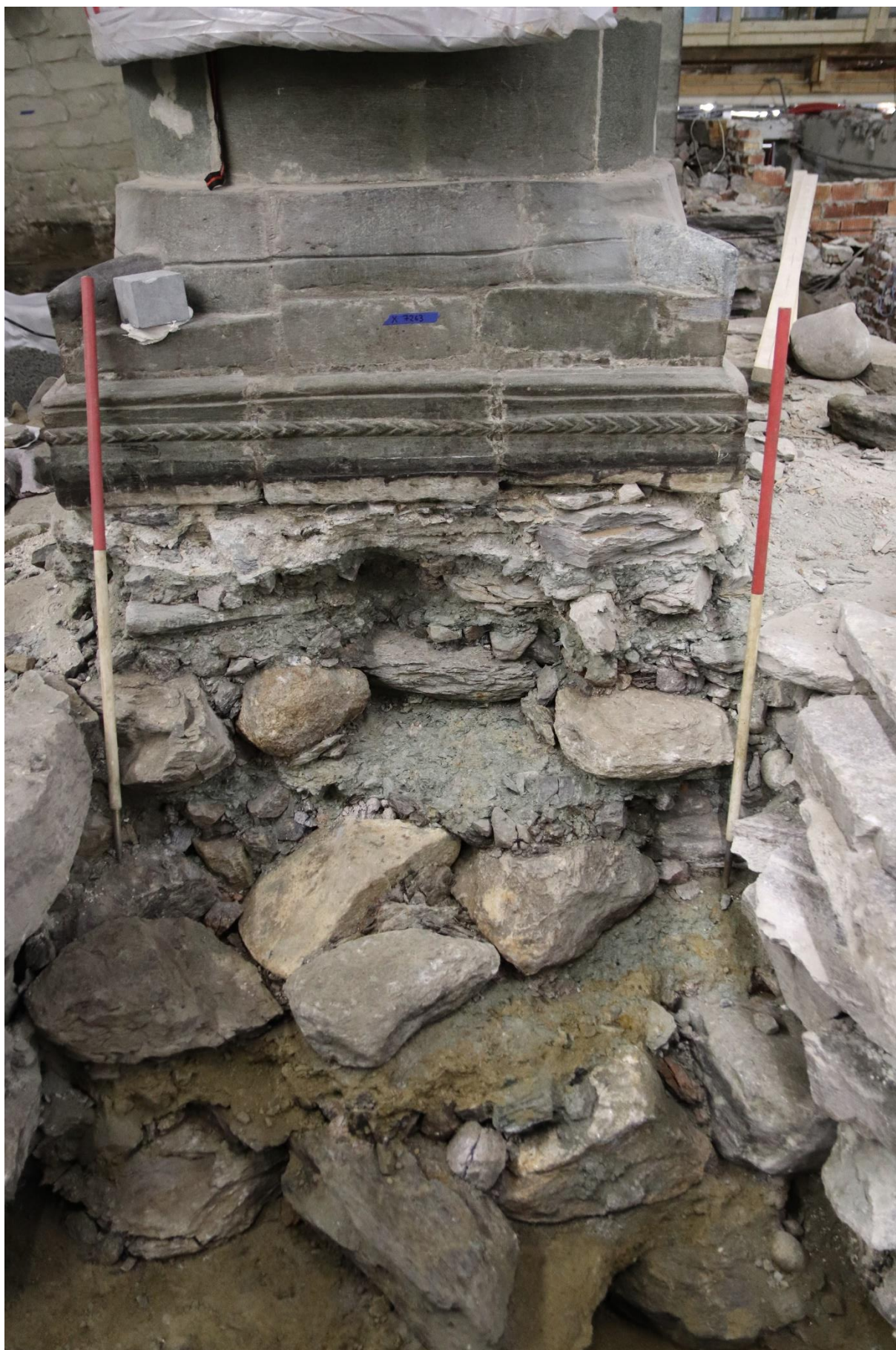
Figur 78. Eksponert fundament på vestsiden av søyle B7. Sett mot Ø. Foto Sf210152.
