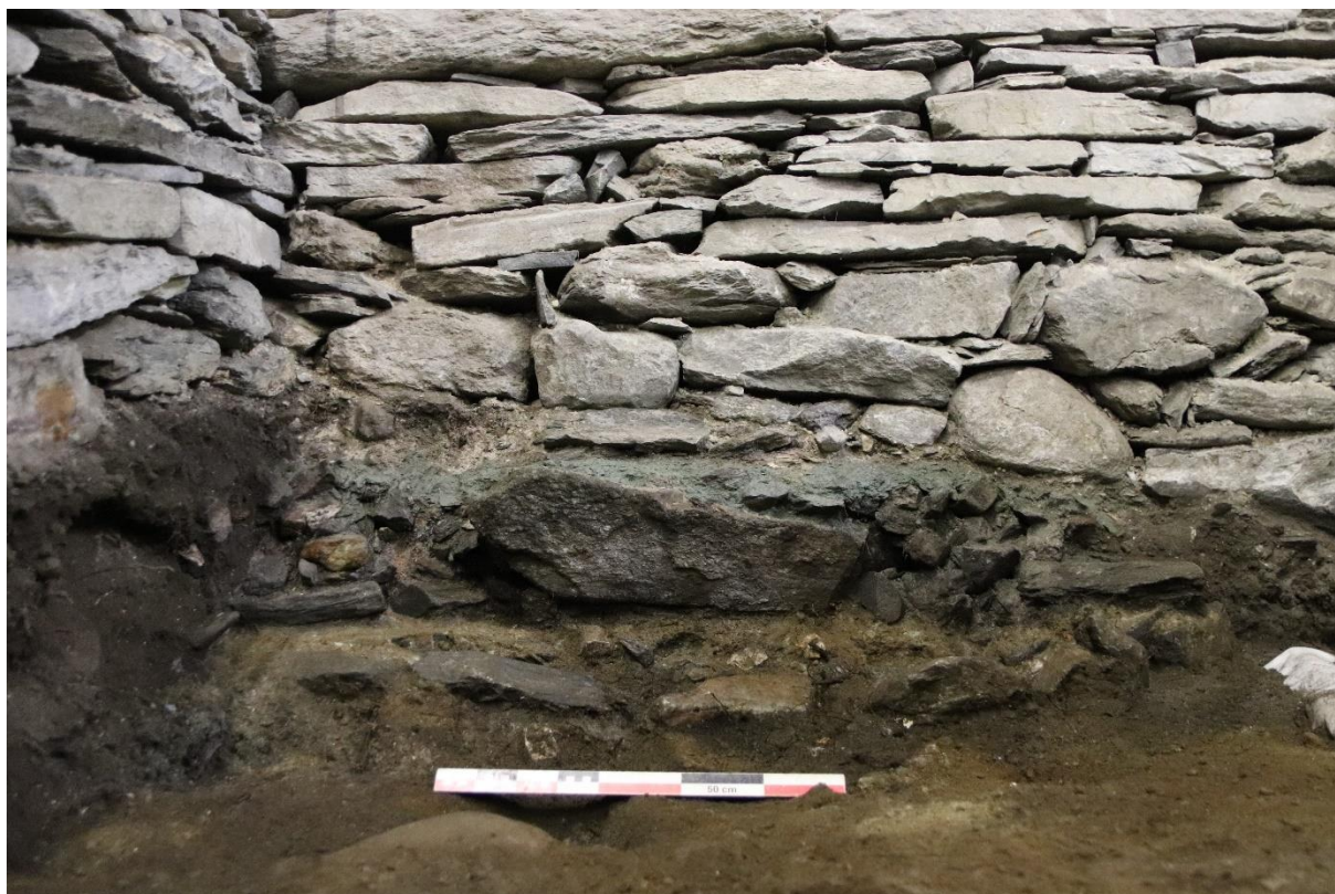
Figur 74. Fundament SA10615 sett i profil mot NV. Foto SF210392.
