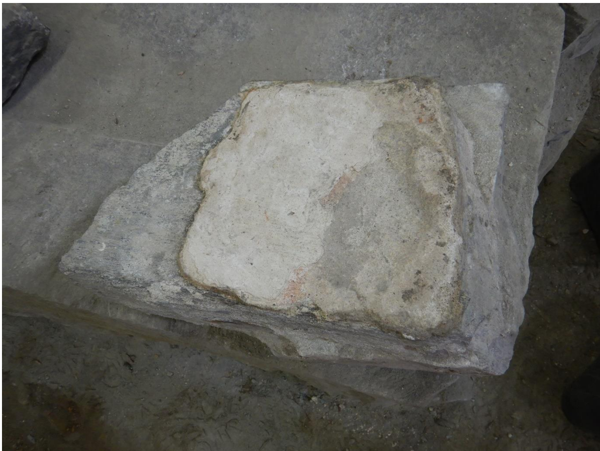
Figur 104. Bygningsstein (inv. B5–5) med flere lag kalkpuss fra tørrmuren i felt B5 i krypkjelleren. Et underliggende lag har en tydelig rødfarge. Foto Sf216621.
