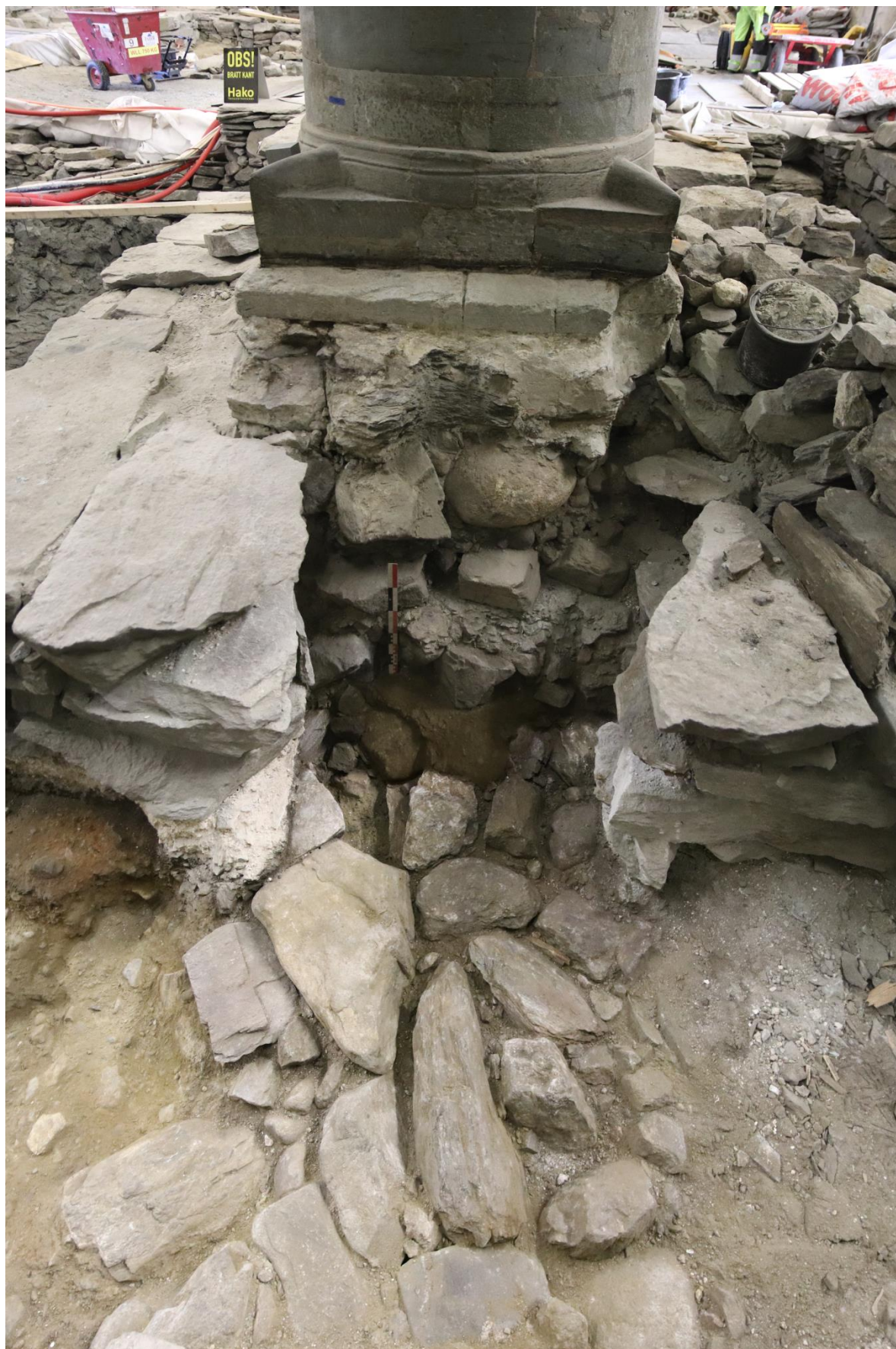
Figur 63. Photomerge-komposisjon av overgangen mellom murfundament SA5727, sand- og gruslag SL7500 og søylefundament for søyle D3. Dette var ett av få steder hvor tørrmuren ble demontert slik at overgangen mellom søylefundament og murfundament ble tydelig. Sett mot SØ. Foto Sf209985–209991.
