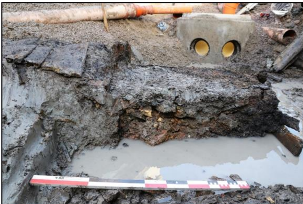
Figur 20. Bilde Cf53873_niku_367 som viser SA1693 under demontering. Massene i brønnen inneholder teglstein og brent mørtel.
