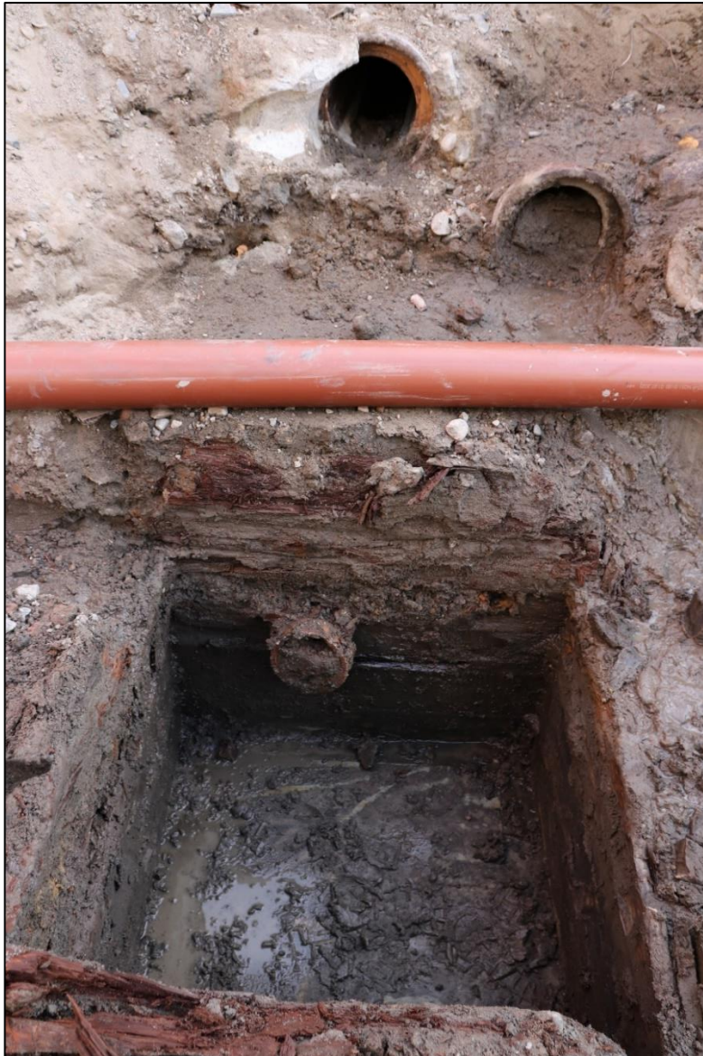
Figur 5. Bilde cf53873_NIKU_0043 som viser S9084 vannfordelingskum i tre fra midten av 1800-tallet som kutter gjennom den eldre brolegging i Telemarksgata. I profilen over ses to tette avløpsrør fra 1900-tallet. Bildet viser omfang og tetthet av nyere inngrep ved krysset Prinsessegata/Telemarksgata ned til ca. 3 meters dybde under gatenivå.
