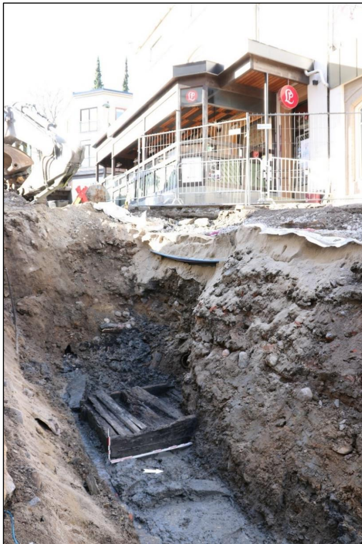
Figur 14. Vannfordelingskum SA1828. Sett mot V. Cf53873_NIKU_924854.
