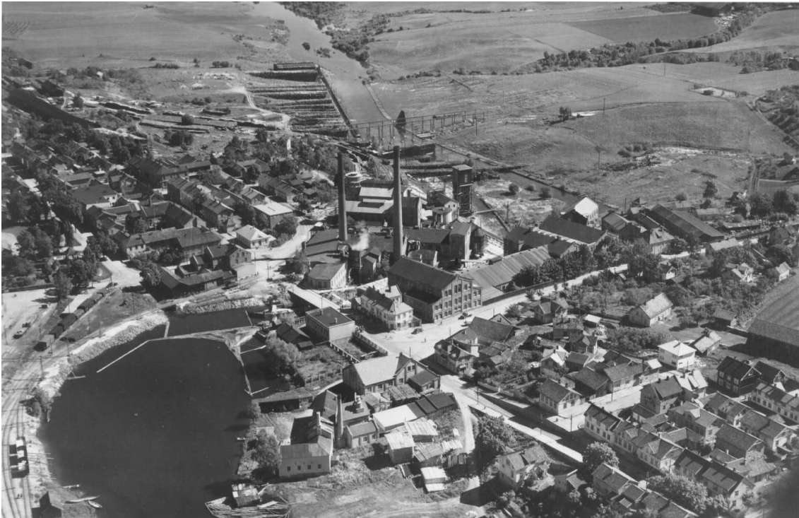
Fabrikkgata, flyfoto slutten av 1940-tallet - Hollenderigården med papirfabrikk, smie og kraftstasjon
