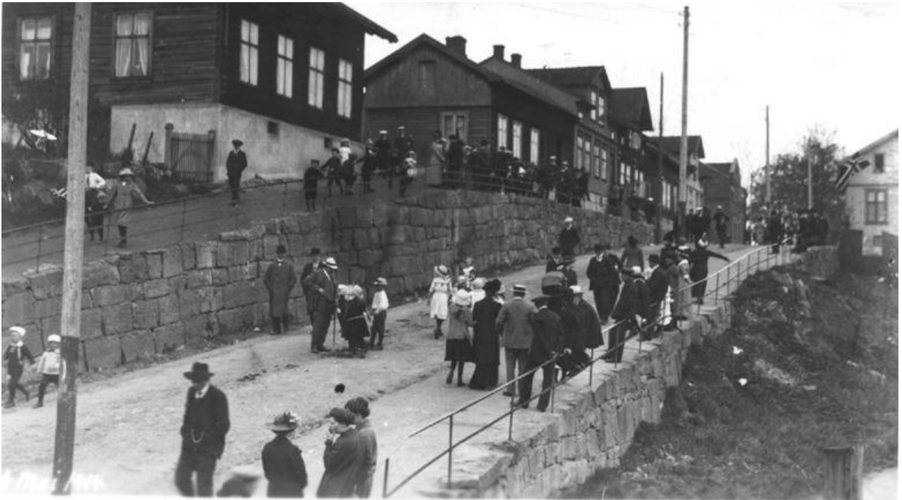
Veien inn til Vestfossen sørfra hadde tidligere gått i en bue som fulgte terrenget. Nå ble den rettet ut. Dette medførte at det måtte bygges støttemurer for å ta opp høydeforskjellene i terrenget. Bebyggelsen som ble oppført langs Råenbakken etter reguleringen, retter seg etter det nye gateløpet. Kilde: Eiker Arkiv
