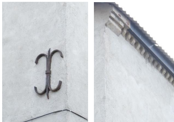
Bygningen har fine bygningsdetaljer som forseggjorte murankre og gesims.
