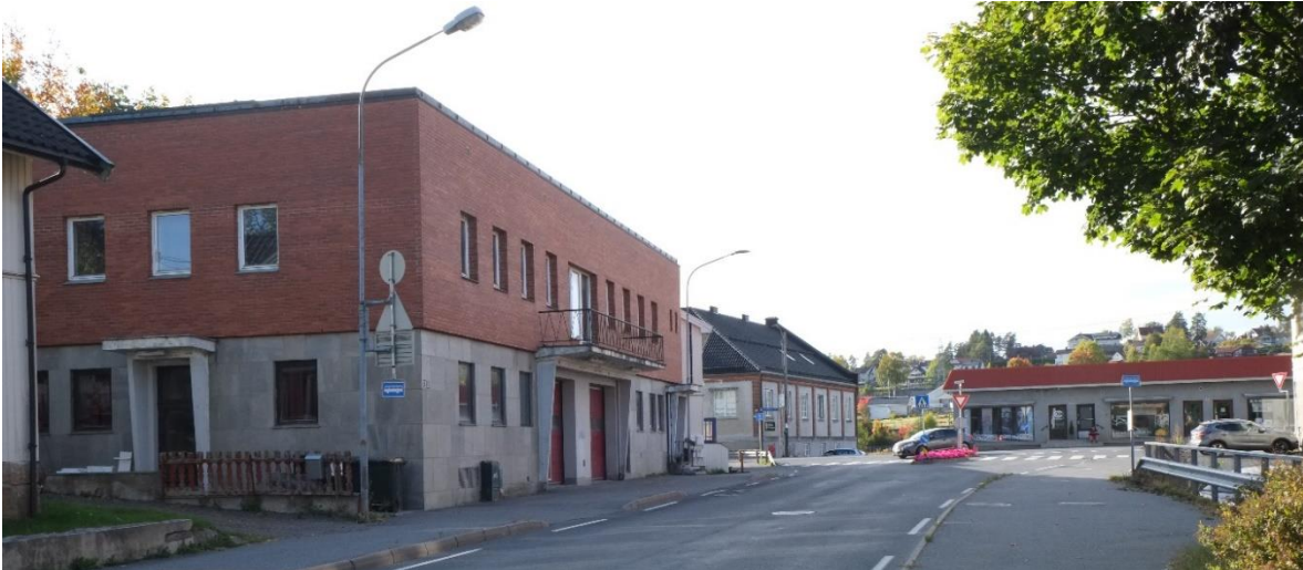
Forsamlingshus til venstre med tidligere brannstasjon i første etasje. Foto: NIKU
