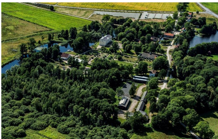
Huseby bruk i Småland, Sverige. Miljøet rundt bygningen er gjenoppbygd som et tiltak for å håndtere vannproblematikk. Foto: L.G.foto/Wikimedia Commons/CC BY-SA 4.0.
