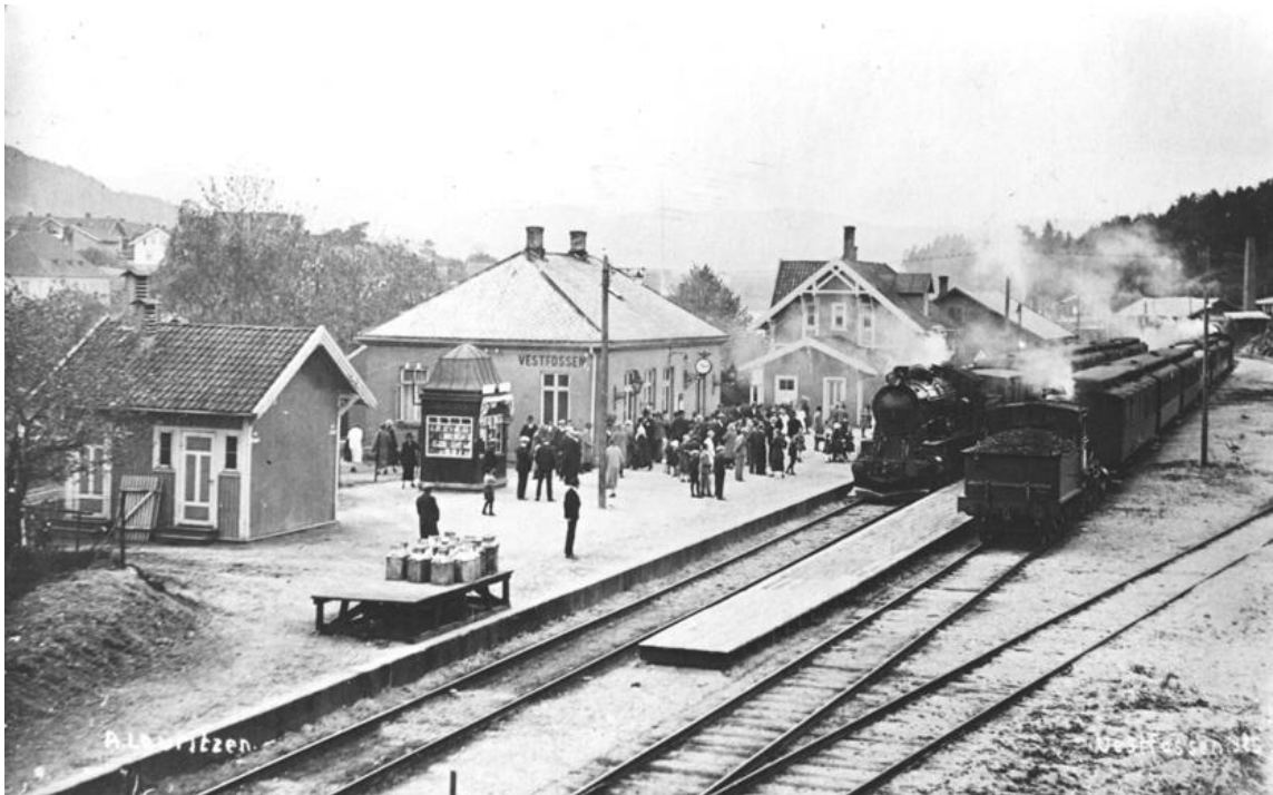
I 1910 fikk Vestfossen ny jernbanestasjon, oppført i mur ved siden av den eldre stasjonsbygningen i tre. kilde: Eiker Arkiv
