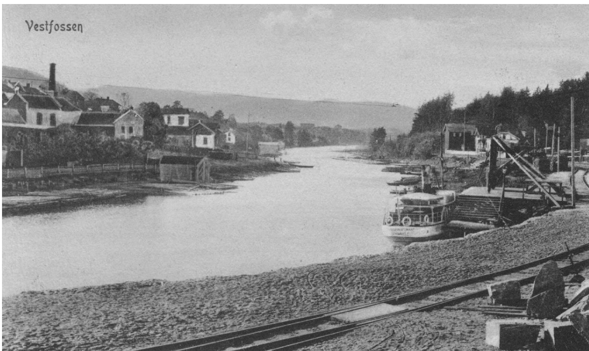
Elva og Eikern var viktige som kommunikasjonsårer. Bildet viser Vestfosselva sørover mot Eikern. Til venstre ses Bryggeriet med pipe. I forgrunnen jernbanespor. Kilde: Eiker Arkiv
