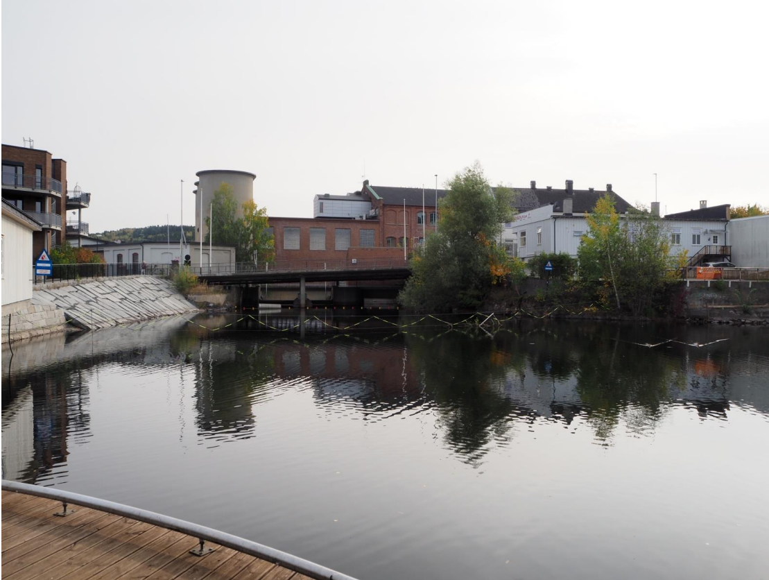
Vestfossen der veien krysser elva. Industribebyggelsen sett fra Hølen i dag. Til venstre gjenværende deler av cellulosefabrikken, i midten siloene fra rundt 1950 og til høyre hollenderiet fra 1912.
