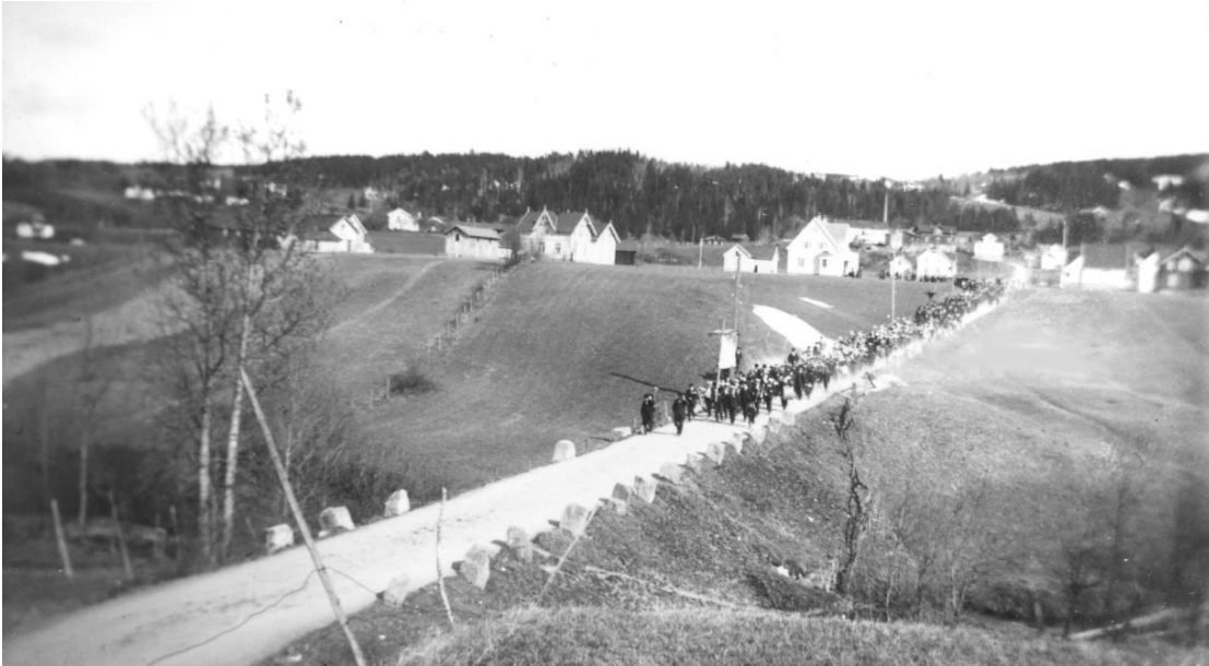
Boligutbygging, i regi av Fredfoss fabrikk, kilde: Eiker Arkiv
