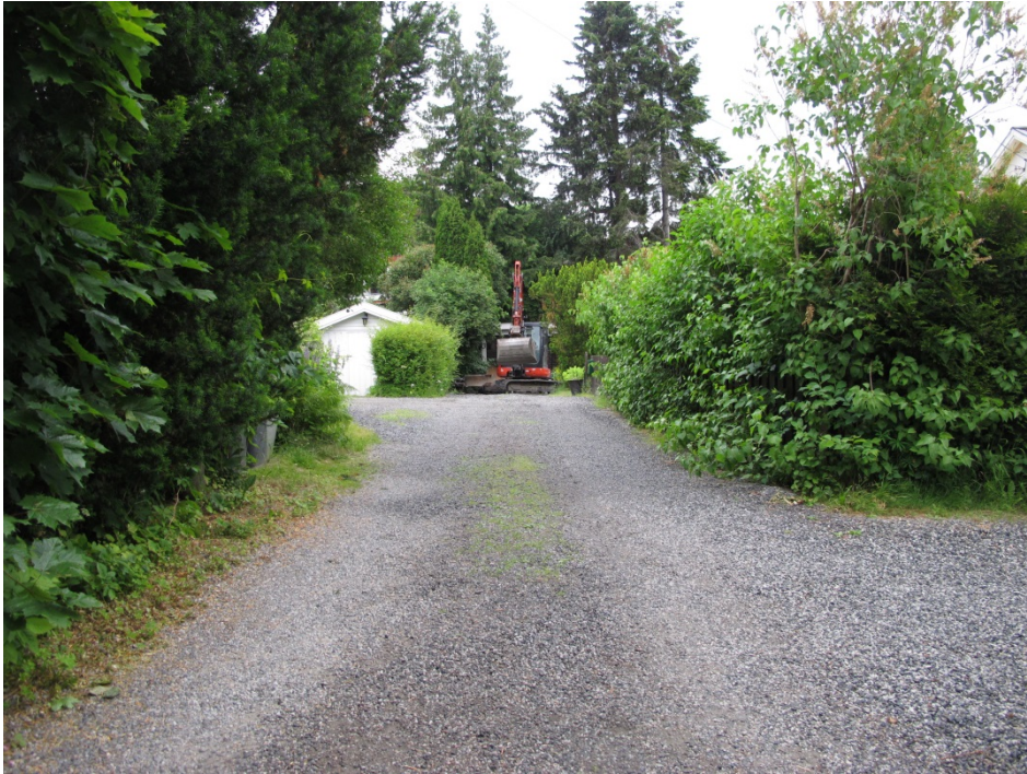
Figur 34 Adkomst fra sentralrom til mindre plassdannelse ved Abbediengvn 12. I enden adkomst til Abbediengvn. 5 og 3
