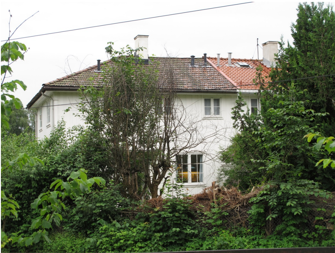
Figur 44 Abbediengvn. 5 og 7 – sett fra Lilleakerbanen
