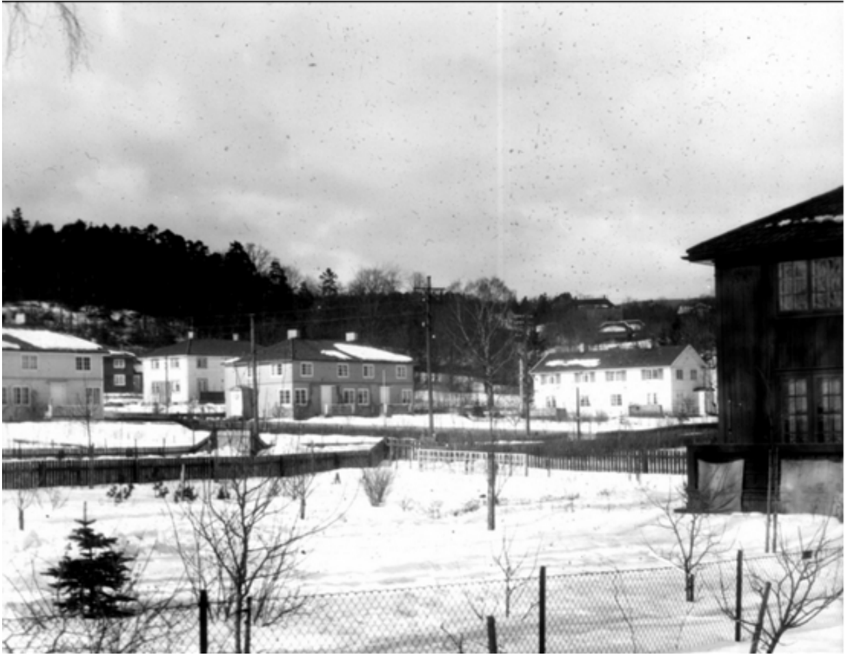
Figur 22 Nedre Abbediengen villakvarter, sett fra Harbitzalleen 11 – slik det ble bygget. foto: Wilse
