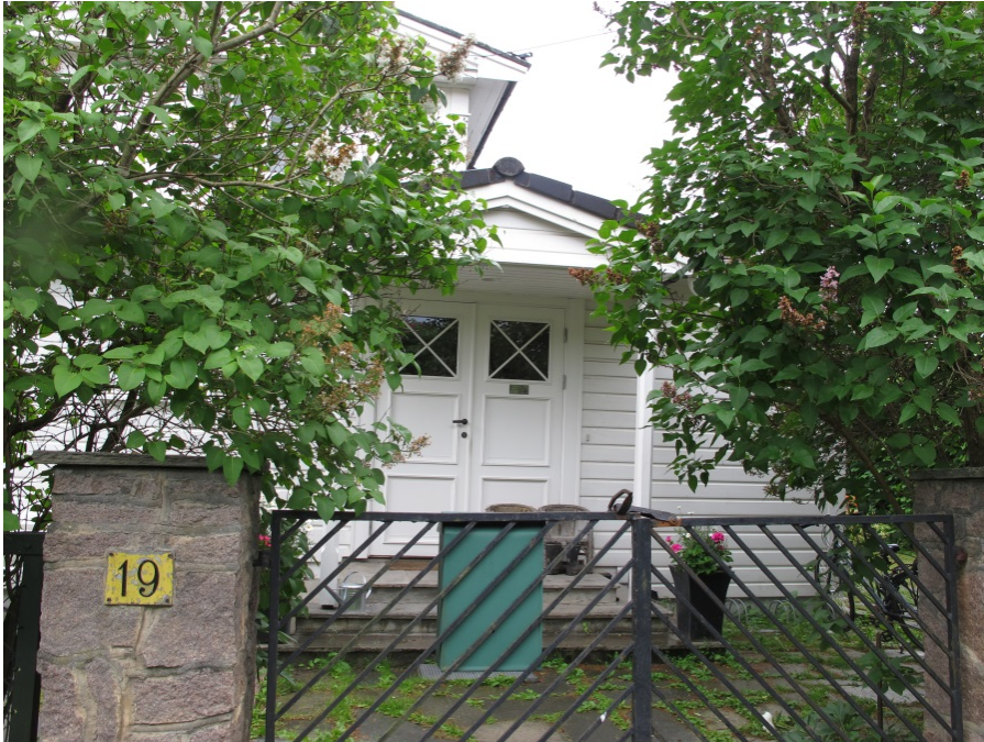
Figur 60 Inngang nr 19. Nytt utvidet inngangsparti i endegavl som kopierer original detaljering - gavlmotiv og kryssvindu.
