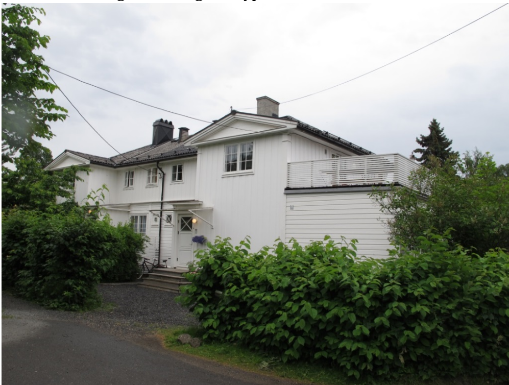
Figur 51 Abbediengveien 11 og 12 – gårdsfasade med bislag - tidligere kjøkkeninngang – her gjort om til hovedinngang for Abbediengveien 11 (på grunn av tilbygg)
