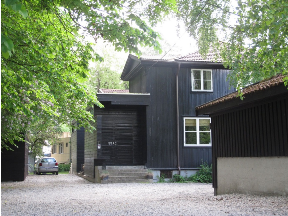
Figur 62 Adkomst Harbitzallè 11. Tilbygg fra 2005 som viser utvidelse av inngangsparti i 9 og 11, med risalittene intakt.
