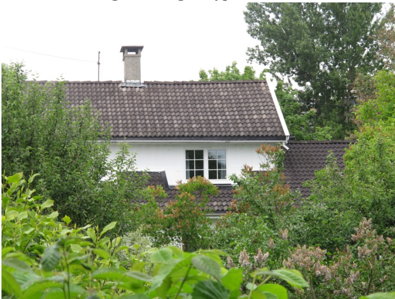
Figur 49 Abbediengveien 1 – med saltak. Fasade mot hage. Tilbygg 1.etasje
