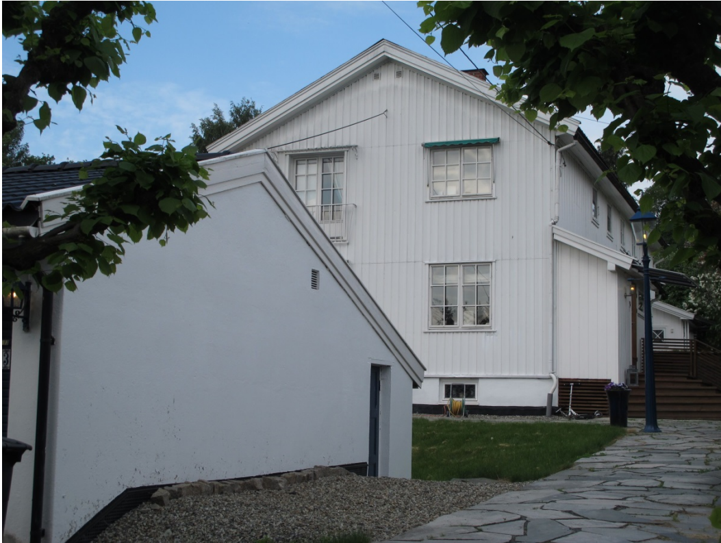
Figur 42 Gavlfasade Harbitzalleen 13, sett fra adkomst fra Abbediengveien. Lite tilbygg ved inngang.
