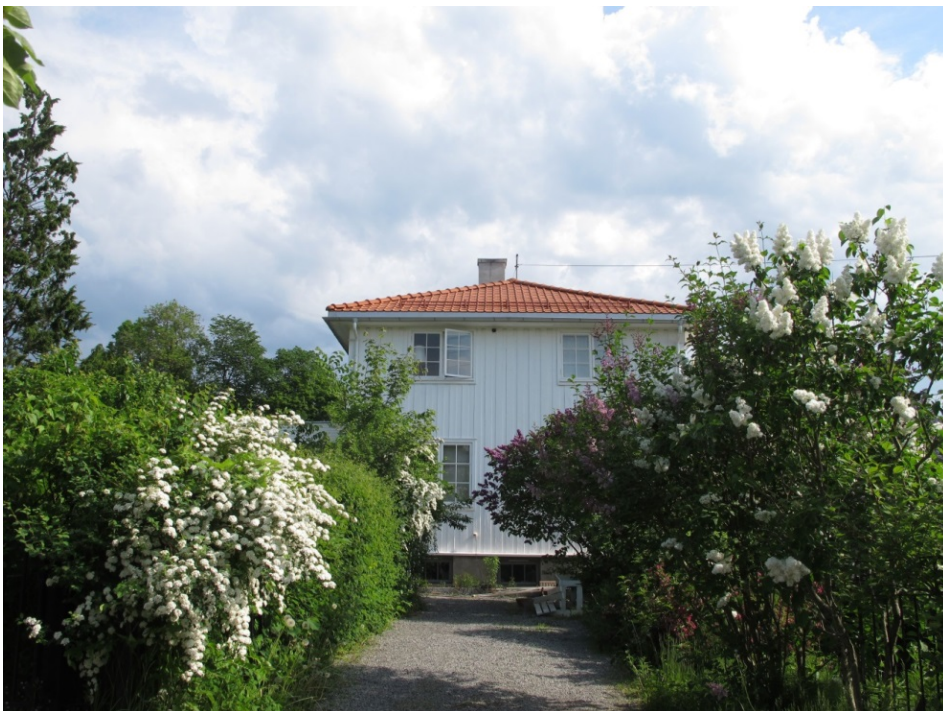
Figur 45 Abbediengveien 7 – adkomst fra sentralplass
