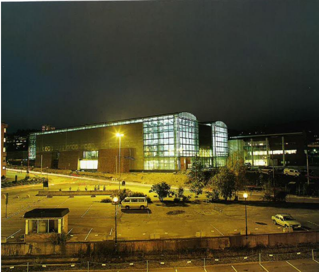
Foto fra Byggekunst som viser anlegget om kvelden. Nattbildet viser hvordan hallene lyser opp i mørket, mens L-blokken er mer dempet. Kilde: Byggekunst 1999
