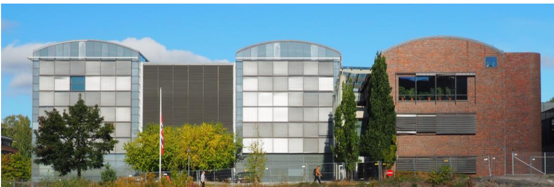
Anleggets karakteristiske silhuett, sett fra syd, med taklandskap med flere buer - pressehallenes glassfasader og L-blokkens gavl i tegl Foto: NIKU
