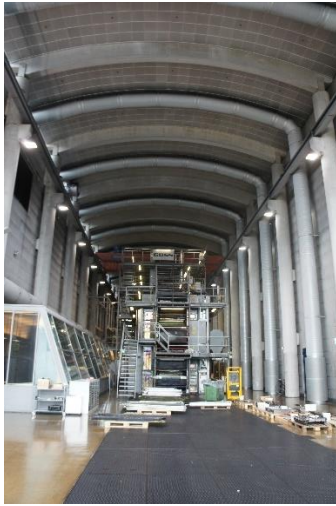
Interiør i de høye pressehallene med betongsøyler og buet tak med betongdragere (til venstre), utsyn gjennom glassvegg mot syd (i midten), og teglpartier i fasade mot Sandakerveien (til høyre). Foto: NIKU
