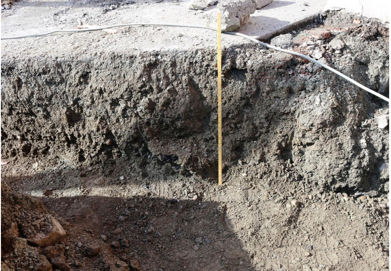
Figur 5. Mindre grøft på det vestlige området gravd for tilkobling eksisterende rør. Rasleira kan skimtes i bunn av sjakten til venstre i bildet. Målestokk 1 m. Da62828_NIKU_15.
