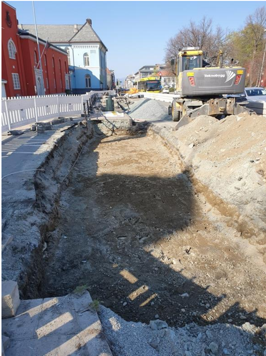
Figur 4. Etter graving av sjakt for fundament til leskur, gravedybde ca. 70 cm. Merk rester av rasleire i det nederste hjørnet til venstre. Tatt mot nord. NB: Bildet er tatt med mobilkamera.
