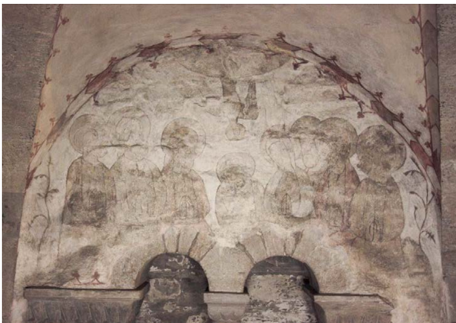
Figur 10: Løse kalkslemmingslag. Tingvoll kirke. Foto: Susanne Kaun
