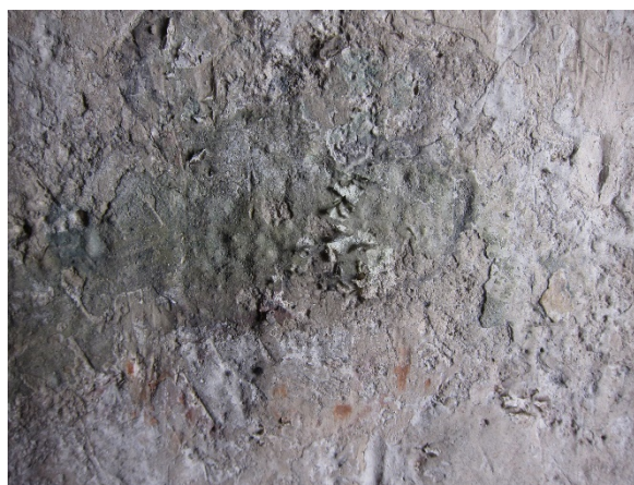
Figur 9: Oppskallinger. Nes kirke i Telemark. Foto: Susanne Kaun
