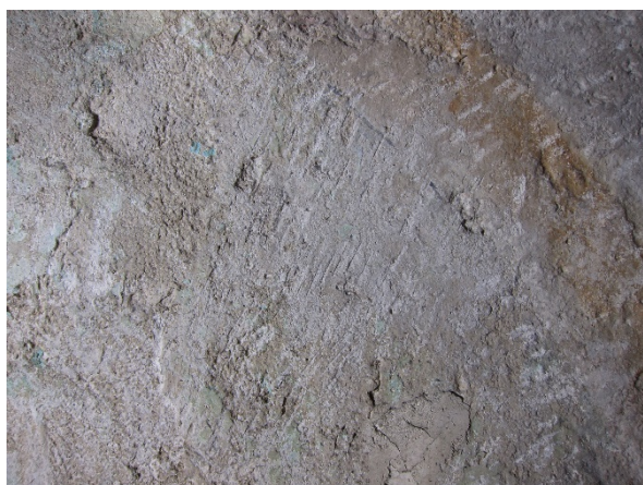
Figur 8: Typiske hakkspor etter avdekningen. Nes kirke i Telemark. Foto: Susanne Kaun
