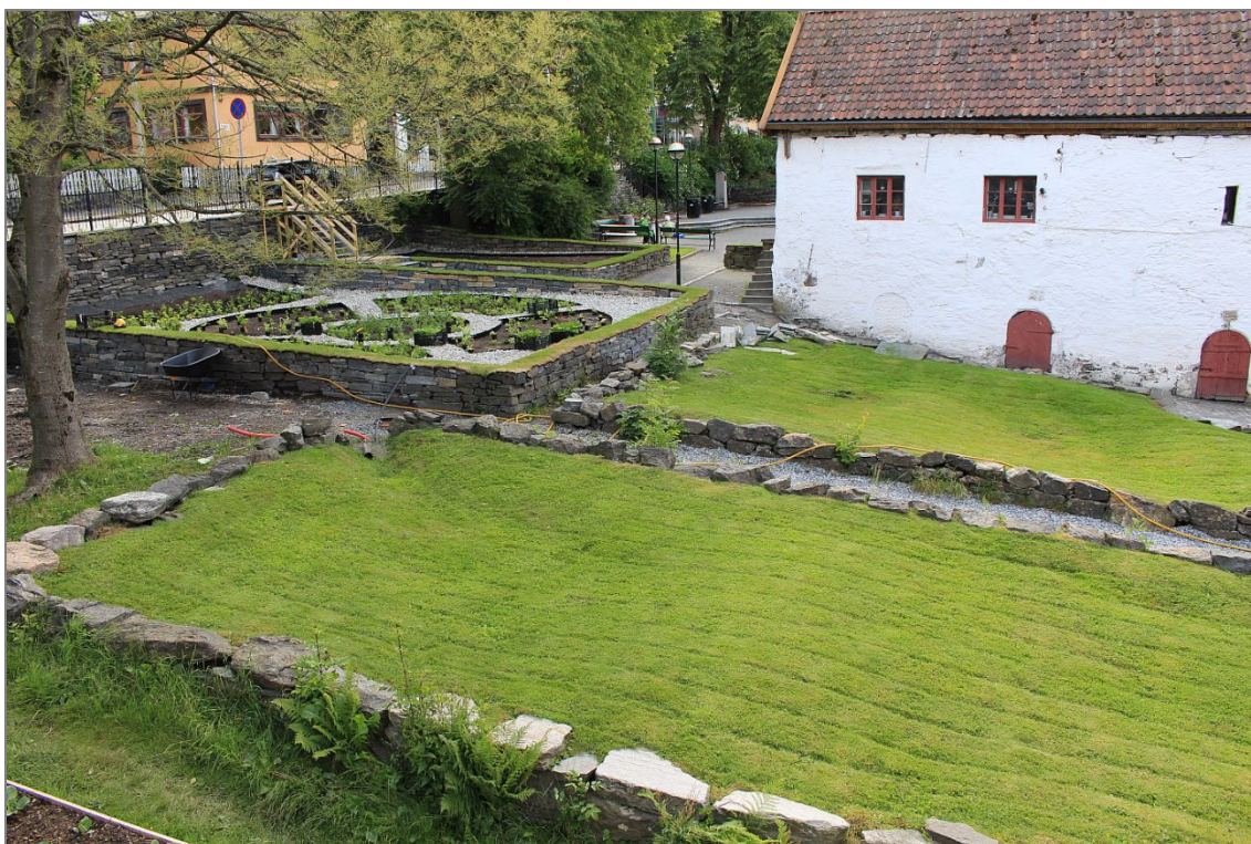
Figur 30. Regnbed og infiltrasjonsbed ved Bryggen. Foto: Dunlop, NIKU 2021.
