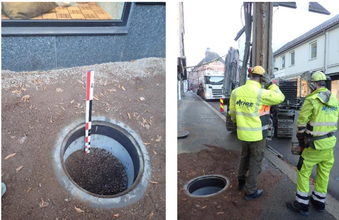
Figur 15: Bilder fra feltarbeidet før oppstart av boringen av miljøbrønn TO1. Tv.: Forhåndsinstallert kum. Th.: Boreriggen klargjøres.
