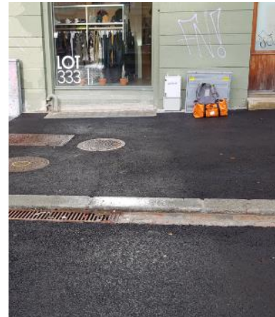
h) Ferdigstilt installasjon
