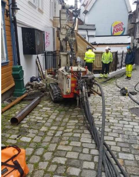
a) Borerigg og sensor installasjon
