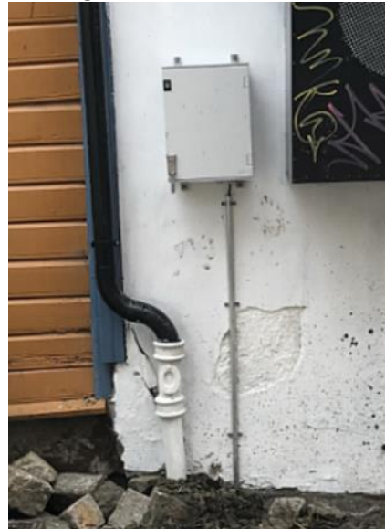
d) Ferdig montert installasjon
