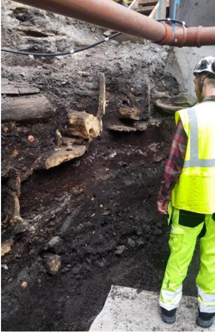
b) Sensor installasjon
