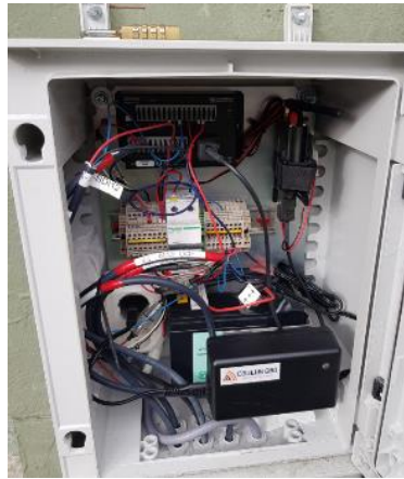
g) Ferdig montert skap på veggen
