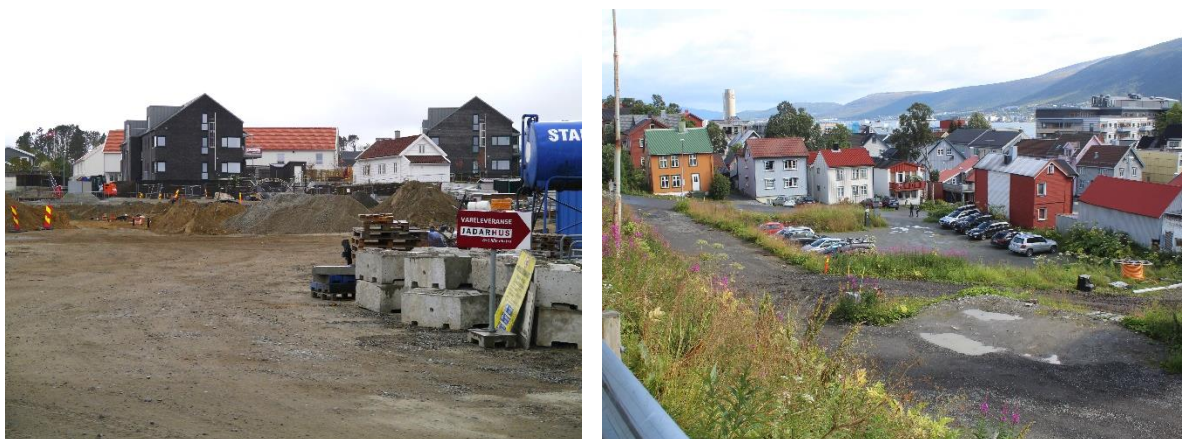
Rivningstomter etter SEFRAK-bygninger i Sandnes og Tromsø. Riving er registrert som tapsårsak for 43 % av bygningstapene i undersøkelsen, mens 30 % av tapene skyldes forfall. Foto: SL/NIKU 2017, RM/NIKU 2016
