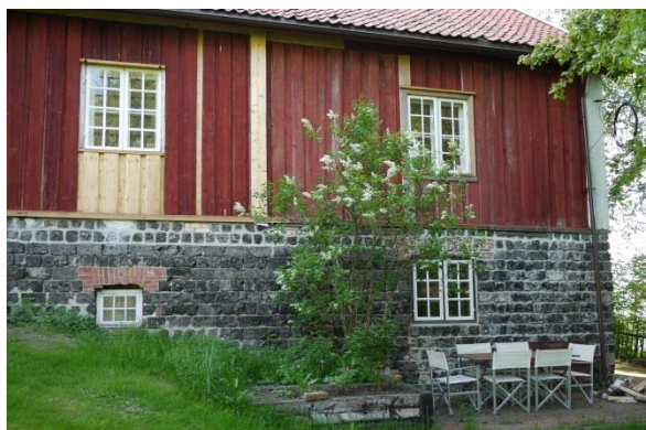
Vedskåle i Nord-Aurdal og våningshus i Nittedal. Ny taktekking (venstre) er registrert som C-endring, mens nytt panel, listverk og vinduer av samme type som før (høyre) er registrert som ingen endring. Foto: RM/NIKU 2015, ÅD/NIKU 2016
