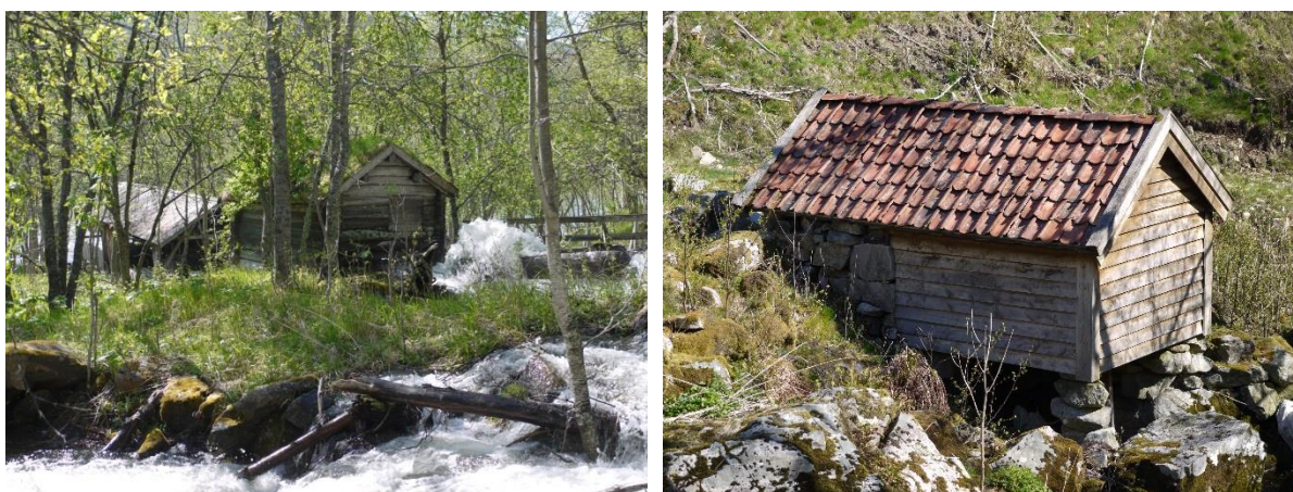
Kvernhus i Saltdal kommune og Sandnes kommune. Foto: ÅD/NIKU 2017
