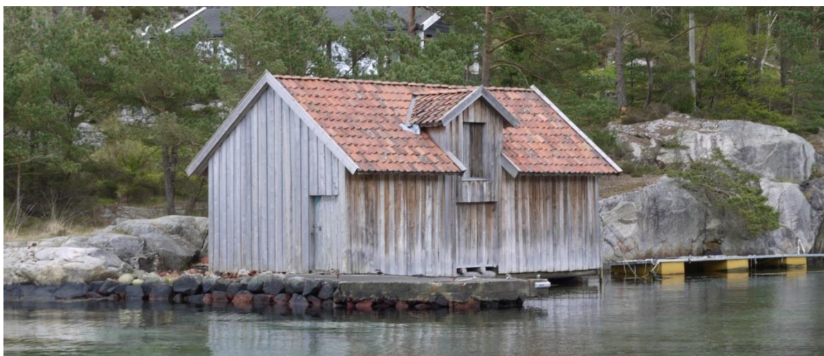
Naust i Tromsø kommune og Sandnes kommune. SEFRAK-bygninger i god stand. Foto: ÅD/NIKU 2016/2017
