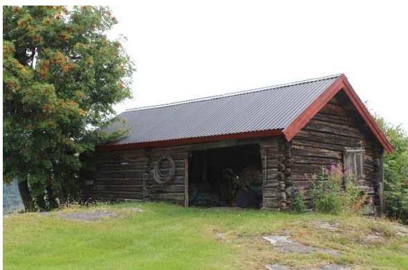
Vedskåle i Nord-Aurdal og våningshus i Nittedal. Ny taktekking (venstre) er registrert som C-endring, mens nytt panel, listverk og vinduer av samme type som før (høyre) er registrert som ingen endring. Foto: RM/NIKU 2015, ÅD/NIKU 2016
