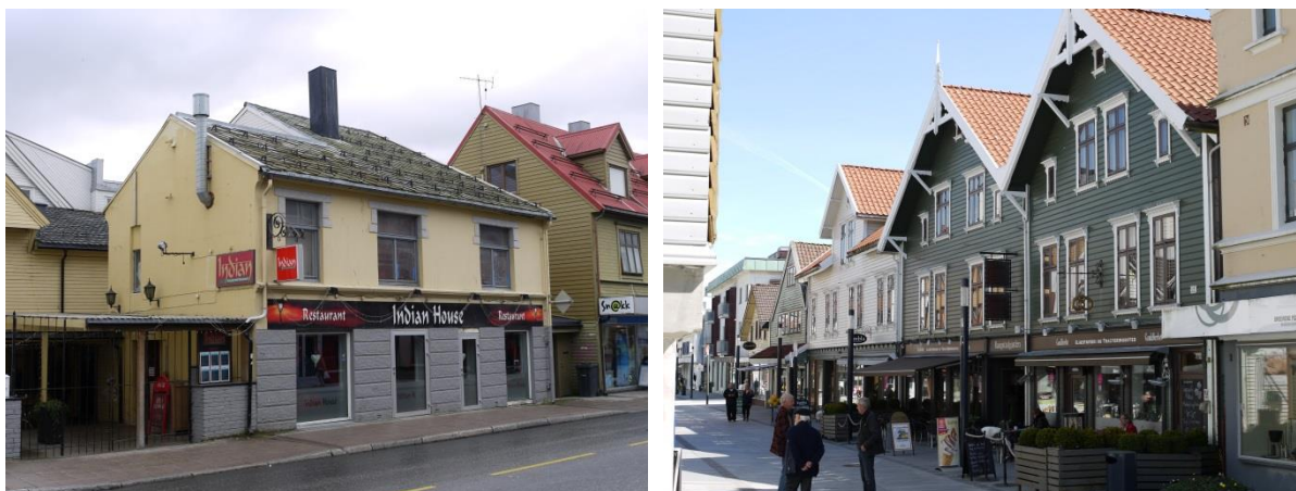
Bygårder i Tromsø og Sandnes. Det akkumulerte tapet av SEFRAK-registrerte bygårder er på 15 % og klart lavere tapsandelen for alle bygningstyper (28 %). Foto: ÅD/NIKU 2016/2017
