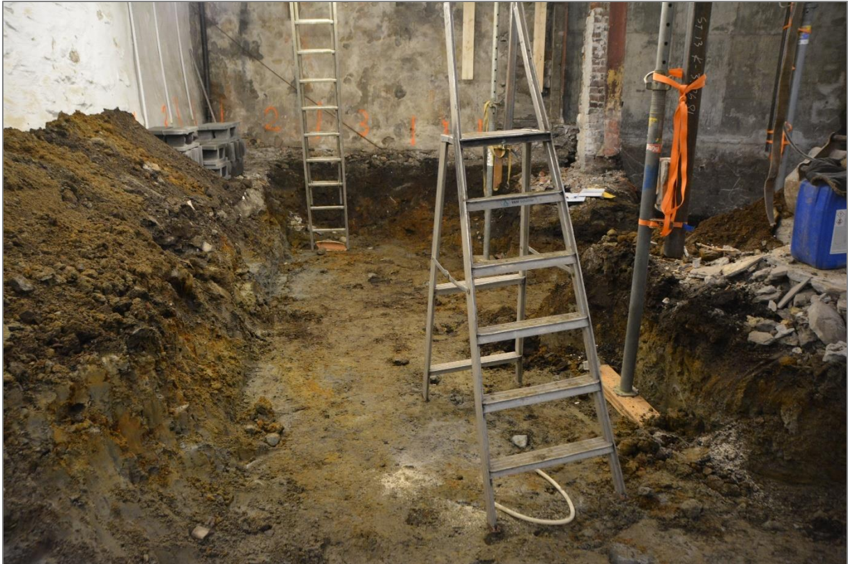
Figur 4. Foto SF211786 Øvre kjeller gravd ned til avtalt nivå.
