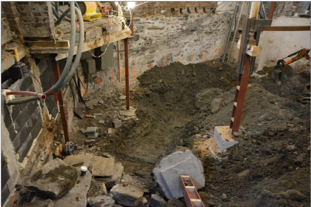
Figur 5. Foto SF211786 Nedre kjeller gravd ned til avtalt nivå.
