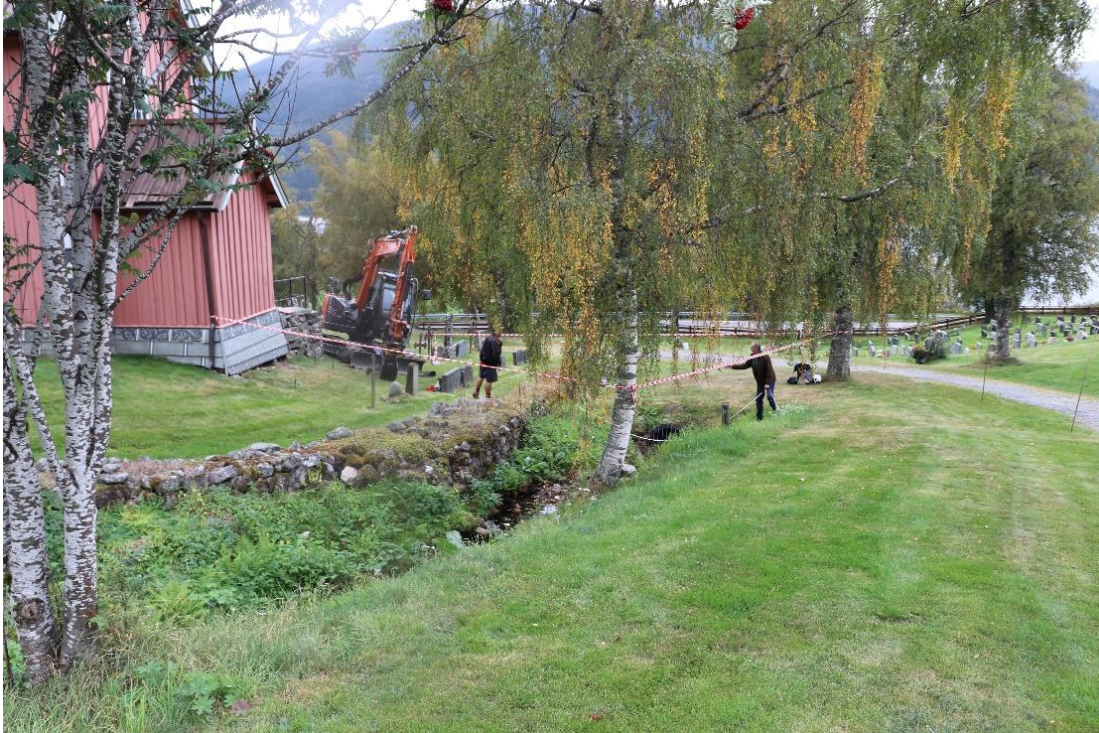
Figur 12. Arbeidsbilde. Markering av feltet som skal graves vest for bekken. Foto Cf53950_NIKU_0025.jpg.
