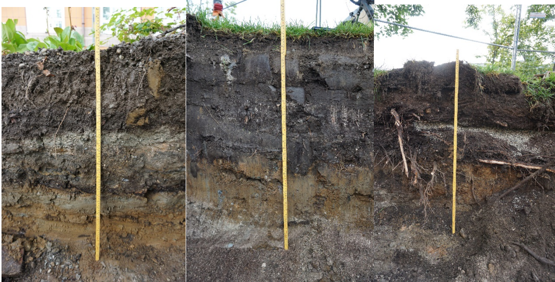
Fig 8. Profil mot N (venstre), mot Ø (midten), mot S (høyre).
