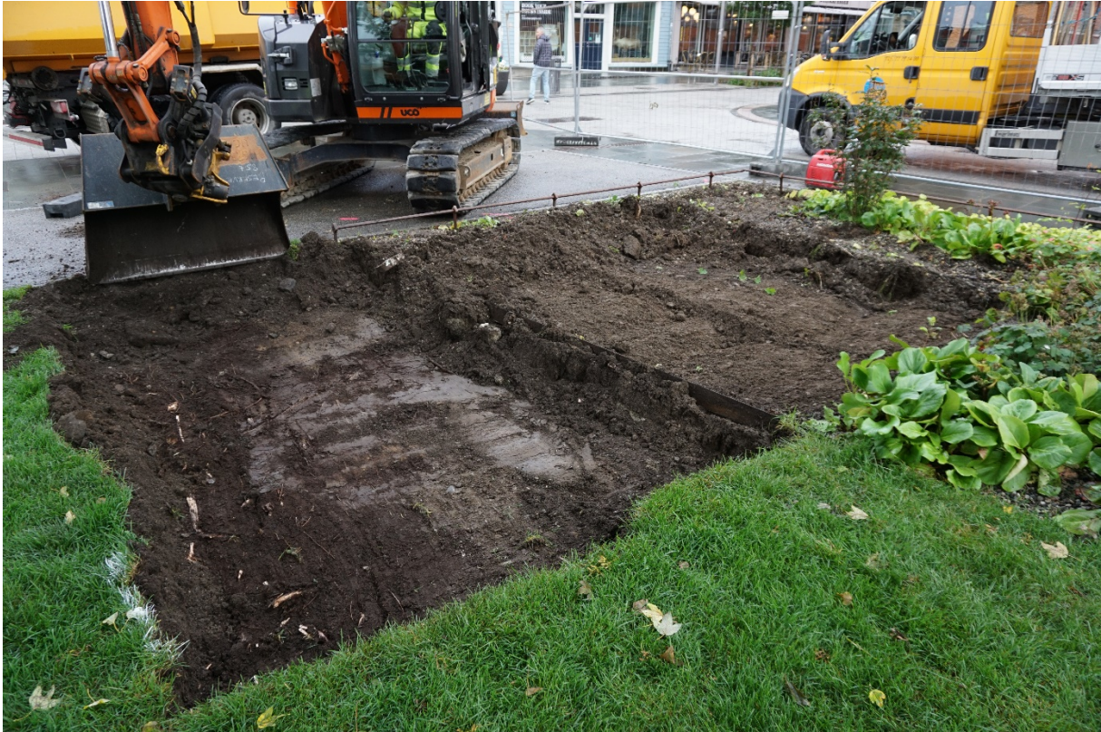
Fig2. Fjerning av grasmatta.
