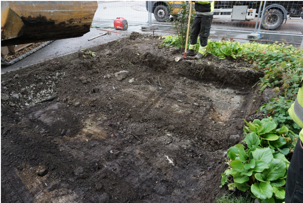
Fig 3. Fundamentering for fortau med påfylte masser og duk til venstre. Forankring for fjernet lyktestolpe litt bak for midten. I midten av bildet sees den første «oljekabelen».
