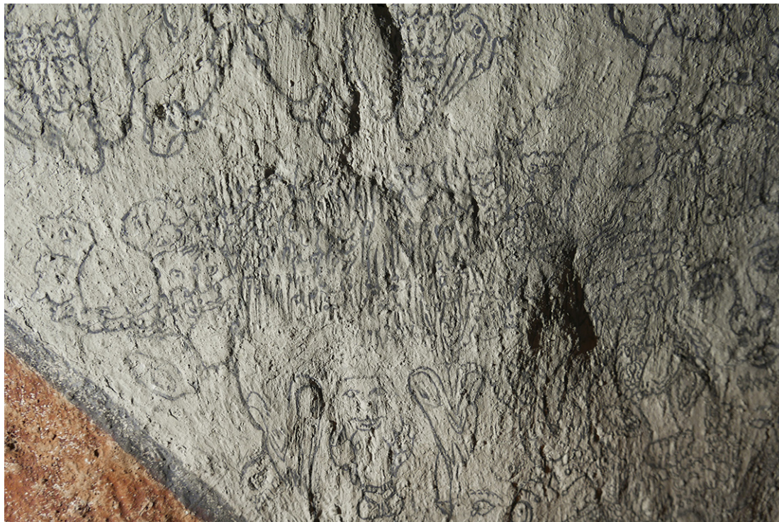
Ill. 6. Demonveggen. Detalj i sidebelysning som tydeliggjør overflatestrukturen. Man ser tydelige spor etter malerkosten ved påføring av kalkslemming, men ingen rissinger eller avtrykk som kan knyttes til selve dekorstrekene. Foto: Susanne Kaun, 2020.
