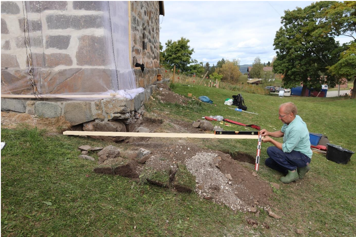
Figur 11: Den tre meter lange bjelken ligger på nivå med torvoverflaten – vest for den blottlagte grunnmuren i hjørnet. Foto mot nord: Cf53947_NIKU_81.JPG
