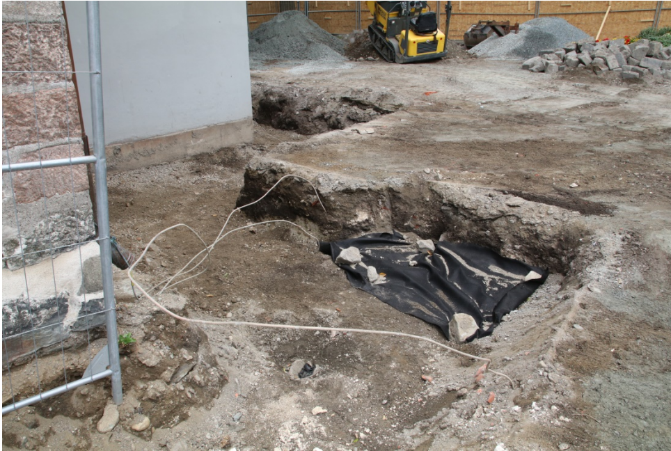
Figur 21: Oversikt over grøfta ved sørveggen til tårnet. Steinkonstruksjonen ligg intakt under fiberduken. Kablane høyrer til lynvernanlegget kring kyrkja. Foto: Da62838_017.
