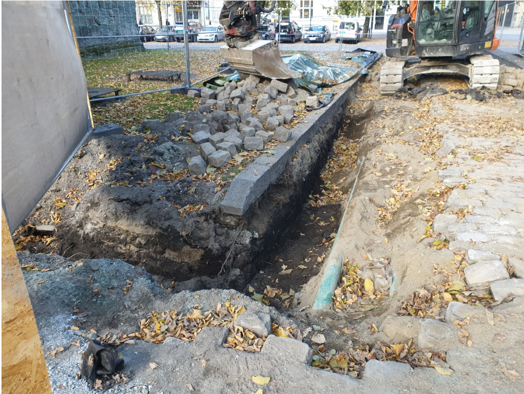
Figur 27: Dreneringsgrøfta aust for koret og i Vår frue gate. Foto Da62838_078.
