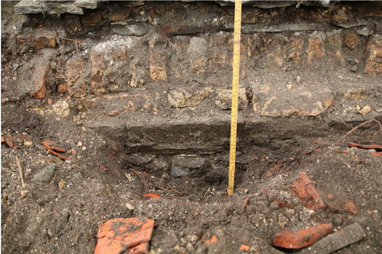
Figur 13: Murverk av gul tegl over sokkel av tilhoggen stein og mindre fundamenteringssteinar i sørveggen til 1600-tals delen av skipet. Foto: Da62838_020.
