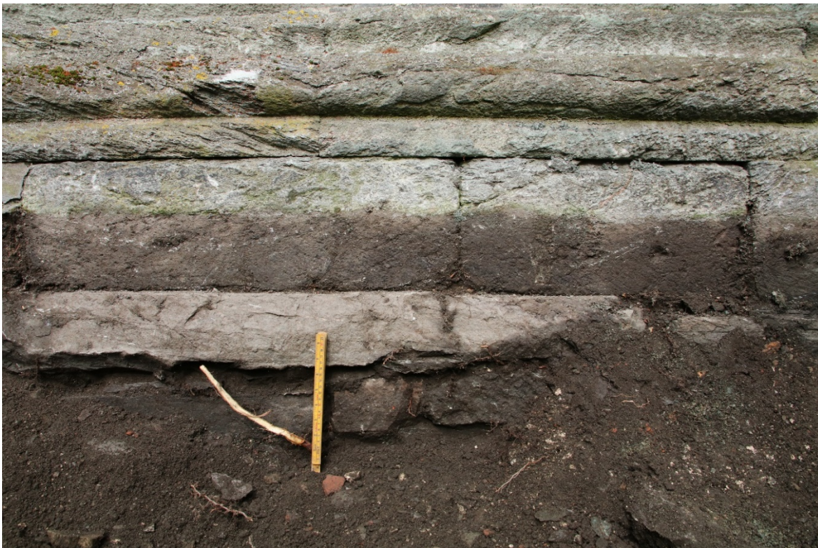
Figur 16: Sokkel/øvre del av fundament ved sørveggen til koret frå mellomalderen. Foto: Da62838_048.
