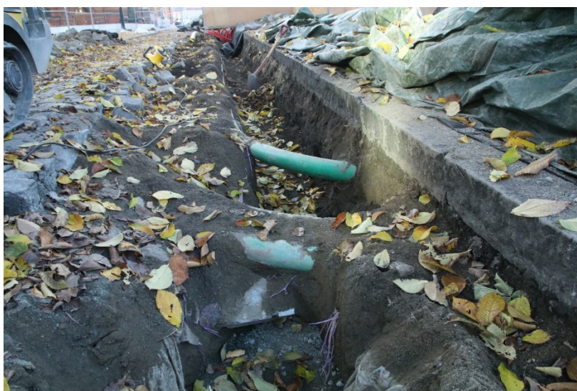
Figur 29: Eksisterande kablar i Vår frue gate kryssar dreneringsgrøfta mot nordvest aust for koret. Foto: Da62838_061.
