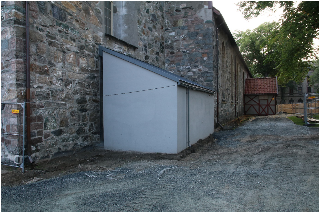
Figur 17: Oversiktsbilete av nedre del av tårnet, toalettanlegget og skipet fram til Sunnivakapellet før gravinga av dreneringsgrøfta starta. Drengrøfta går frå kummen nedst i venstre hjørnet av biletet. Foto: Da62838_002.
