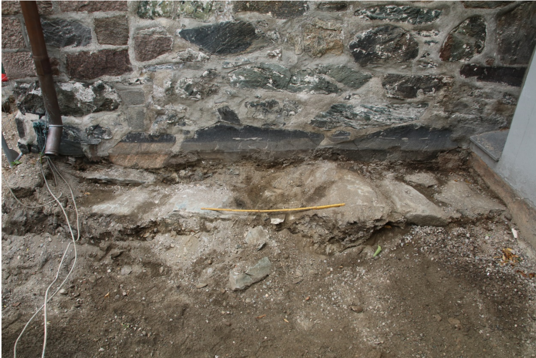
Figur 12: Sokkel/fundament ved sørveggen til tårnet. Foto: Da62838_016.
