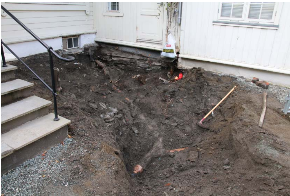
Figur 4. Kloakkrøret som skulle byttes ut. Sett mot sør-vest. Da62853_004.
