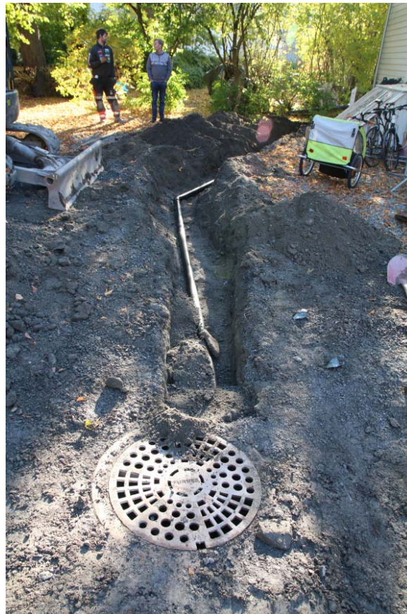
Figur 6. En grunn grøft for å fange opp regnvann fra hovedbygningen ble gravd på slutten av prosjektet. Det ble ikke gjort funn. Sett mot sør. Da62853_162.
