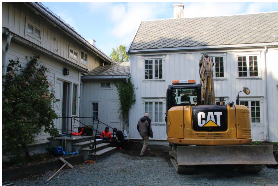
Figur 1. En nyere steintrapp (til venstre i bildet) lå over kloakkrørtraséen som var planlagt gravd. På grunn av dette måtte det legges en alternativ trasé til høyre for denne. Sett mot vest. Da62853_002.
