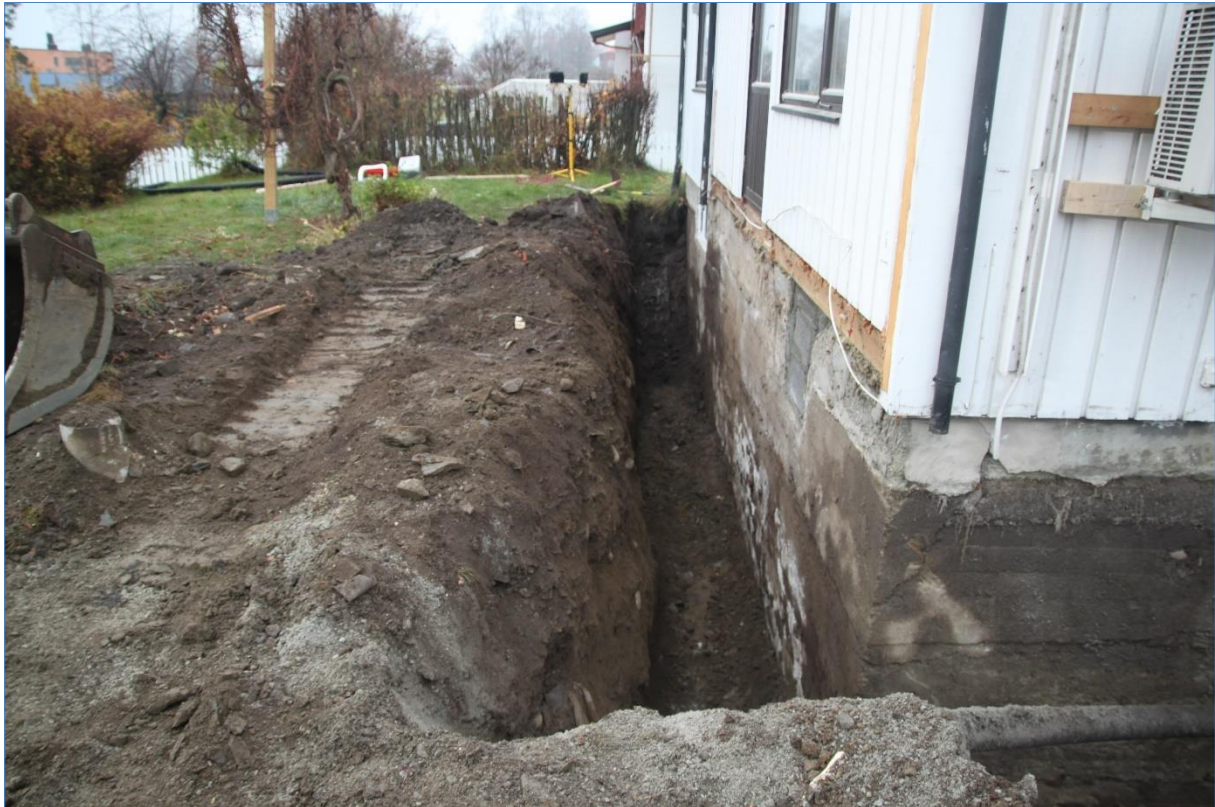
Figur 9. Dreneringsgrøft S, ferdig utgravd. Mot V. Foto Hilde R. Amundsen 2020 (Cf53906_NIKU_0013).
