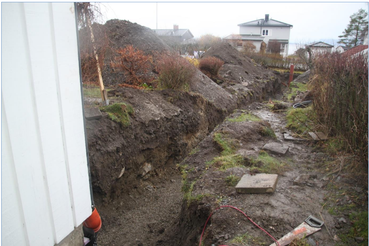
Figur 13. Grøft VA-anlegg, oversiktsfoto over gravd areal, tatt fra SV-hushjørne. Mot S. Foto Hilde R. Amundsen 2020 (Cf53906_NIKU_0032).
