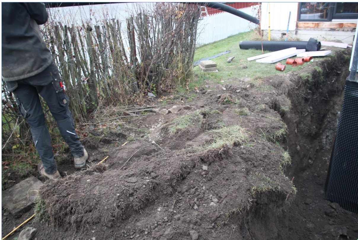
Figur 11. Dreneringsgrøft V, ferdig utgravd. Mot V. Foto Hilde R. Amundsen 2020 (Cf53906_NIKU_0016).
