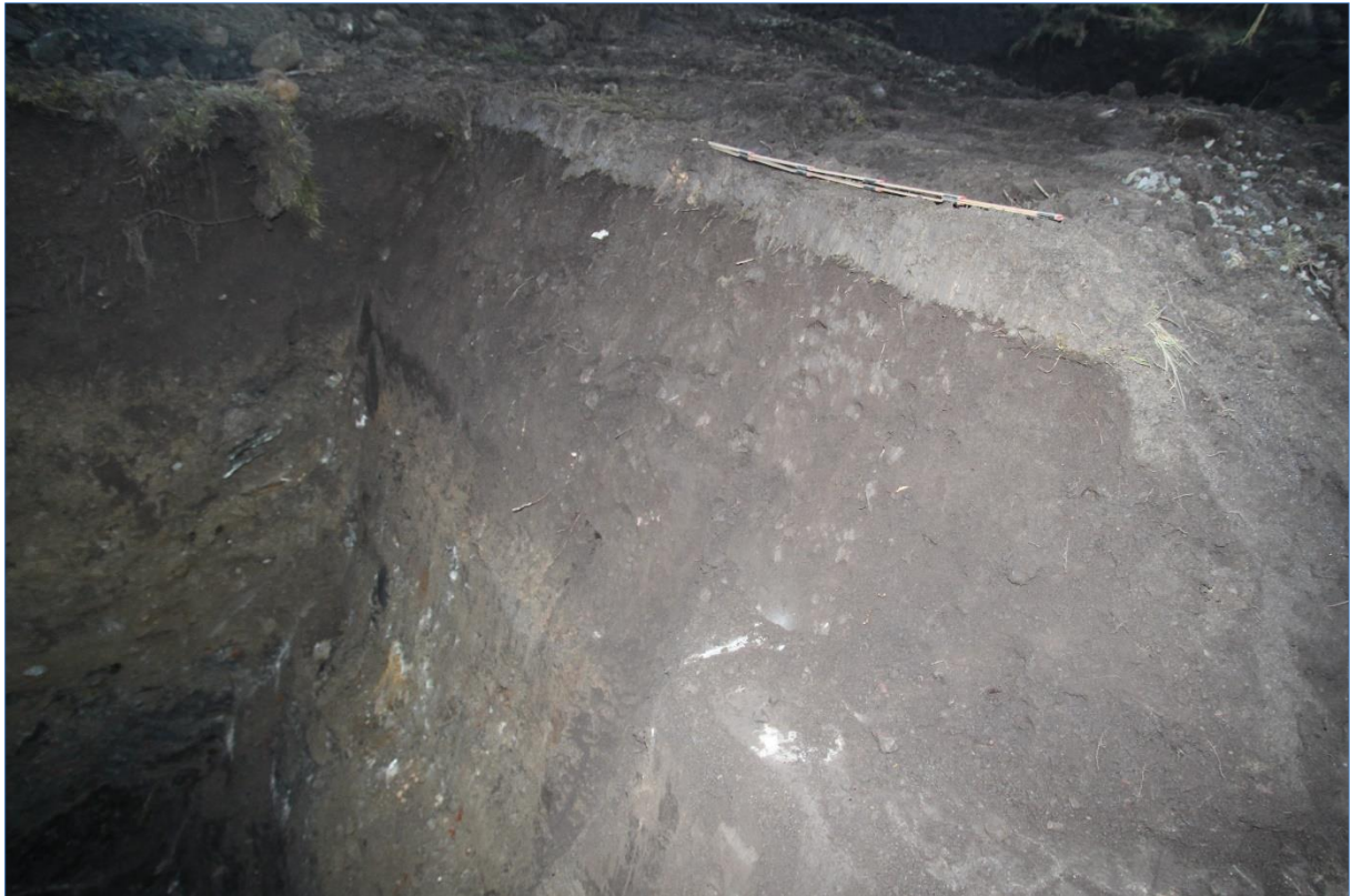
Figur 15. Grøft VA-anlegg, utvidet parti østover til kum og infiltrasjonsanlegg ved grøftas søndre ende. Bryggesteinslag (Lag 2) i SØ-profil. Mot SØ. Foto Hilde R. Amundsen 2020 (Cf53906_NIKU_0033).
