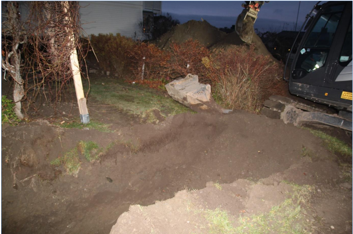
Figur 12. Grøft VA-anlegg, graving av grøfta innenfor plattingen i nordre del. Mot Ø. Foto Hilde R. Amundsen 2020 (Cf53906_NIKU_0017).
