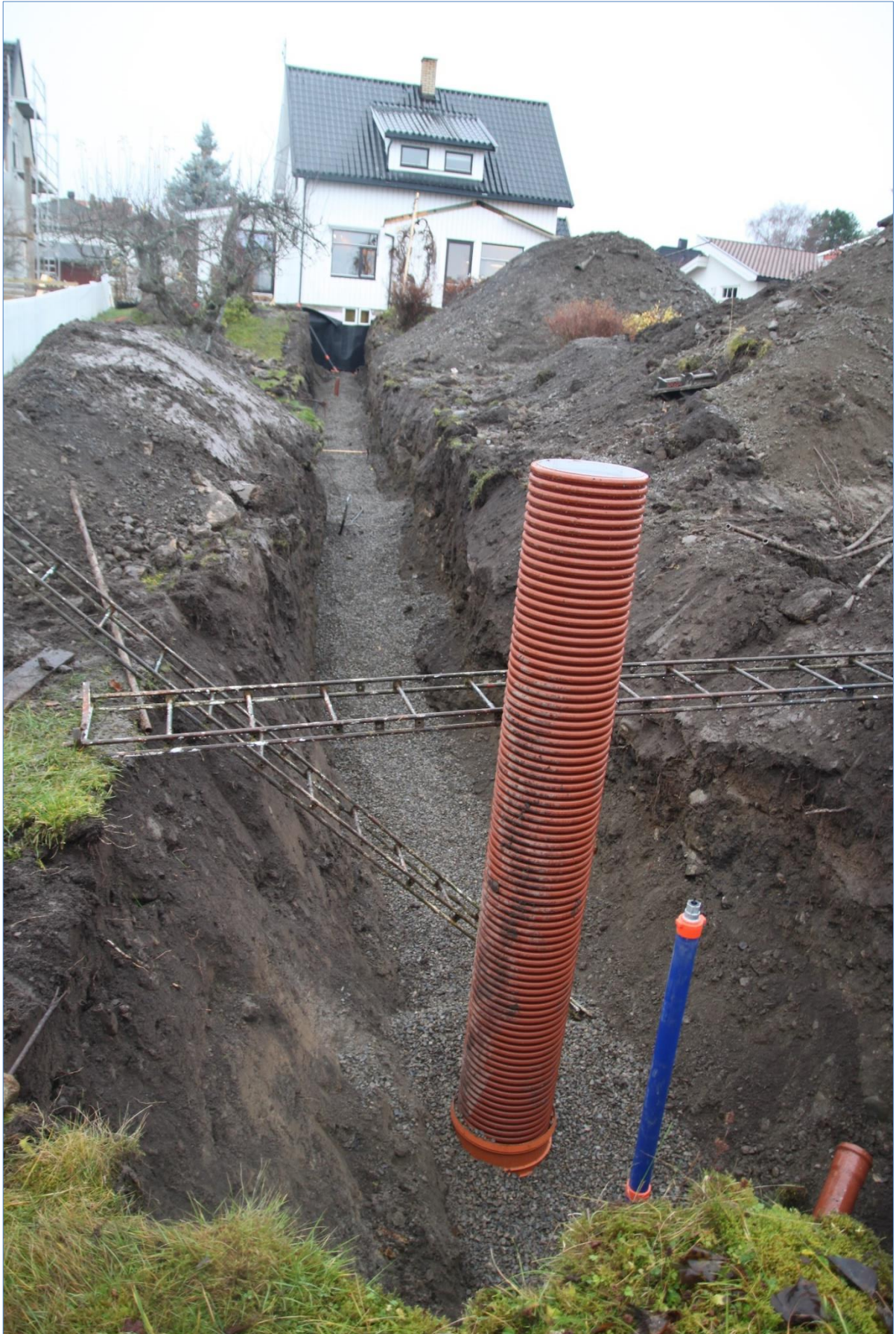
Figur 14. Grøft VA-anlegg, oversiktsfoto over gravd areal. Mot N. Foto Hilde R. Amundsen 2020 (Cf53906_NIKU_0031).
