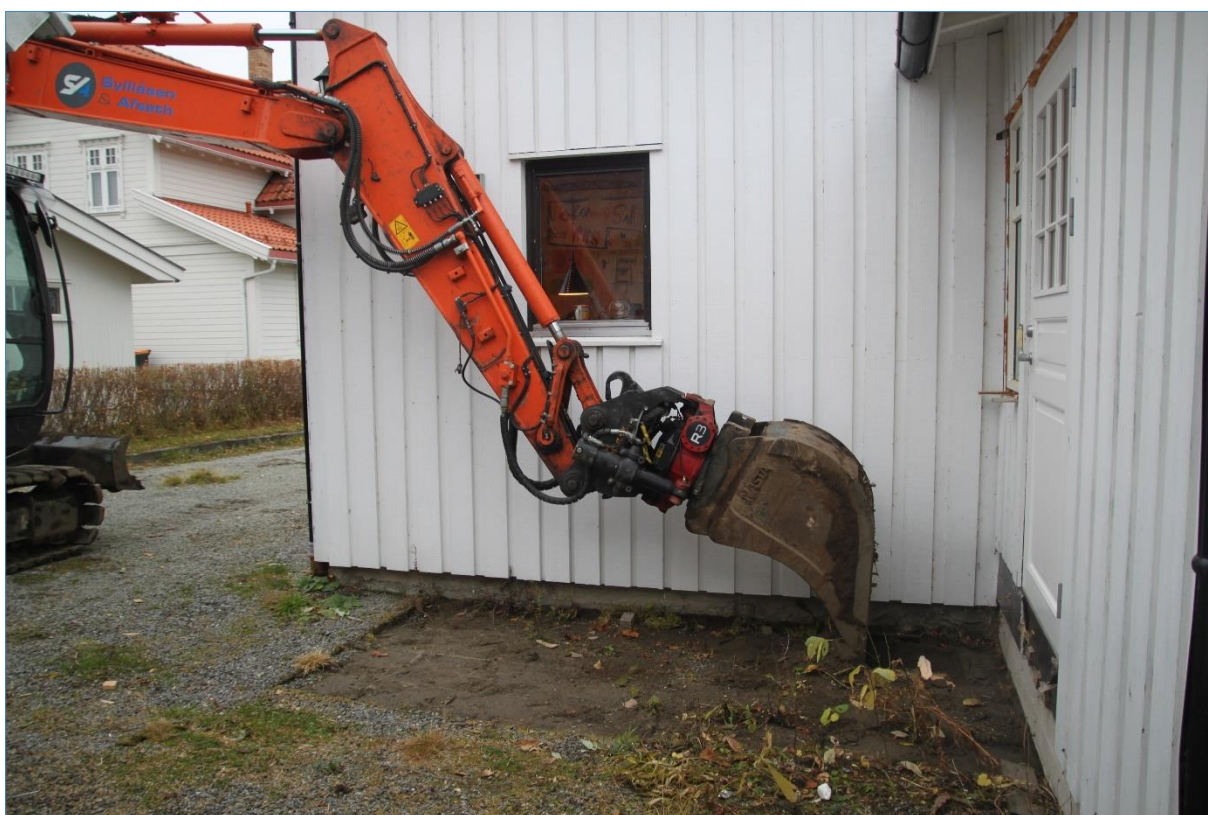
Figur 6. Dreneringsgrøft NØ, oppstart graving ved husets NØ-side. Mot Ø. Foto Hilde R. Amundsen 2020 (Cf53906_NIKU_0006).
