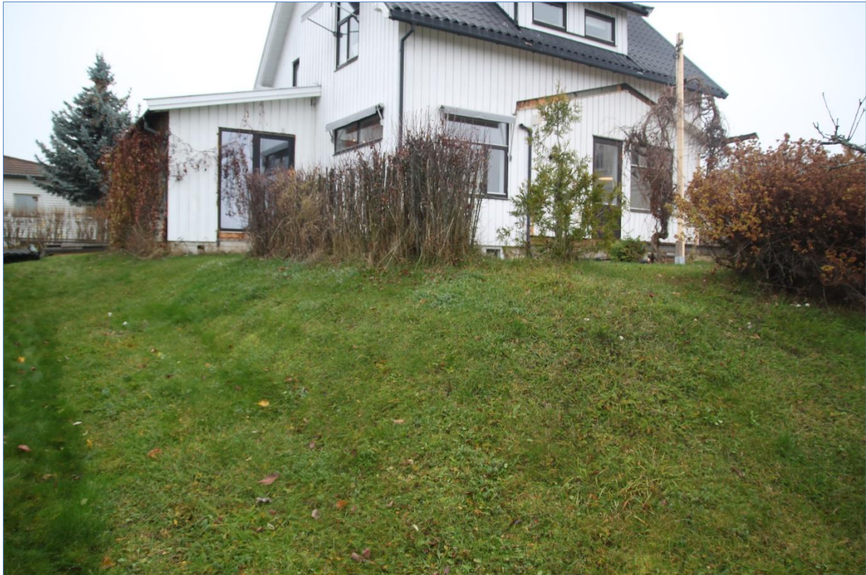
Figur 10. SV-del av oppbygd plattning foran husets sørside. Det nyere tilbygget i vest. Mot N. Foto Hilde R. Amundsen 2020 (Cf53906_NIKU_0010).
