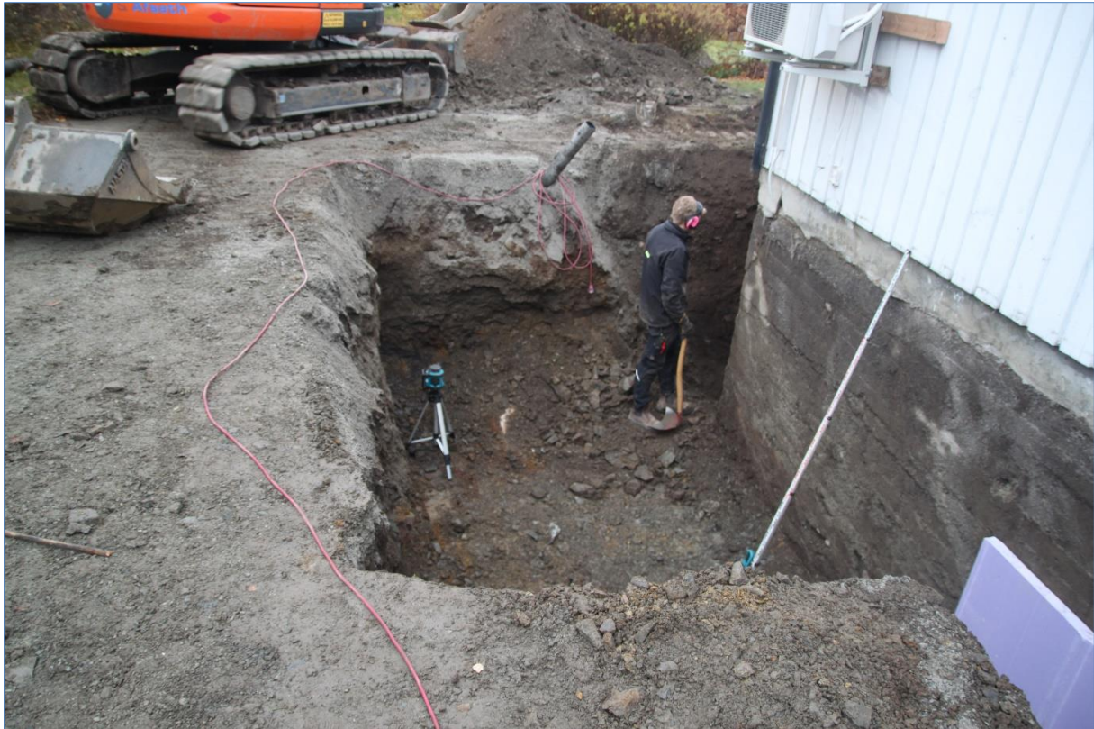
Figur 8. Utvidet dreneringsgrøft Ø i søndre del, gravd parti for fundament til ny trapp. Mot S-SØ. Foto Hilde R. Amundsen 2020 (Cf53906_NIKU_0014).
