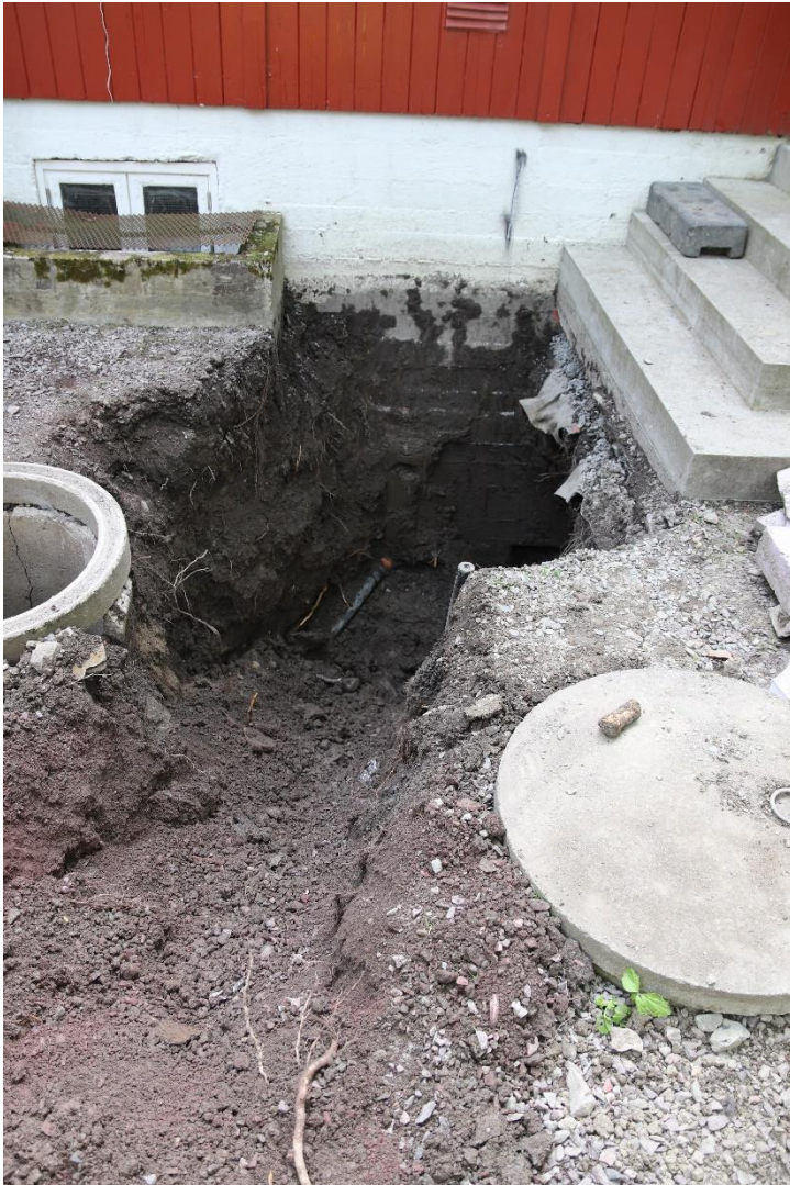
Figur 3: Oversikt over graving av grøft inntil Klosterkroa. Sett mot sør. Foto-nr: Cf53943_NIKU_0007.JPG
