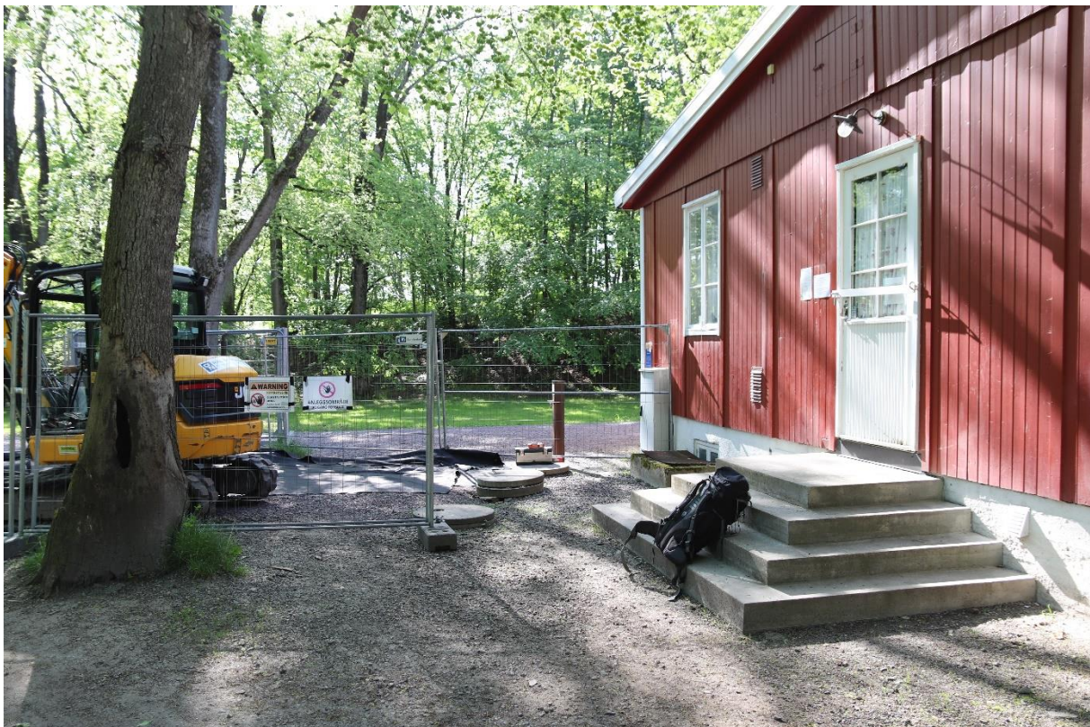
Figur 1: Oversikt før start, sett mot sørøst. Foto-nr: Cf53943_NIKU_0001.JPG
