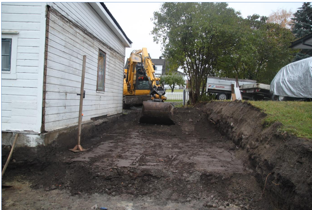
Figur 11 Overgang mellom nedgravd område i sør og plattning øst for uthuset. Mot N-NV. Foto: Hilde R. Amundsen 2019 (Cf53869_NIKU_16).
