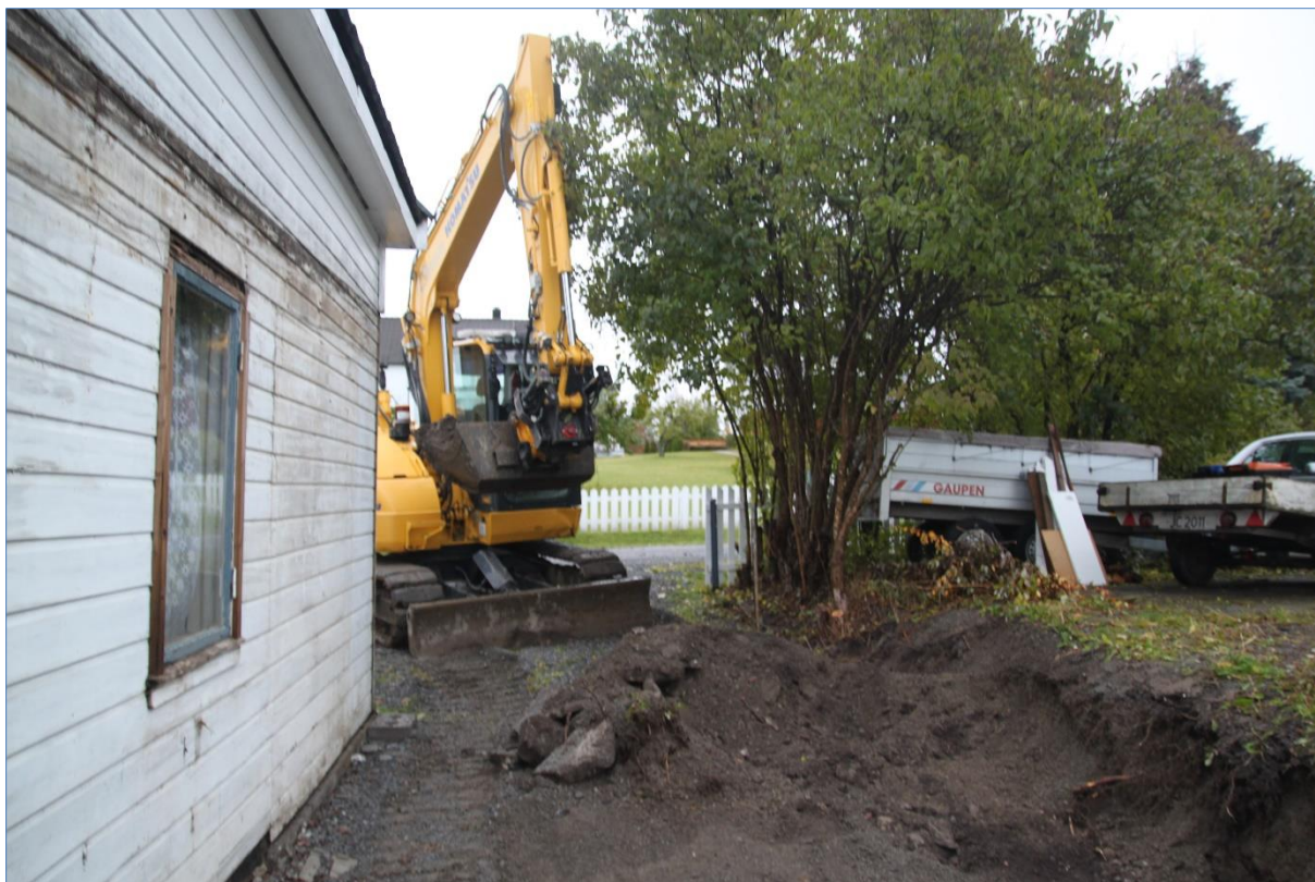
Figur 4 Arbeidsfoto: oppstart av gravingen. Mot N-NV. Foto: Hilde R. Amundsen 2019 (Cf53869_NIKU_05).
