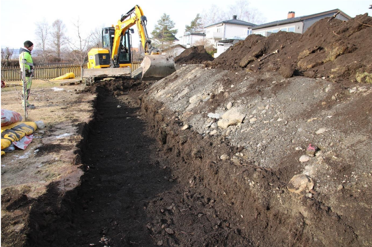
Figur 3: Påstartet graving av grøft for støttemur. Sett mot vest. Foto: Cf53707_NIKU_05.
