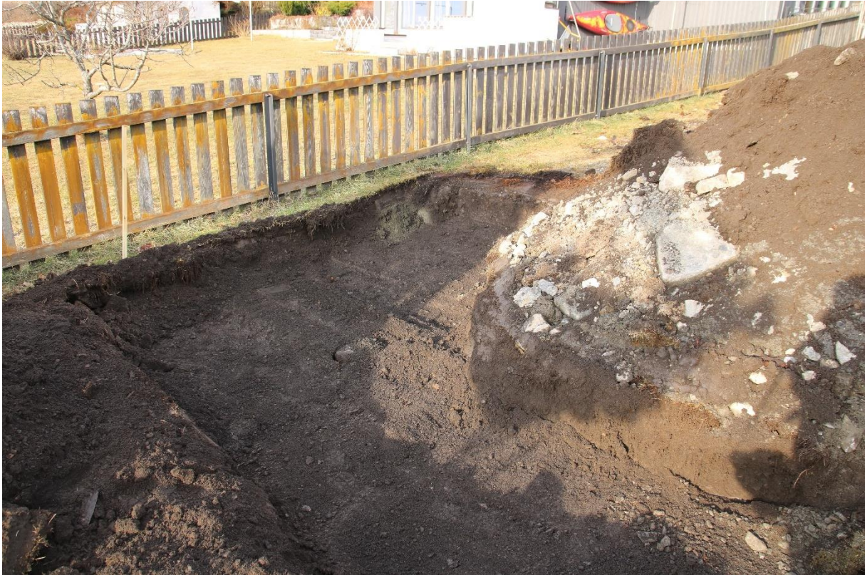
Figur 6: Ferdigstilt graving av den nordvestre delen av grøften. Sett mot nordvest. Foto: Cf53707_NIKU_10.
