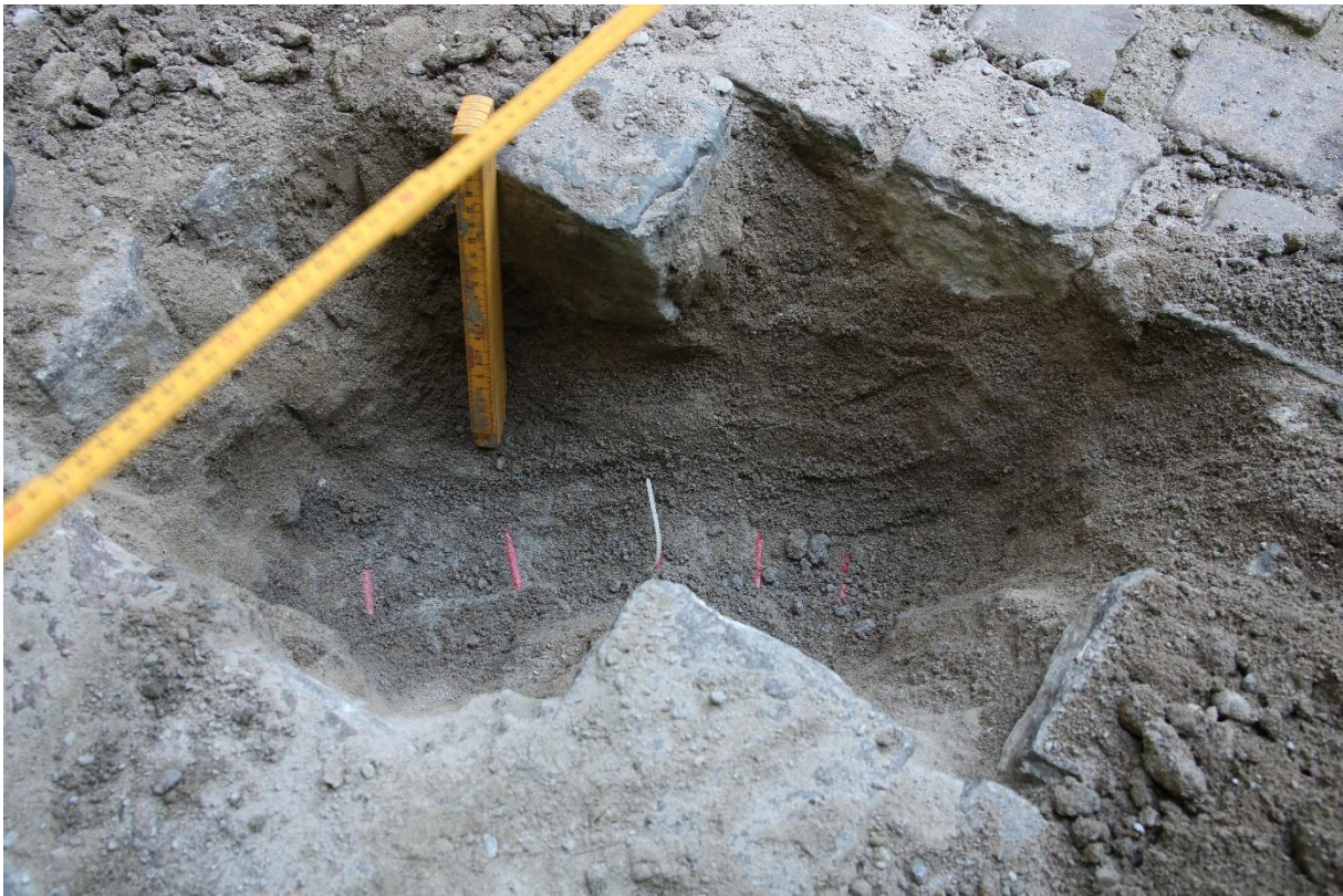
Figur 4: Varmekabler under brostein har blitt krafset frem. Sett mot nordvest. Foto: Cf53706_NIKU_13.
