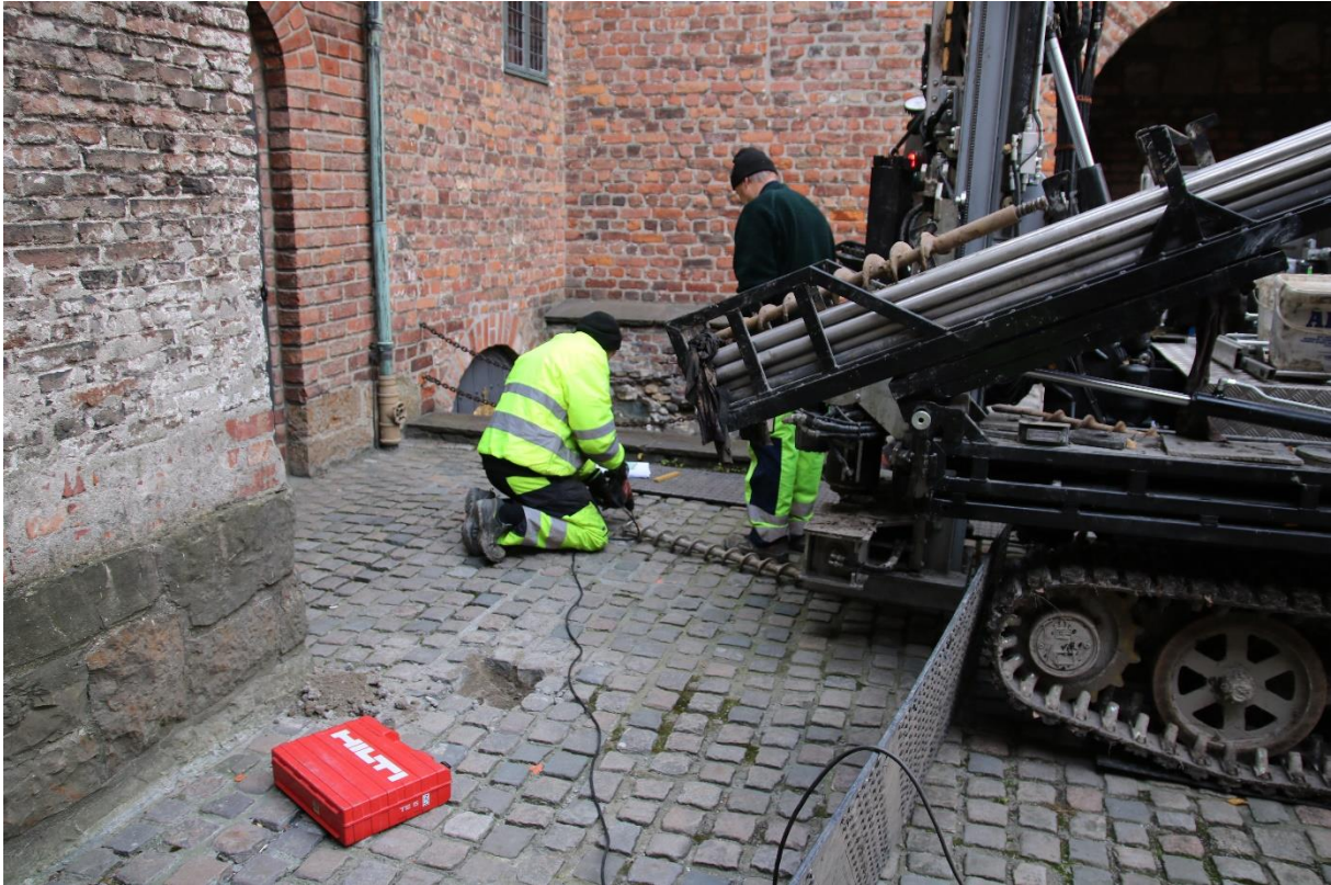
Figur 3: Boreriggen rigges til i borggården til Akershus slott. Brostein ble fjernet for de aktuelle borepunktene. Sett mot sørvest. Foto: Cf53706_NIKU_05.
