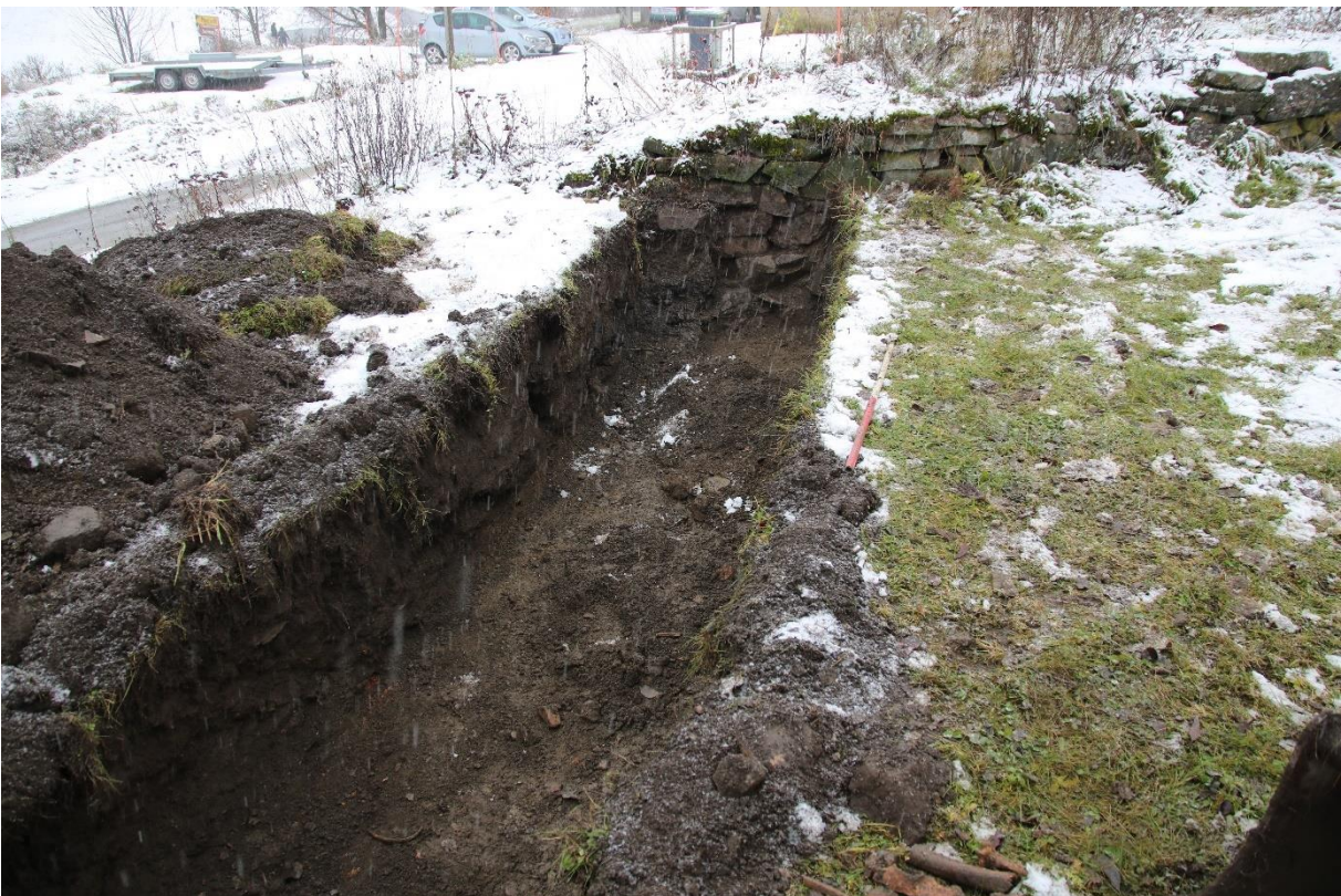
Figur 4: Påstartet arbeid med å grave sjakt. Sett mot nordvest. Cf53693_NIKU_052.
