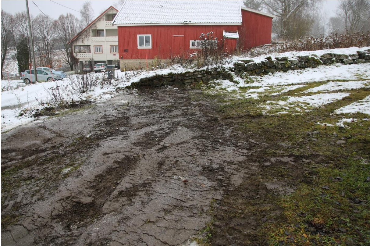
Figur 10: Tiltaksområdet etter tilbakefylling av den gravde sjakten. Sett mot nord. Cf53693_NIKU_070.
