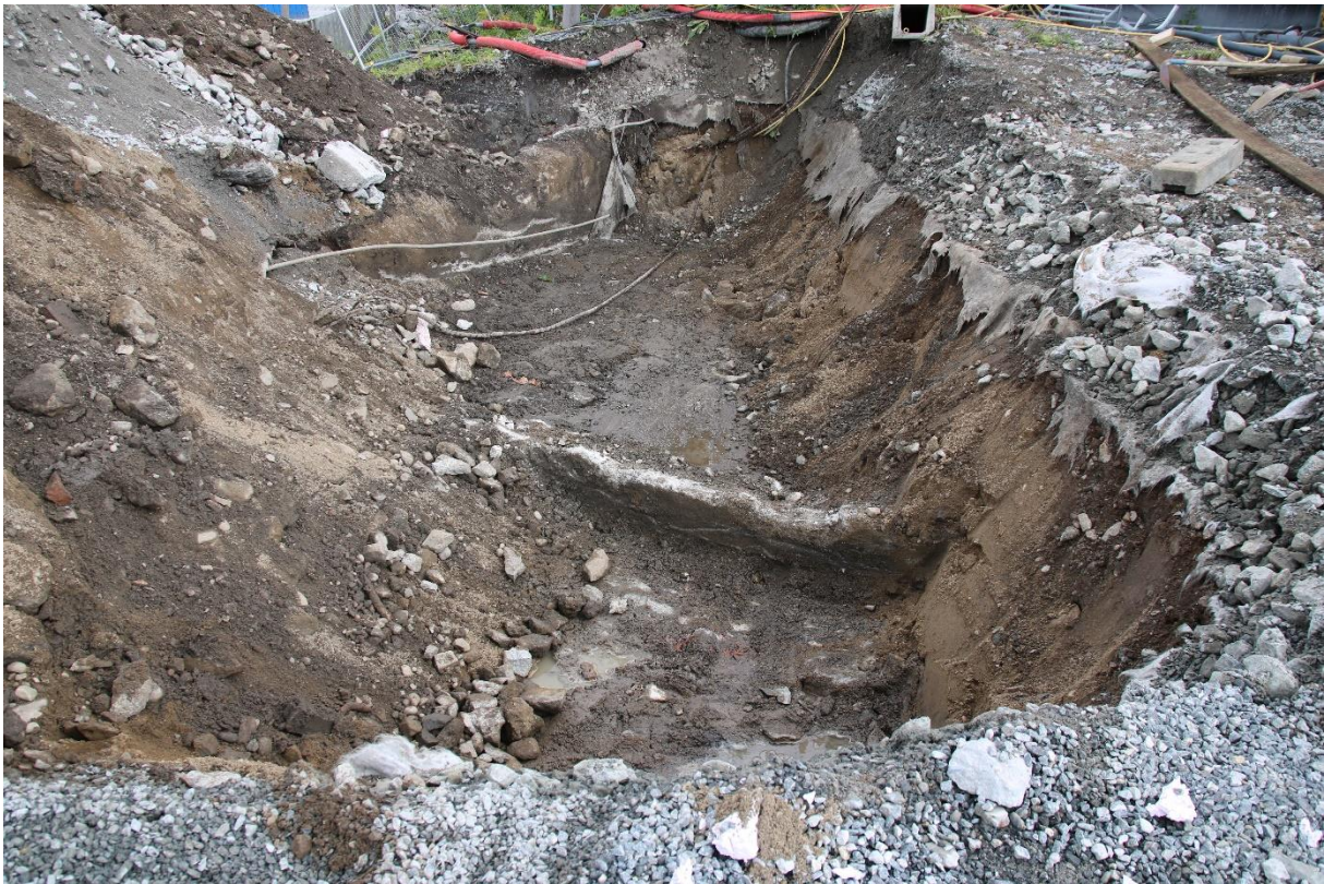
Figur 8: Byggegrøp for kum C, nord for Alna og sporene på Loenga. Groppen her ferdig gravd til omsøkt dybde. Sett mot nord. Foto: Cf53685_NIKU_017.
