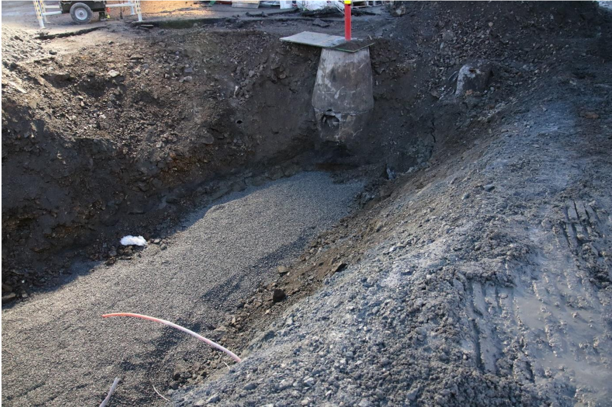
Figur 13: Grøft for nytt rør ut av trafobygning mot nordøst. Det var mye infrastruktur fra nyere tid i dette området. Sett mot nordøst. Foto: Cf53685_NIKU_071.
