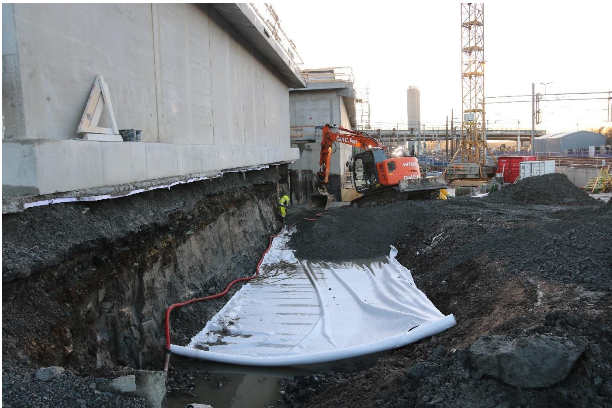
Figur 14: Ferdig gravd område TB-T, nord for ny trafobygning. Sett mot sørvest. Foto: Cf53685_NIKU_080.
