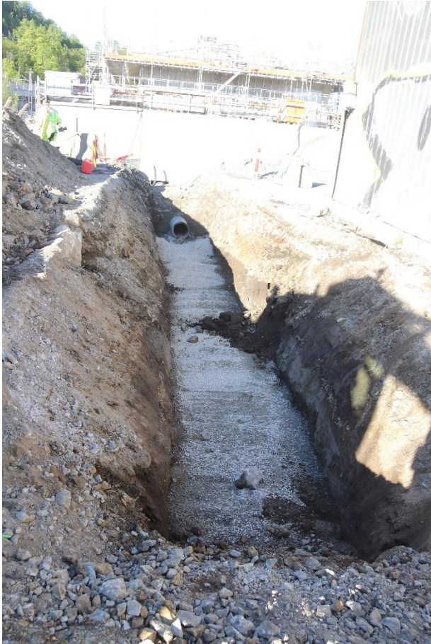
Figur 15: Grøftestrekning gravd for nytt rør videre mot nordøst, ut fra trafobygning. Sett mot sørvest. Foto: Cf53685_NIKU_096.
