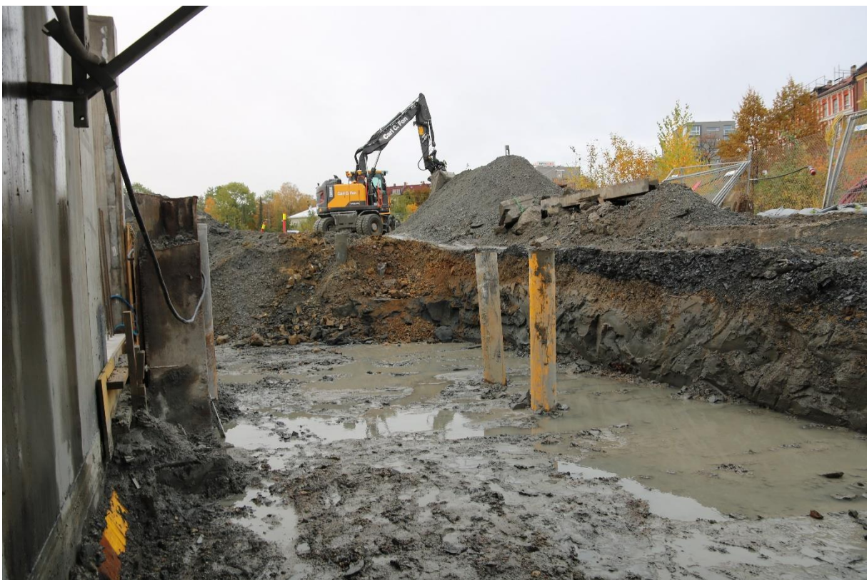
Figur 11: Ferdigstilt byggegrop for kulvert CC-M. Alunskifer og gult sandlag kan observeres i byggegropens søndre profil. Sett mot øst. Foto: Cf53685_NIKU_058.
