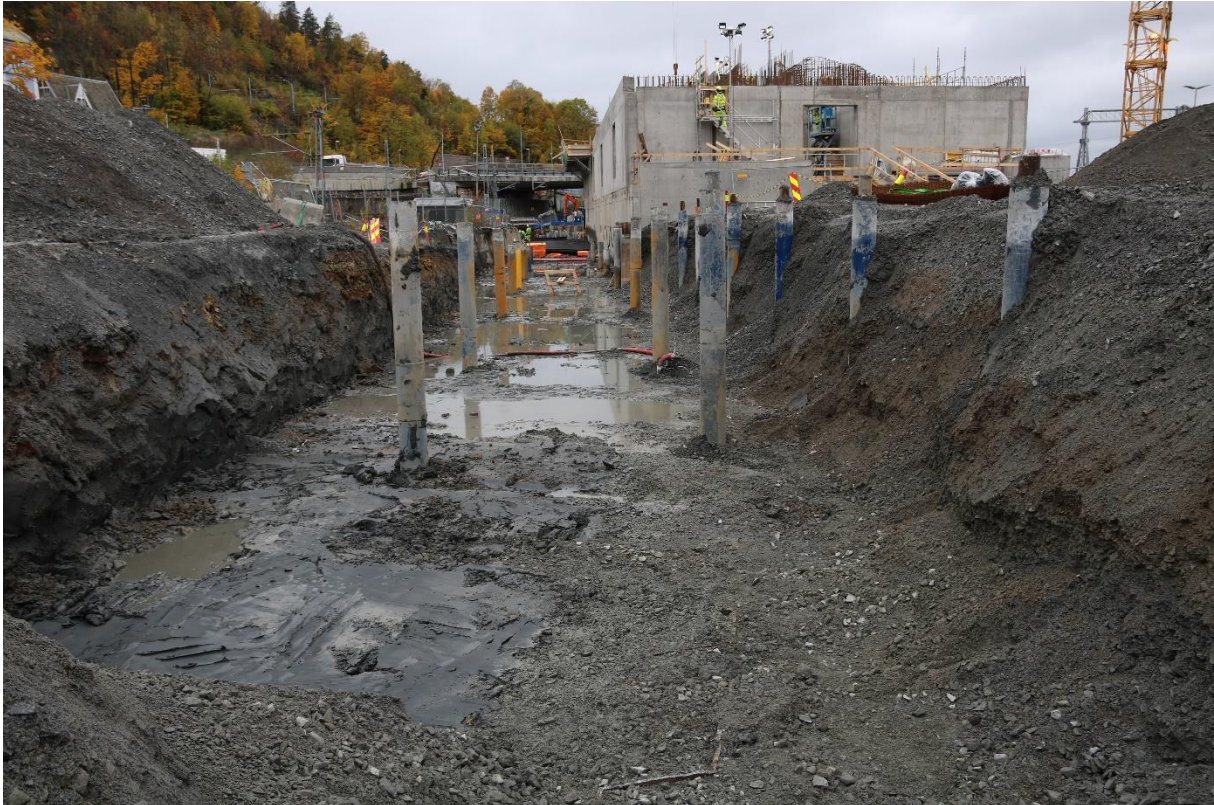
Figur 10: Ferdigstilt byggegrop for kulvert CC-M. Sett mot sørvest. Foto: Cf53685_NIKU_067.
