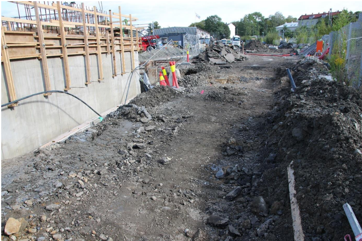
Figur 9: Deler av tiltaksområdet for byggegrop CC-M før oppstart av gravearbeidet. Sett mot nordøst. Foto: Cf53685_NIKU_030.
