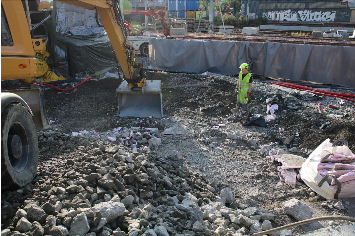
Figur 7: Byggegrøp for kum C før oppstart av gravearbeidet. Betongplate har blitt pigget bort. Sett mot sørøst. Foto: Cf53685_NIKU_008.
