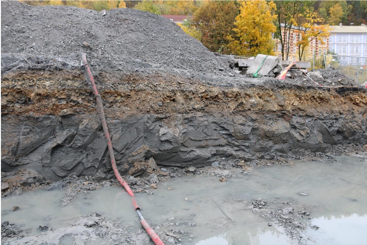
Figur 12: Eksempel på profil i den nordøstre enden av byggegrop CC-M. I den sørvestre enden av byggegropen var det en støttemur i betong langs gropens søndre ende, og det ble ingen gjenstående profil. Sett mot sørvest. Foto: Cf53685_NIKU_062.
