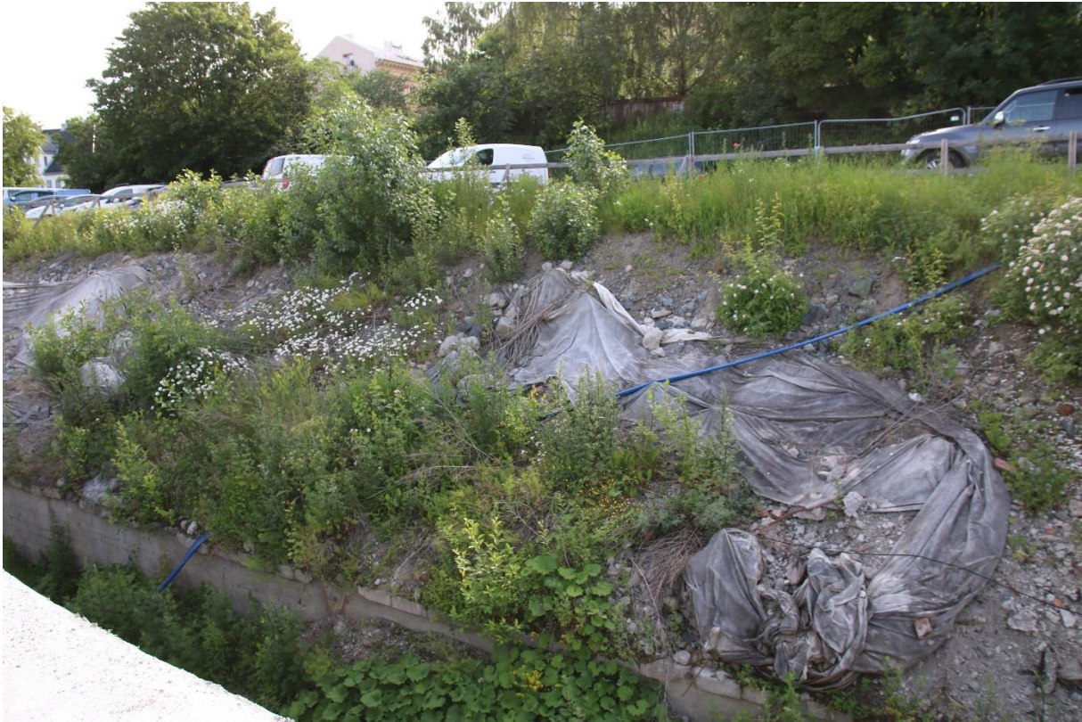
Figur 13: Eksempel på hvordan kulverten for vannledning fra 1961 så ut i skråningen. Synlig nederst på bilde. På bildet kan også ses mulig forekomst av asbest tildekket med fiberduk og påsprøytet betong. Sett mot nordøst. Foto: Cf53684_NIKU_003.
