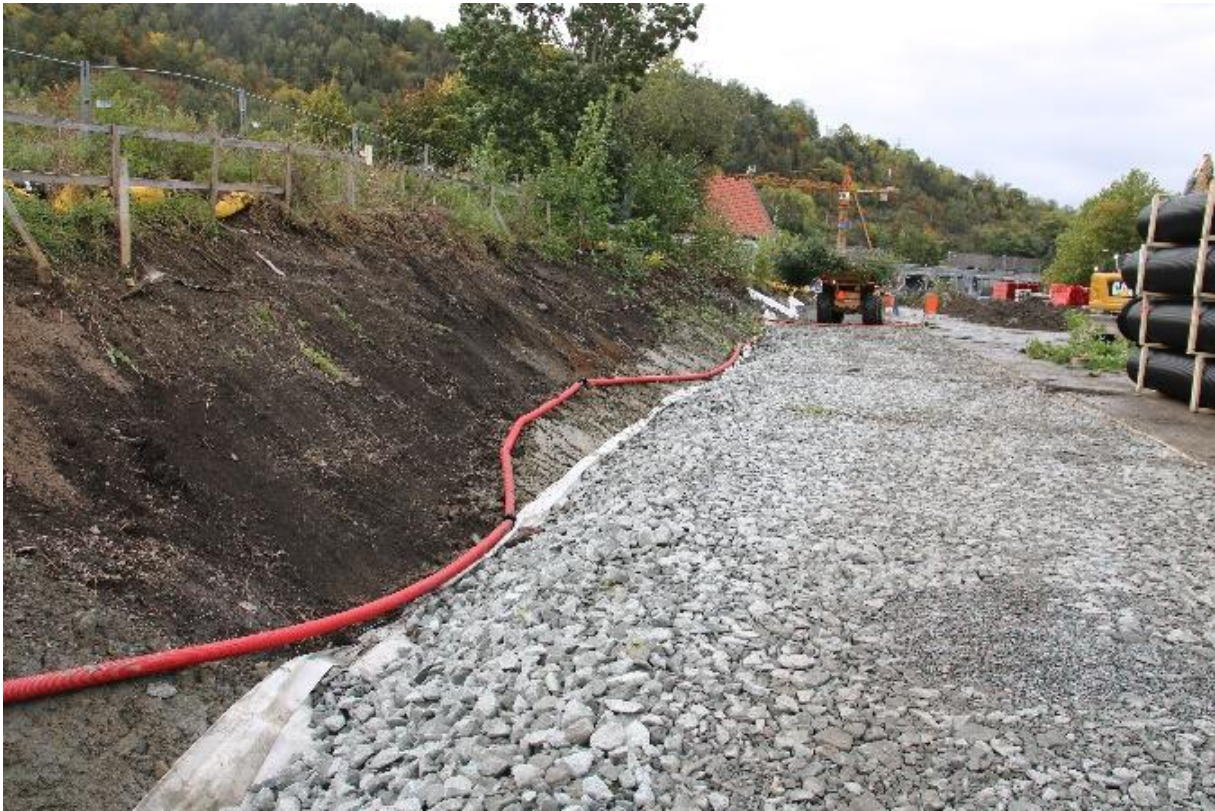
Figur 11: Tiltaksområdet delvis fylt opp med pukk på fiberduk og ikke-marin leire. Sett mot sør. Foto: Cf53684_NIKU_042.
