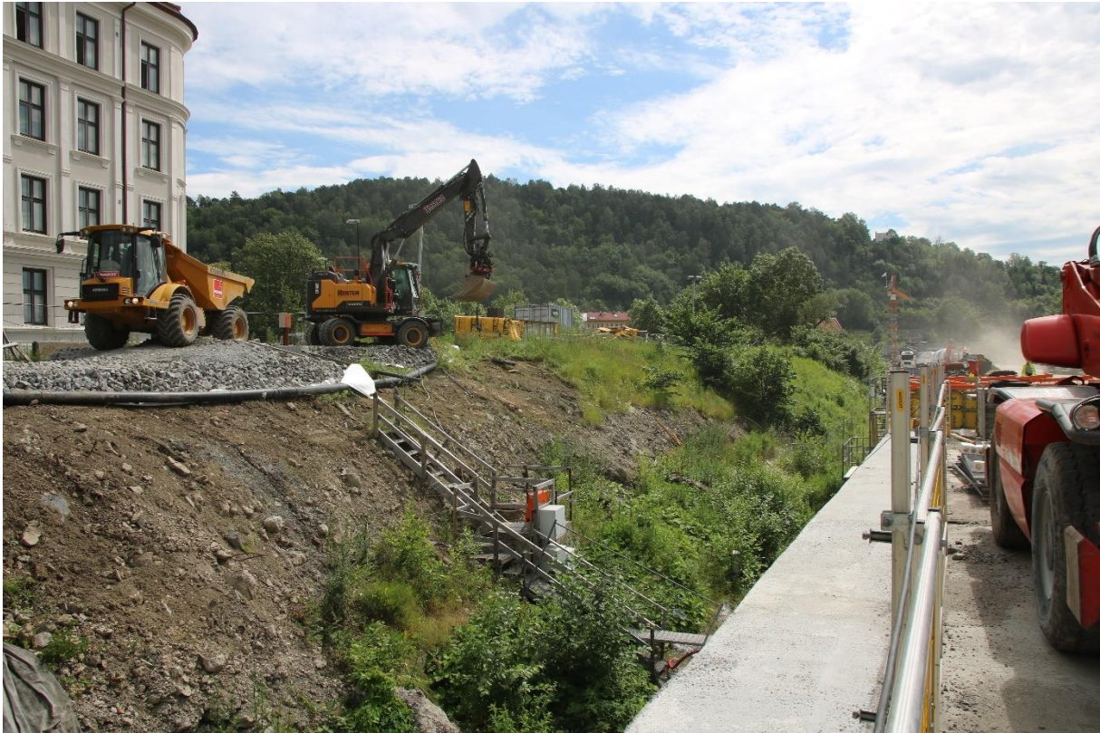
Figur 7: Tiltaksområdet underveis i arbeidet. Sett mot sør. Foto: Cf53684_NIKU_020.
