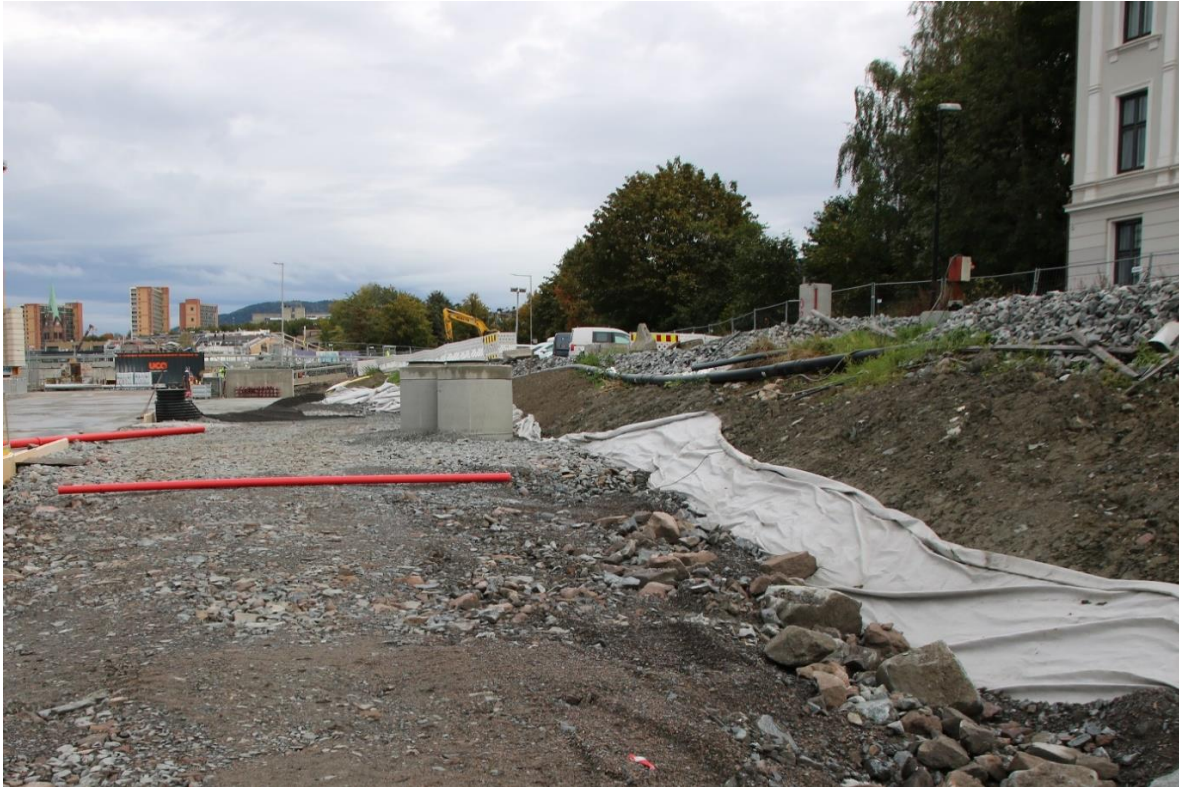
Figur 15: Eksempel på ferdigstilt heving av nivået til kumlukk i den nordre delen av tiltaksområdet. Sett mot nordøst. Foto: Cf53684_NIKU_045.
