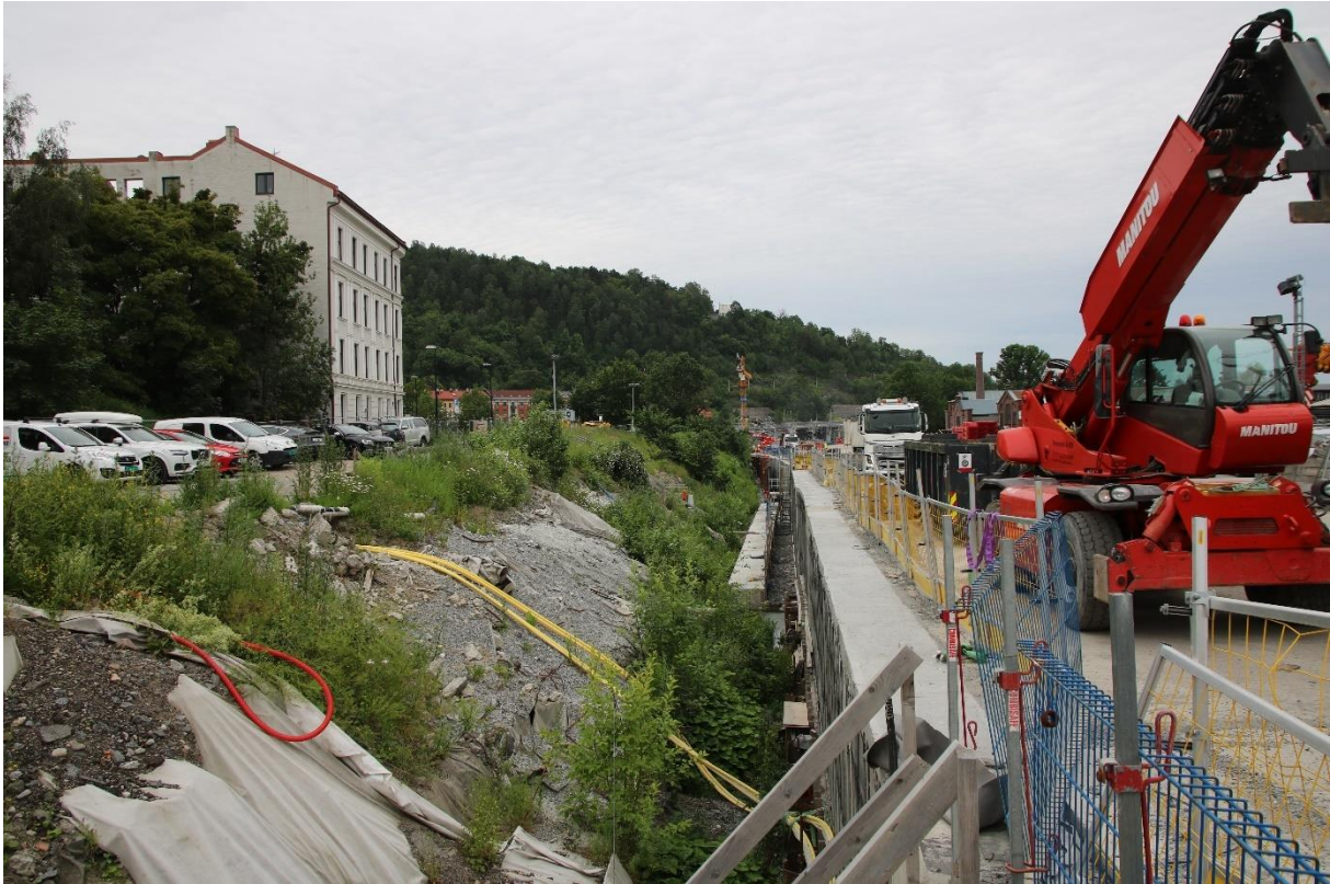
Figur 4: Tiltaksområdet før oppstart av arbeidet. Sett mot sør. Foto: Cf53684_NIKU_004.
