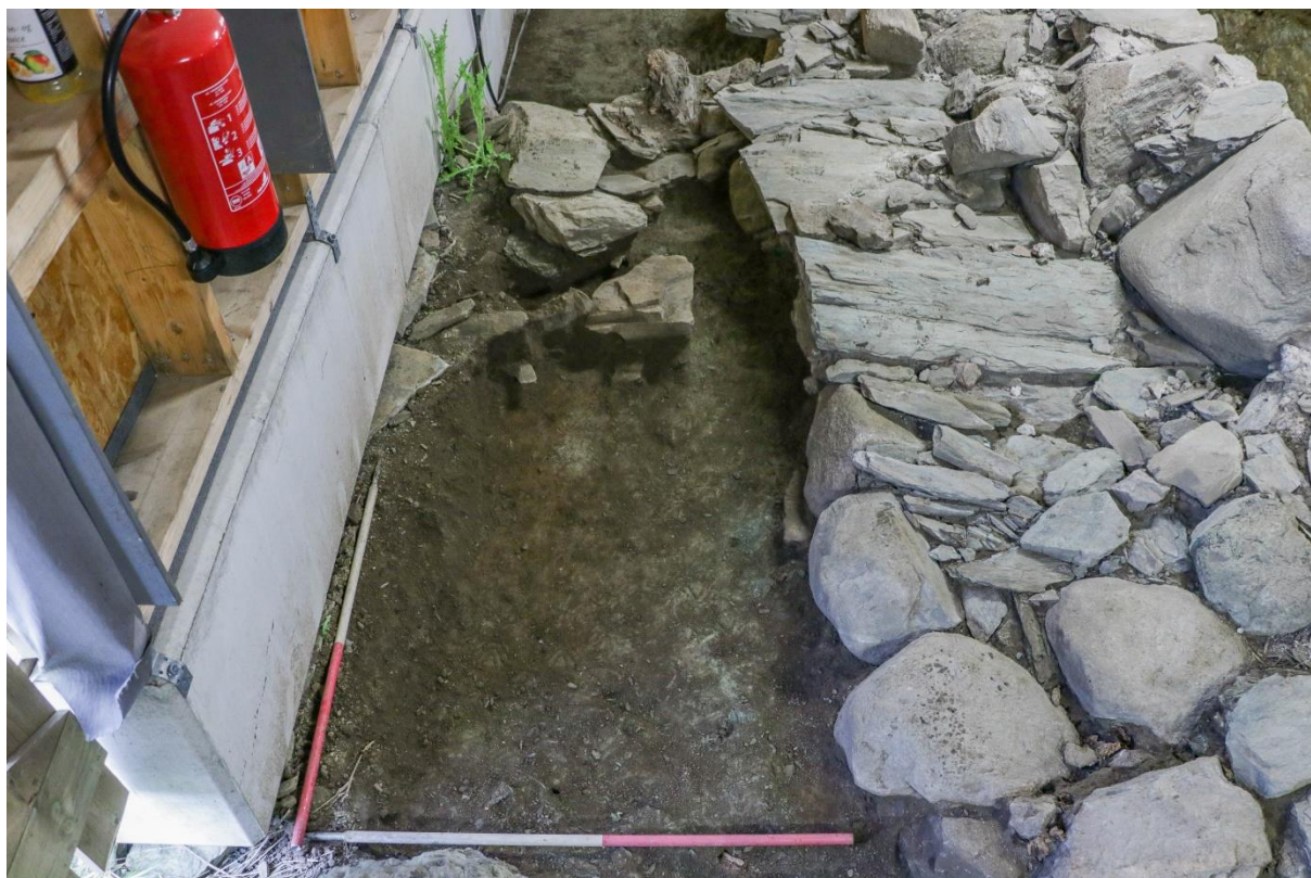
Figur 77. Østsiden av SA20 rett ved den yngre kjelleren SA50. Bildet viser blandingen av ulike typer stein i sokkelen, fra relativt store heller til runde stein og små kantete stein. Målestengene er 1 m. Sett mot sør. Foto Sf202867.
