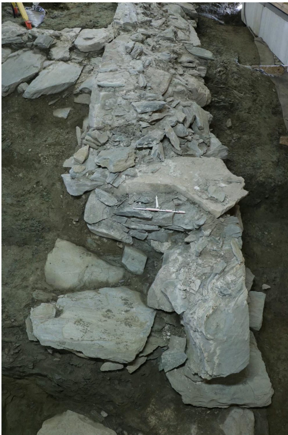
Figur 101. Midt på bildet, under målestokken, er en håndfull stein lagt i leire – SL6638. På de større steinene til høyre og bak er det kalkmørtel. Målestokken er 40 cm. Sett mot nord. Foto Sf202856.
