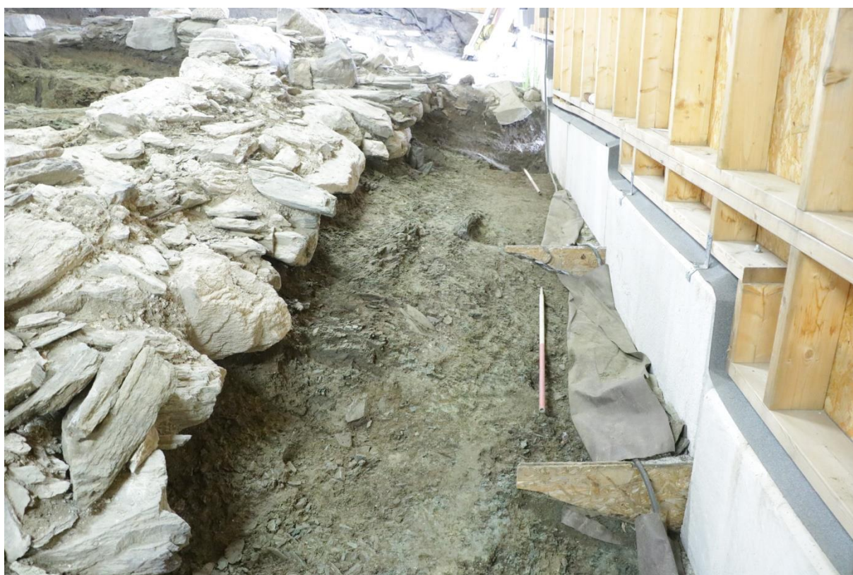
Figur 76. Sokkelen ved utsiden av østmuren midt på SA20; sokkelen er noe ujevn, men stikker tydelig ut. Det ligger mørtel ned på sokkelen, som antyder hvor murlivet har vært, 10–20 cm inn fra kanten av sokkelen. Sokkelen er lagt på grunnfjell. Målestengene er 1 m. Sett mot nord. Foto Sf202700.
