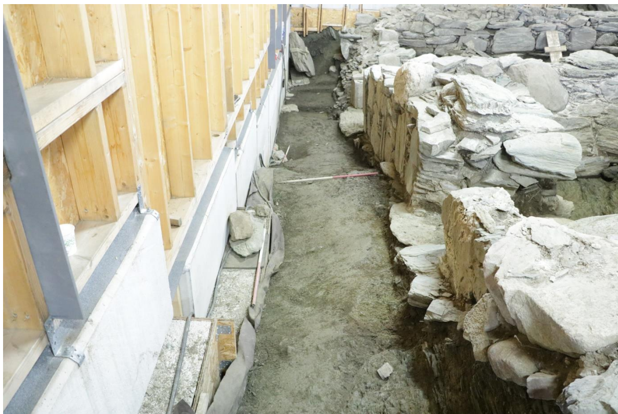
Figur 75. Langs utsiden av østmuren til SA20. Nærmest kameraet til høyre er bruddet i muren ved rommet SA60, jf. Figur 43. Målestanga er 1 m. Sett mot sør. Foto Sf202753.
