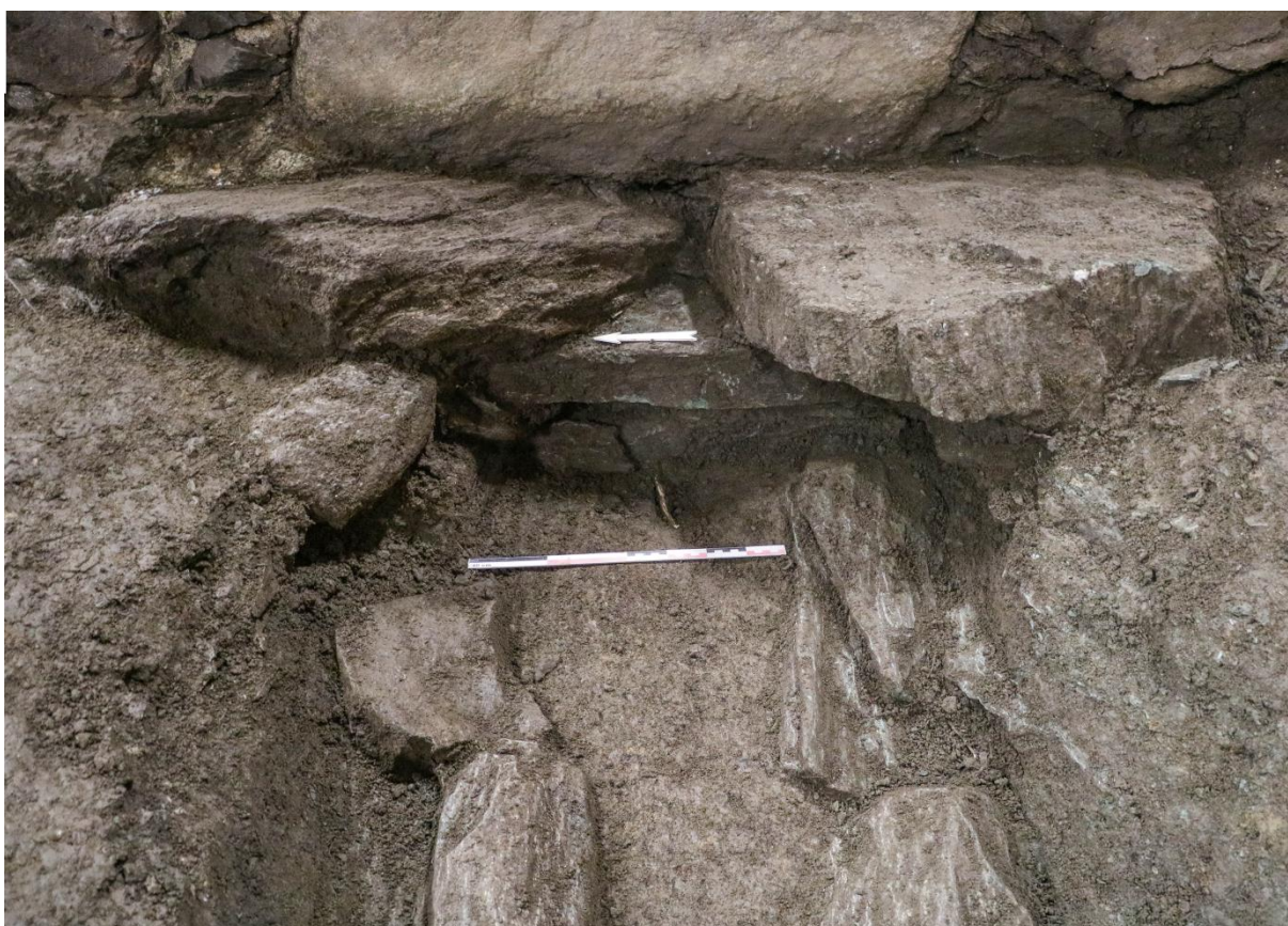
Figur 37. Bunn av innsiden av østmuren til SA20, der SA40 går inn under muren. Dekkhellene er fjernet, men ikke avsetningene i kanalen. Målestokken er 40 cm. Sett mot øst. Fotomosaikk av Sf202540 og Sf202541.
