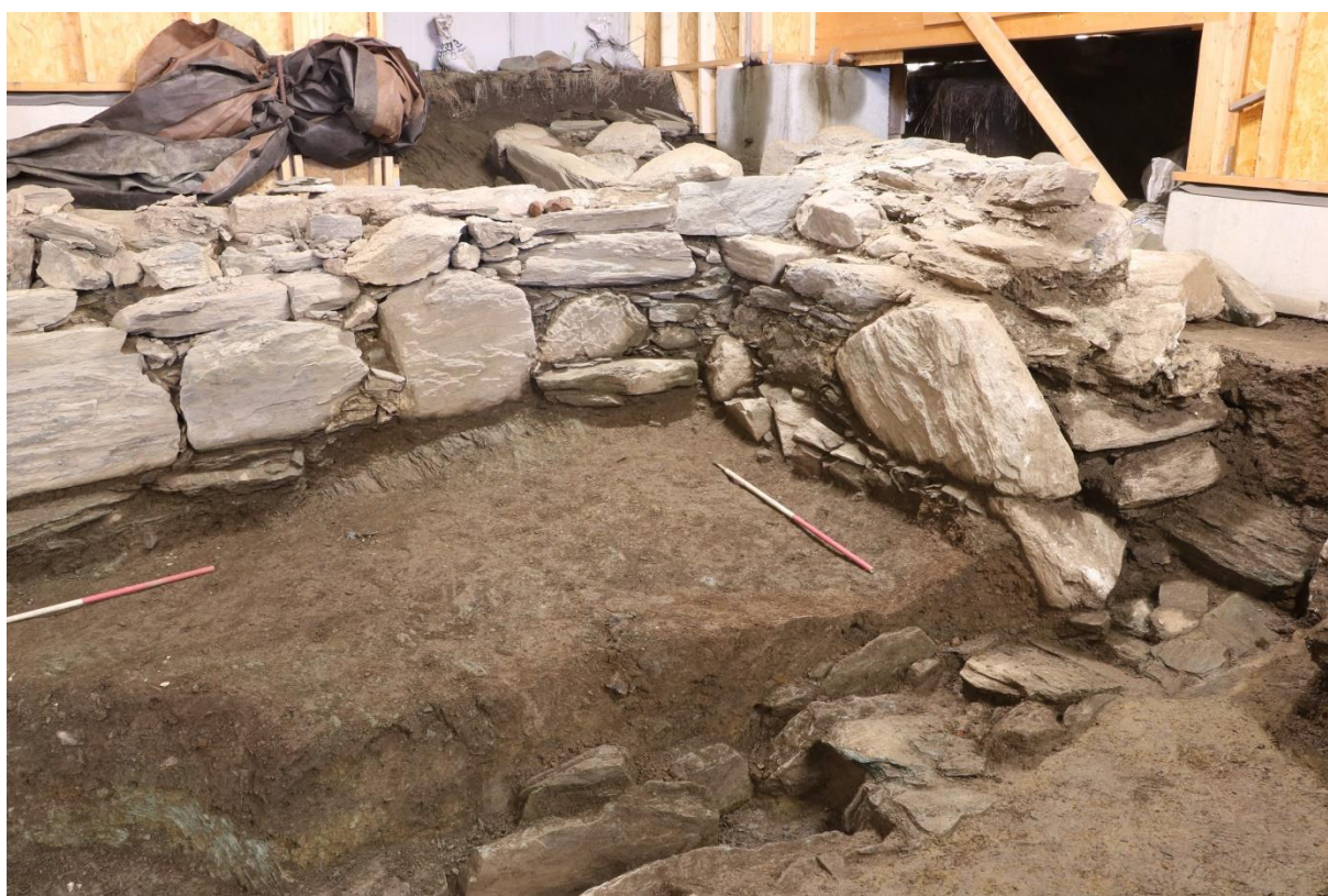
Figur 64. Innsiden av sørmuren i kjelleren sør i SA20, samt sørdelen av vestmuren. Nær vestre ende av sørmuren kommer det grunnfjell opp. Målestokkene er 1 m. Sett mot sørvest. Foto Sf202610.
