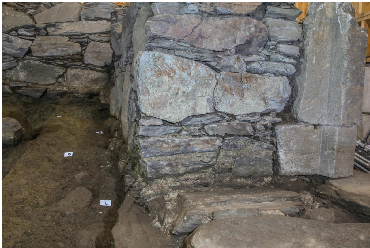
Figur 60. Nordre del av innsiden på østmuren i kjelleren sør i SA20. Mørtelsporene nederst i østmuren, til venstre, viser toppen av sokkelen. Mesteparten av SL4222 er fjernet, men noe ligger igjen i den dypere del. Sett mot nord-nordøst. Foto Sf202928.
