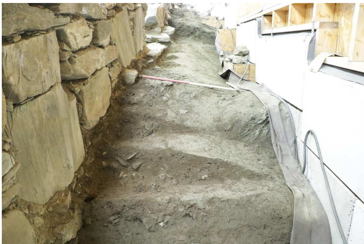
Figur 74. I forgrunnen ser man til venstre et område med utydelig sokkel, der terrenget stiger bratt fra nivået foran kjellerdøra, mot nivået nord for kjelleren. Målestokken ligger på eksponert grunnfjell. Målestanga er 1 m. Sett mot nord. Foto Sf202754.
