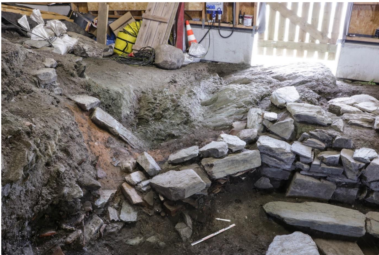
Figur 98. Huggedt forsenkning SA6489 i berg etter gjenmuring. Målestokken er 50 cm. Sett mot øst. Foto Sf202838.
