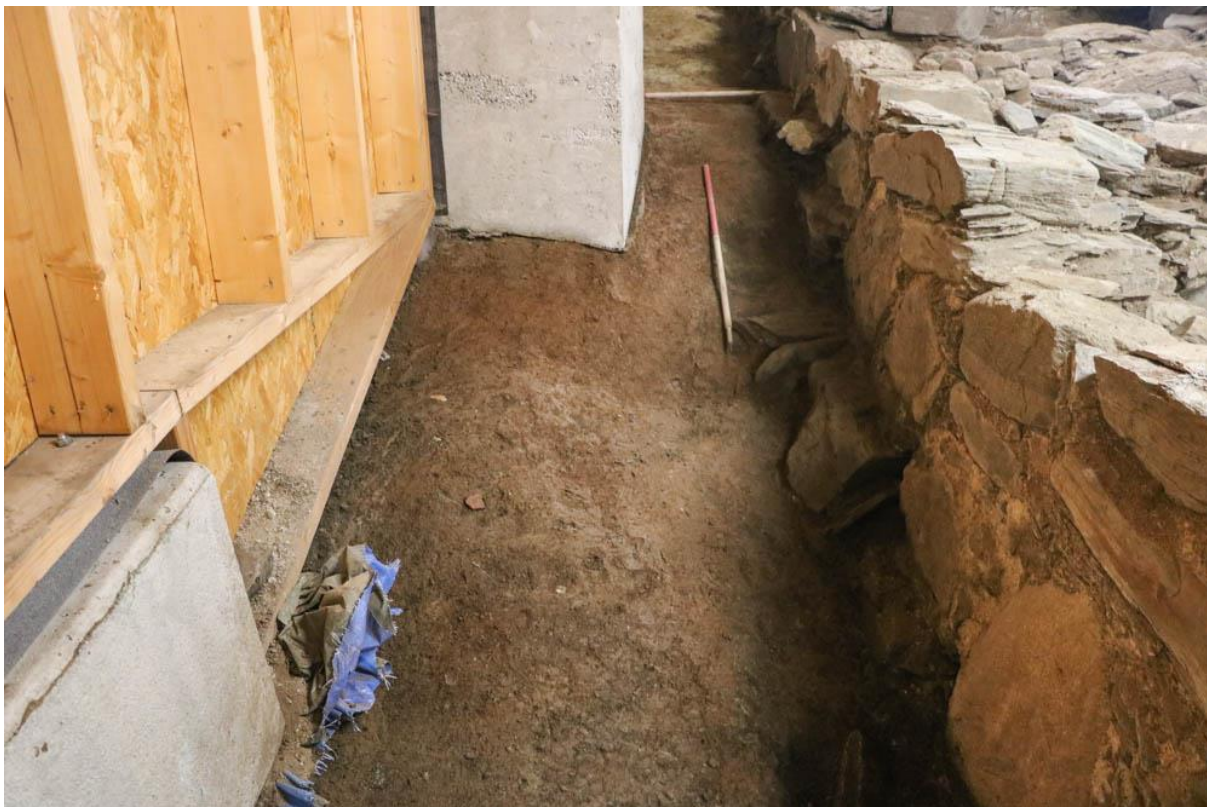
Figur 71. Utsiden av vestmuren til SA20 til høyre. Dette er rett utenfor nordvestre hjørne av kjelleren sør i SA20; terrenget her stiger bratt mot nord, bakerst i bildet ligger muren på grunnfjell. Utsiden av muren var i dette området vanskelig å undersøke på grunn av nærheten til vernebygget. Målestanga er 1 m. Sett mot nord. Foto Sf202672.
