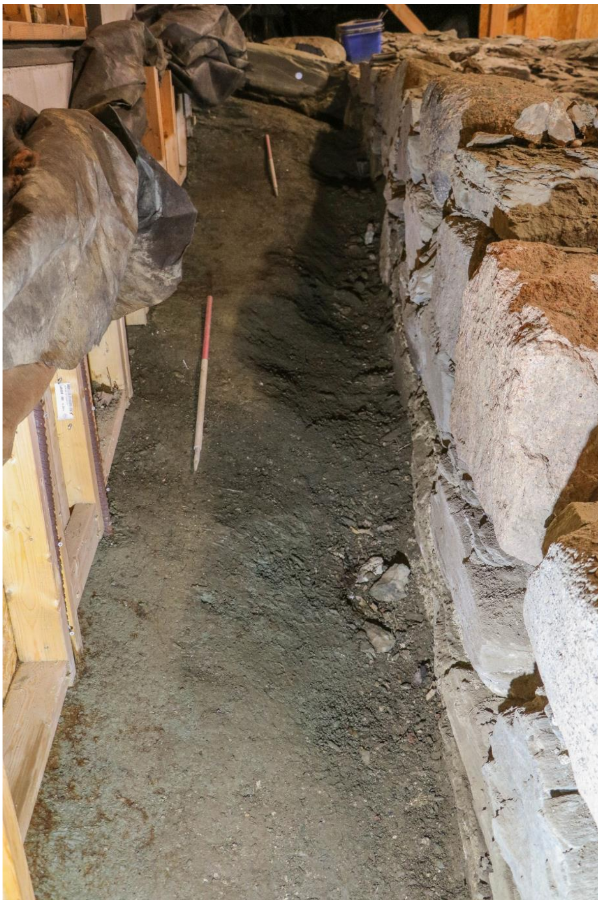
Figur 70. Sørsiden av SA20. Det er ingen synlig sokkel langs dette murpartiet, men det kan se ut som om grunnfjellet er hugget litt til. Målestanga er 1 m. Sett mot vest. Foto Sf202618.
