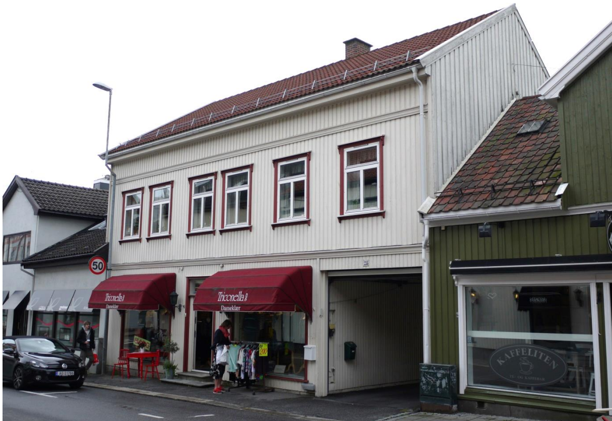
01050205032: I 3. omdrev er det i tillegg til A-, B- og C-endringer registrert blant annet om bygningen er tilbakeført til eldre uttrykk, slik som denne forretningsgården i Glens gata i Sarpsborg sentrum, hvor blant annet eternittplater er skiftet ut med stående panel på fasadens 2. etasje. Foto ÅD/NIKU 2014
