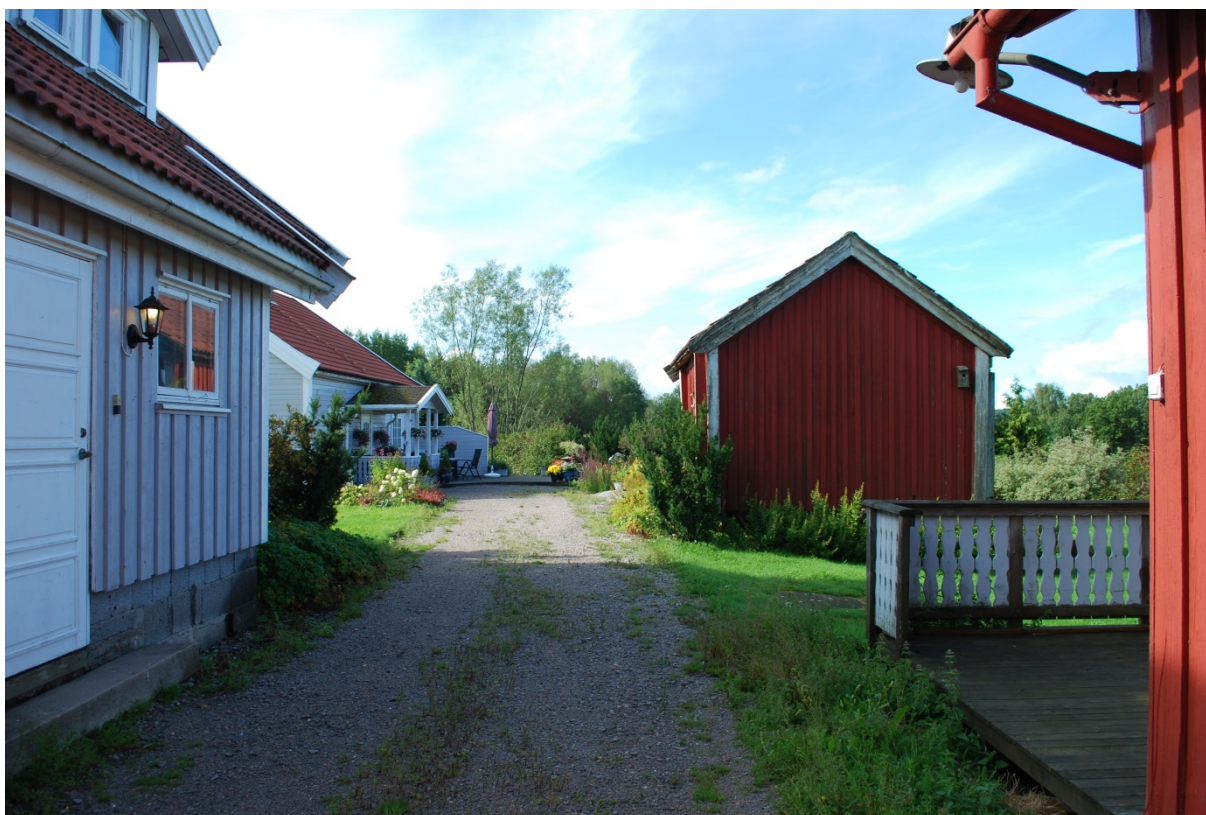
01140102001: Av de undersøkte SEFRAK-bygningene i Sarpsborg kommune i 3. omdrev er det de mindre uthusene som har høyest tapsandel, som i 2. omdrev. Det er også i denne bygningsgruppen man finner den største andelen truede og sterkt truede hus (16 %). Foto: KL/NIKU 2014
