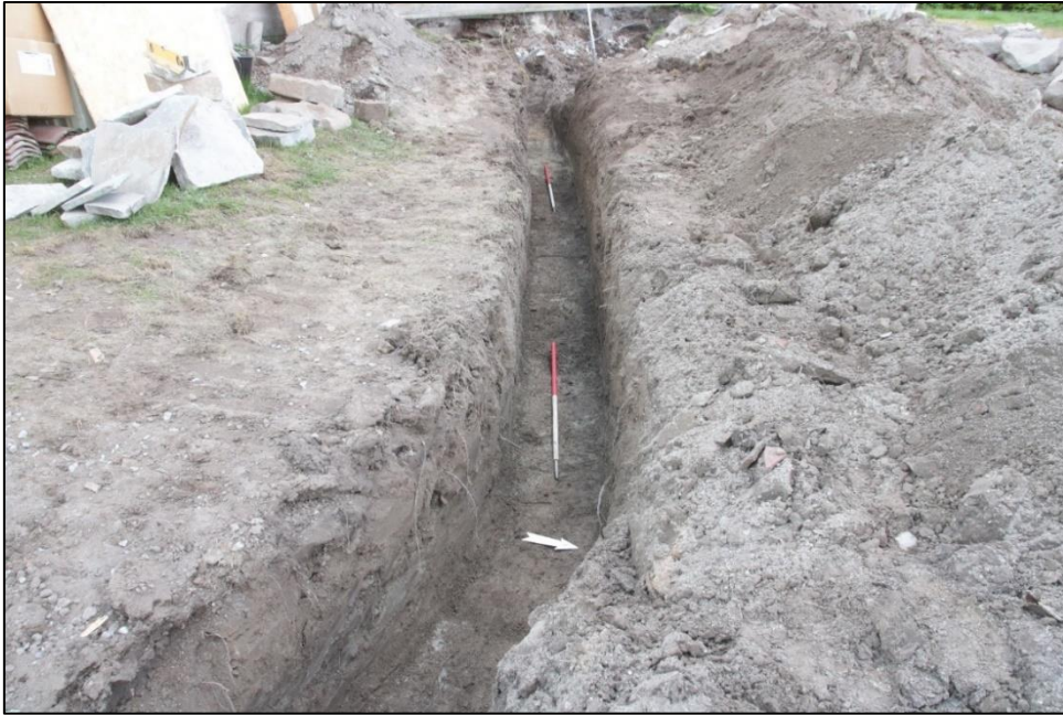
Figur 5. Dreningsgrøften sett fra Ø-enden. Sett mot SV. Cf53949_NIKU_898037.
