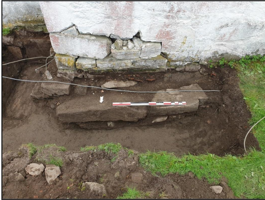
Figur 2. De to sokkelsteinene inntil det nordøstre hjørnet av kirkeskipet, foto av NIKU.
