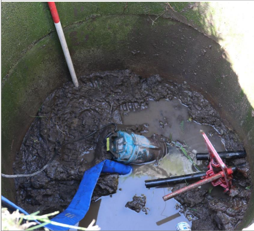
Figur 6. Kum, ferdig gravd. Mot SV. Cf53909_NIKU_0005.JPG.
