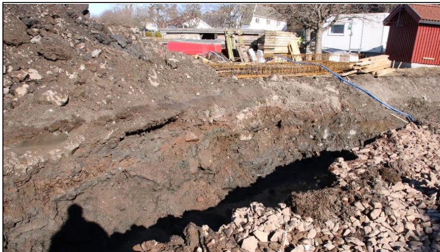
Figur 21 Cf53898_NIKU_0020.jpg Nordre profil, midtveis i grøft, mot nord.
