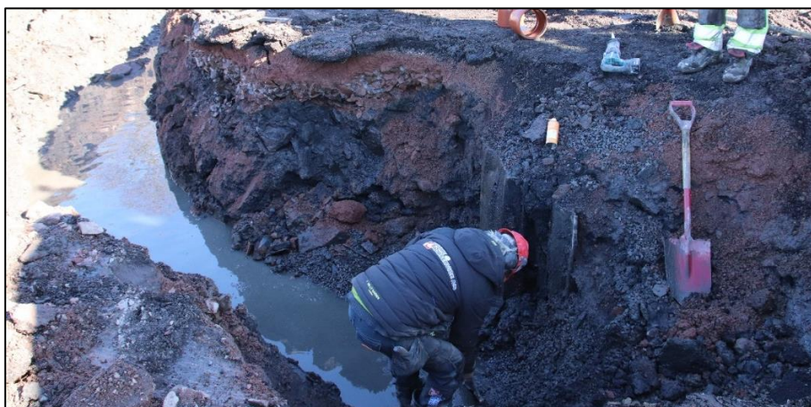
Figur 22 Cf53898_NIKU_0021.jpg Vestre ende av grøft, mot øst
