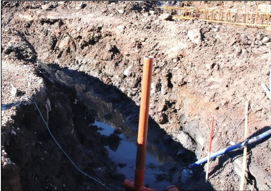
Figur 20 Cf53898_NIKU_0023.jpg Østre ende av grøft, mot nordvest
