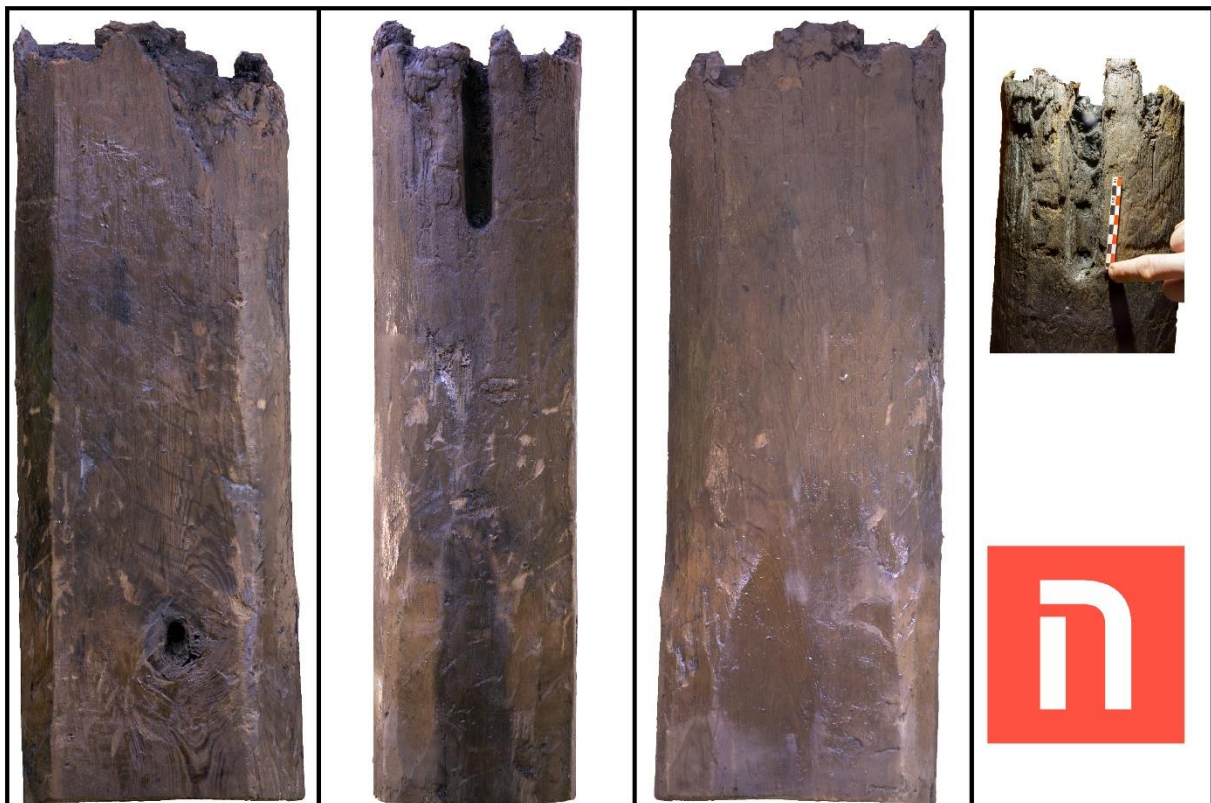
Figur 134: Stolpe 34453 etter opptak og vask. De tre hovedfotoene viser stolpen fra ulike vinkler, hvor glepphoggingen er spesielt synlig på fotoet til venstre. Det midtre fotoet viser den langsgående noten som svillstokken og veggplankene vil ha festet i. Det innfelte fotoet øverst til høyre er et nærbilde av den langsgående noten hvor fordypningene etter skjeboret er synlige (Da63305).
