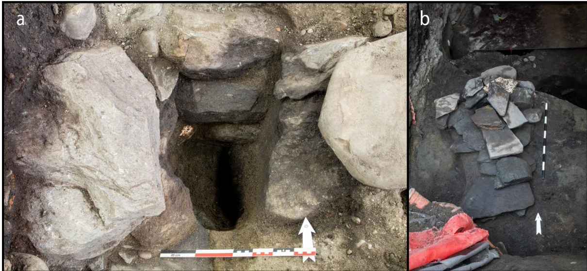
Figur 183: (a) Stolpehull 15035 i korskillefundament 17335 (Da62830_1805). (b) Stolpehull 42746 i korskillefundament 42711. Stolpehullet synes ikke så godt, da flere av steinene i fundamentet delvis hadde sklidd utover og dekket over det (Da62830_4243).
