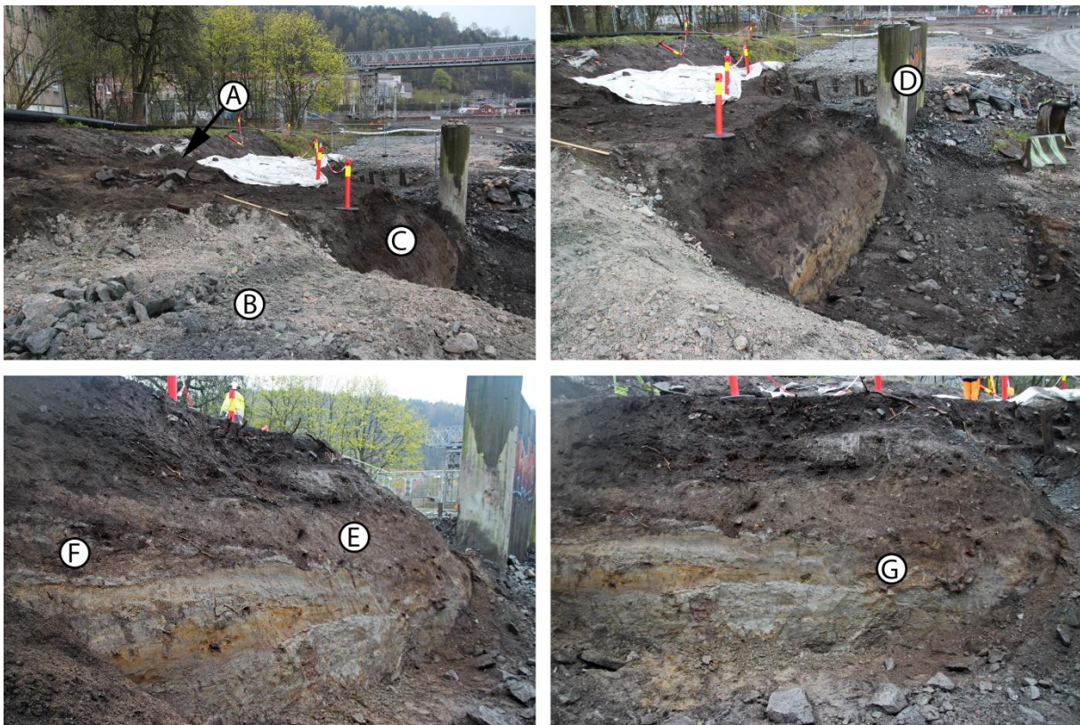
Figur 27 Området i tidlige stadier av utgravningen. A) Steinkjeller SA200, B) rampe til gravemaskin, C) profil C1345, D) betongsokkel for gangbro, E) grøft SK6601, F) grøft SK5603, G) grøft SK6093.
