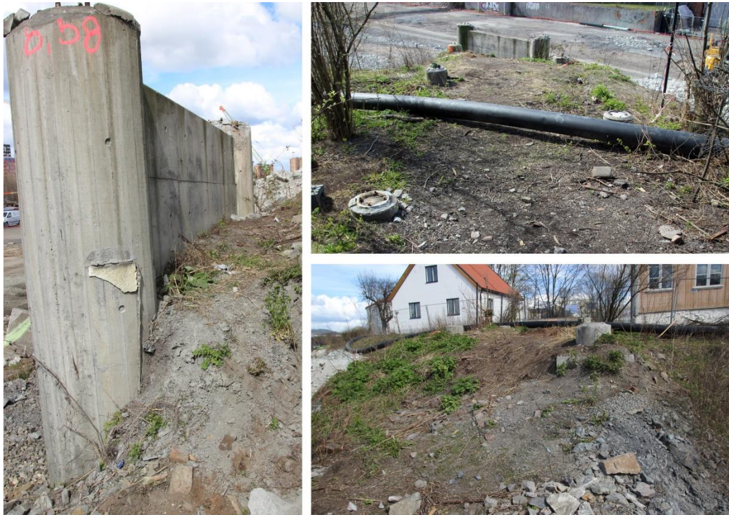
Figur 24 Området før utgravning. Brofundamentet besto av betongsokkelen i vest (venstre) samt fire løst funderte, sirkulære betongføtter (best synlig øverst til høyre). Øverst til høyre utsikt mot vest, under mot øst.
