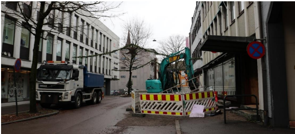
Figur 6 Graving i Øvre Langgate, oversiktsbilde. Cf53882_NIKU_0027.JPG
