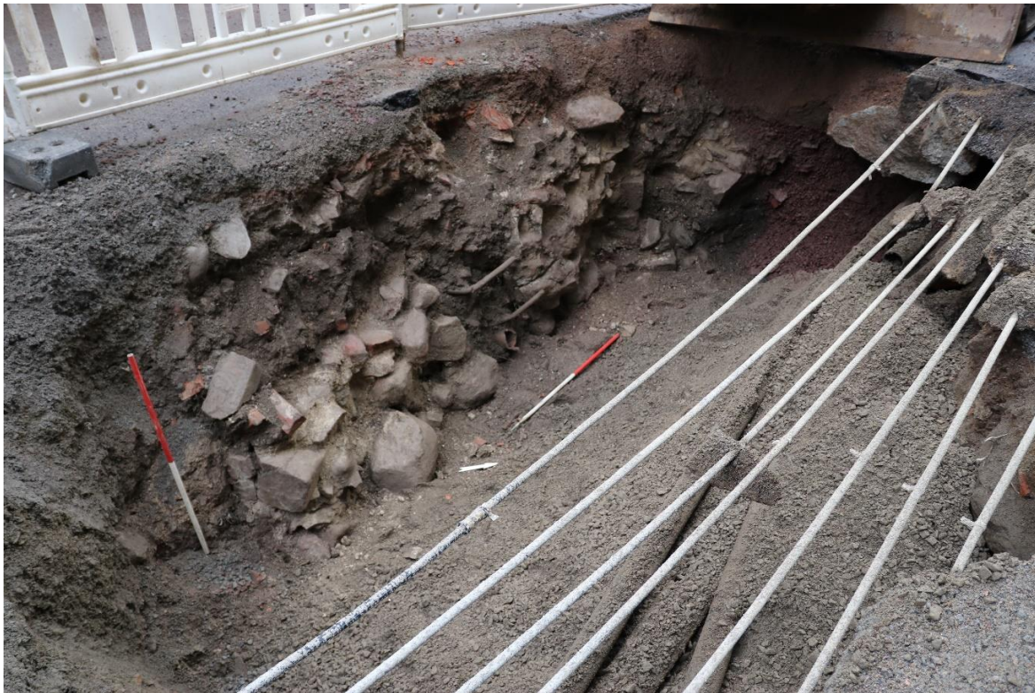
Figur 9 Oversiktsbilde, mot SV. Cf53882_NIKU_0006.JPG
