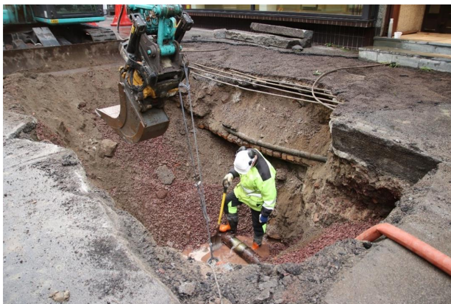
Figur 1 Reparasjon av vannlekkasje, grøft A. Cf53882_NIKU_0029.JPG
