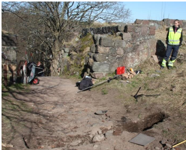
Figur 28 Arbeidsbilde ved sjakt 5, mot nord, nordre port i ringmuren i bakgrunnen. Foto: niku_ark_3225054
