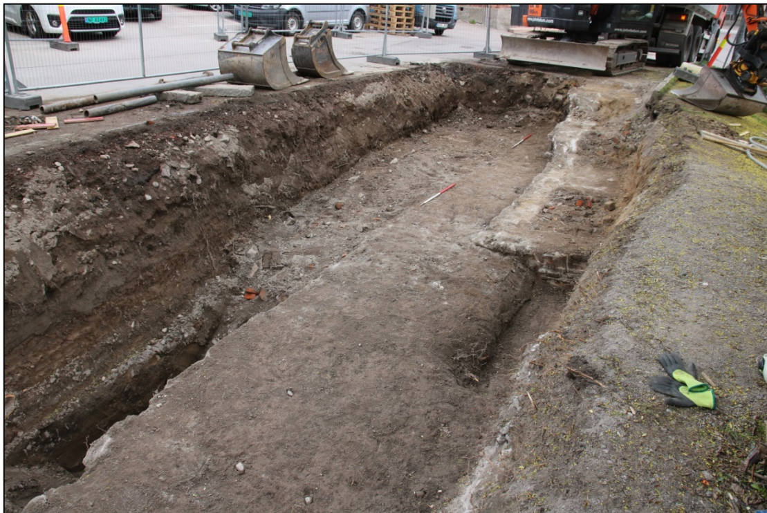
Figur 36. Avfallskontainergrop OU7780 med husmur M7803 og vannledningsgrøft M7848. Cf53307_NIKU_874234.
