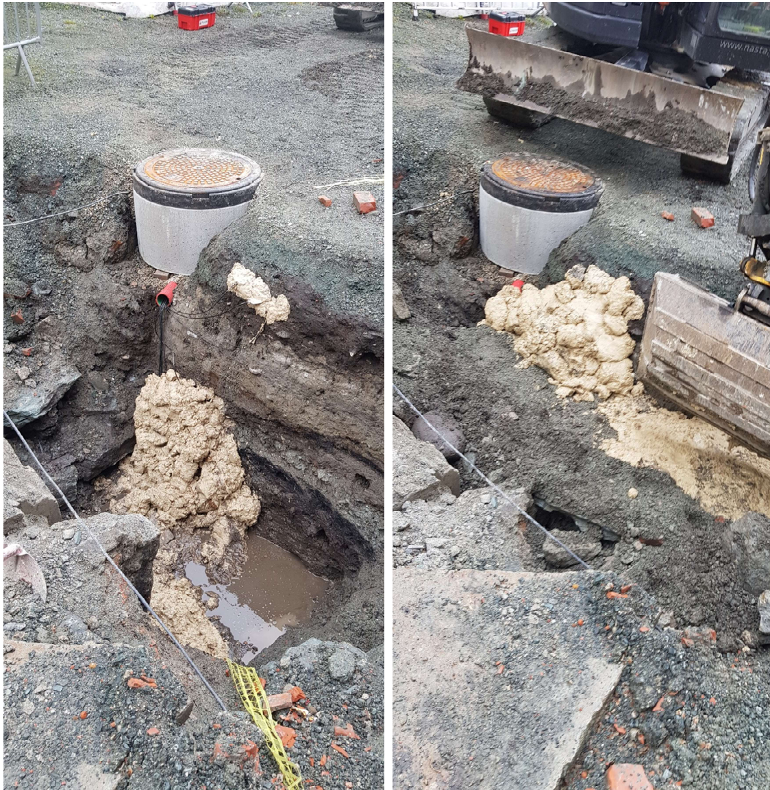
a) b) Figur 13. Komplettering og tildekking med leire av miljøprofil 1.
