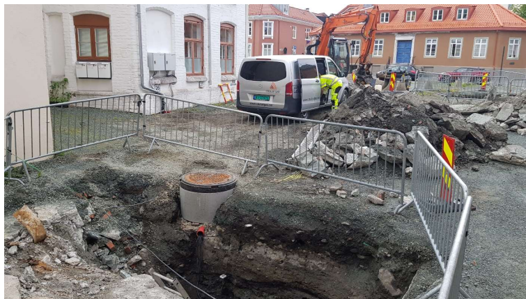
Figur 3. Plasseringer for miljøprofiler, Erling Skakkes gate.
