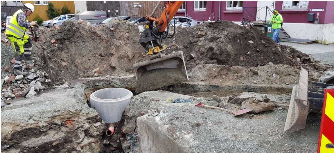
Figur 5: Montering av kum og trekking av rør ved miljøprofil 2
