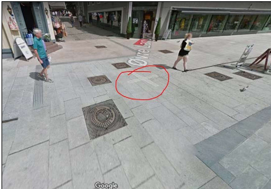
Figur 1. Situasjonsplan medfulgt søknad. Vannlekkasjen markert med rød ring.
