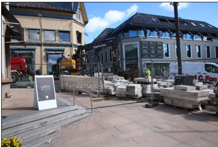
Figur 2. Oversikt tiltaksområdet krysset Øvre Langgate/Torvet. Sett mot NØ. Cf53903_NIKU_889625.
