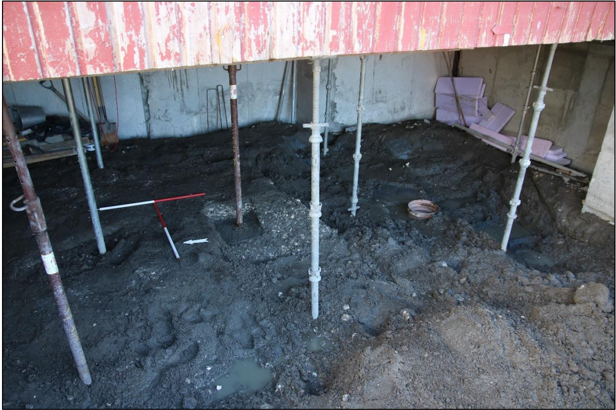
Figur 3. Tiltaksområde med nedgravning SK14019 til høyre og lag SL14025 til venstre. Sett mot ØNØ. Cf53878_NIKU_866305.
