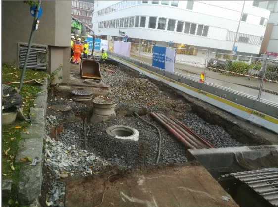
Figur 9: Masser påfylt omkring ny VA kum 10.10.2019. Foto: NIKU 2019.
