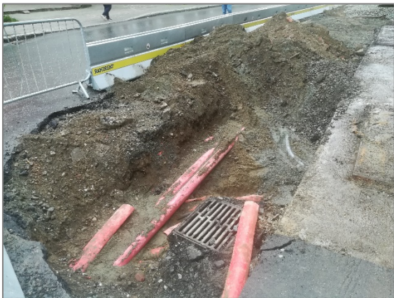
Figur 2: Fortau og masse fjernet 26.09.2019 nord i tiltaksområdet. Foto: NIKU. 2019.
