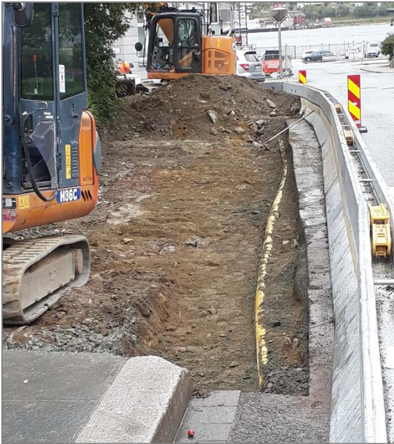
Figur 1: Oppstart 06.09.2019. Foto: NIKU 2019.
