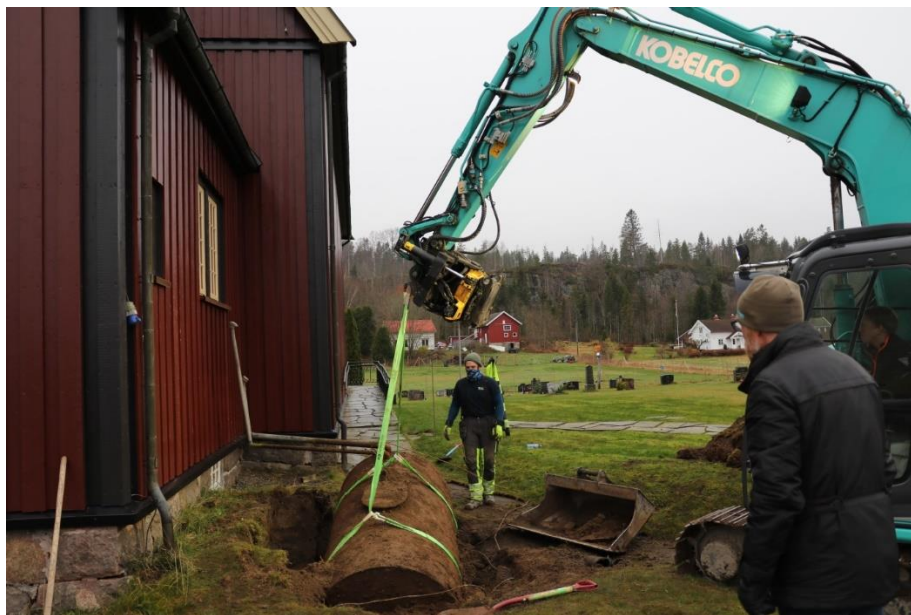
Figur 1 Cf53881_NIKU_0009.JPG, Oljetanken blir løftet opp.
