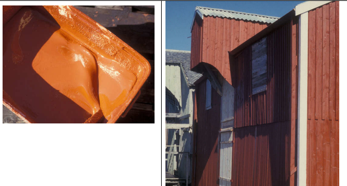
Tranmaling produsert og brukt på Myken. Bildet til venstre viser malingen i bøtta ferdig til bruk. Bildet til høyre viser den nymalte veggen.
