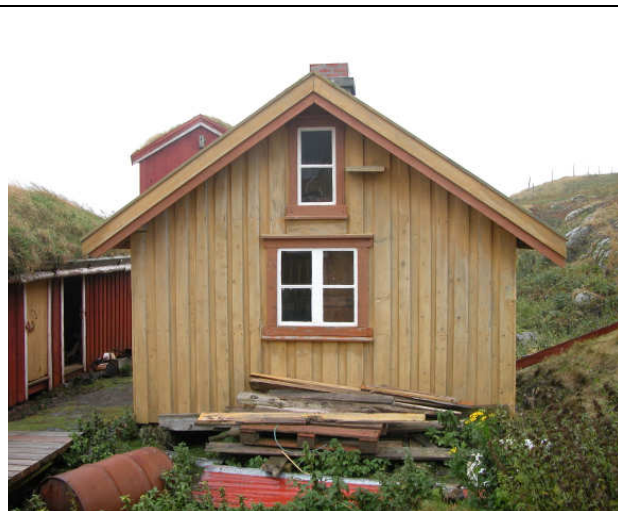
Skjærvær. Bygning 8. Bakstehus. Bygningen står med den okergule komposisjonsmalingen som ble påført mange av bygningene på Skjærvær etter fredningen i 1995
