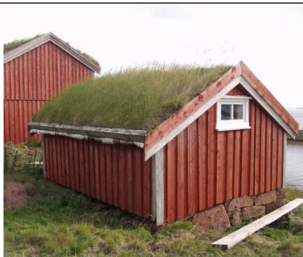
Skjærvær. Bygning 16. Sau- og grisehus. Bygningen står med den røde komposisjonsmalingen som ble påført mange av bygningene på Skjærvær etter fredningen i 1995.
