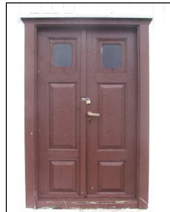
Døra inn til butikken på Tåvær. Denne døra var det elementet med flest fargelag innenfor prosjektet.
