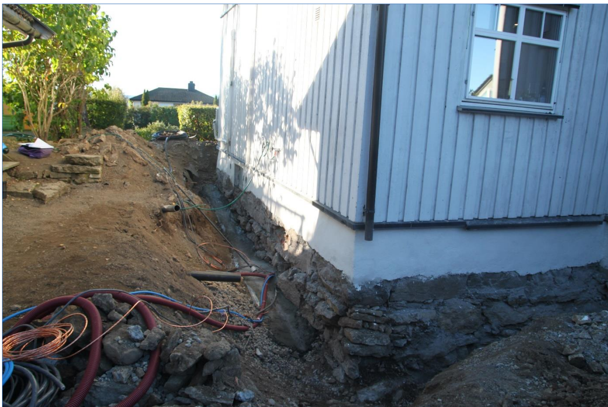
Figur 4. Oversiktsfoto grøft på østsiden av Korsgata 31. Mot S. Foto Hilde R. Amundsen 2020 (Cf53897_NIKU_02).
