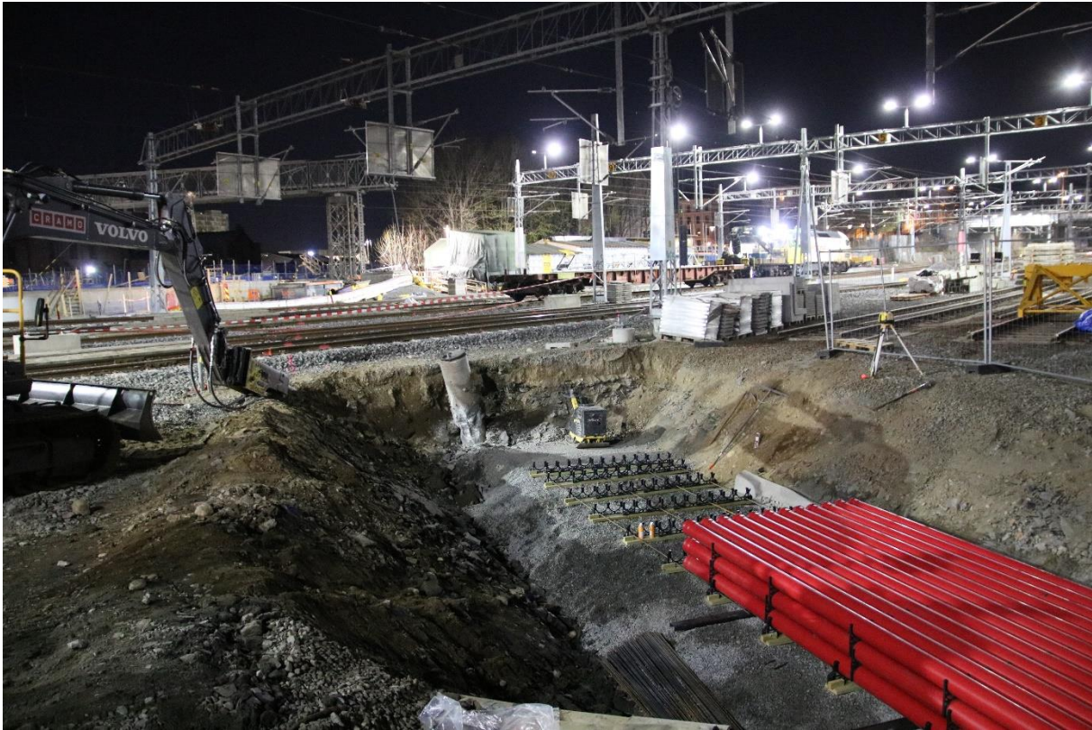
Figur 9: Nattarbeid hvor det etableres OPI-kanal/føringsrør. Sett mot nord. Foto: Cf53705_NIKU_030.
