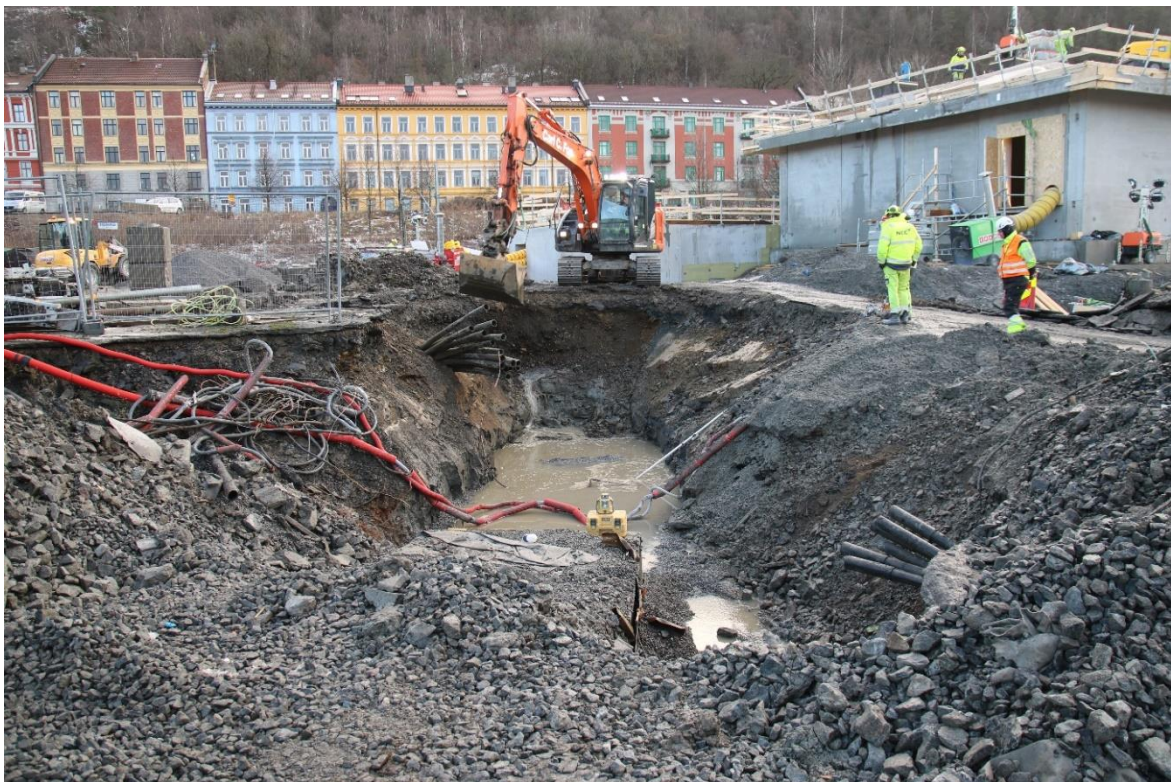
Figur 11: Grøft for føringsrør graves inn på «Militærrampa» på Loenga. Sett mot sør. Foto: Cf53705_NIKU_114.
