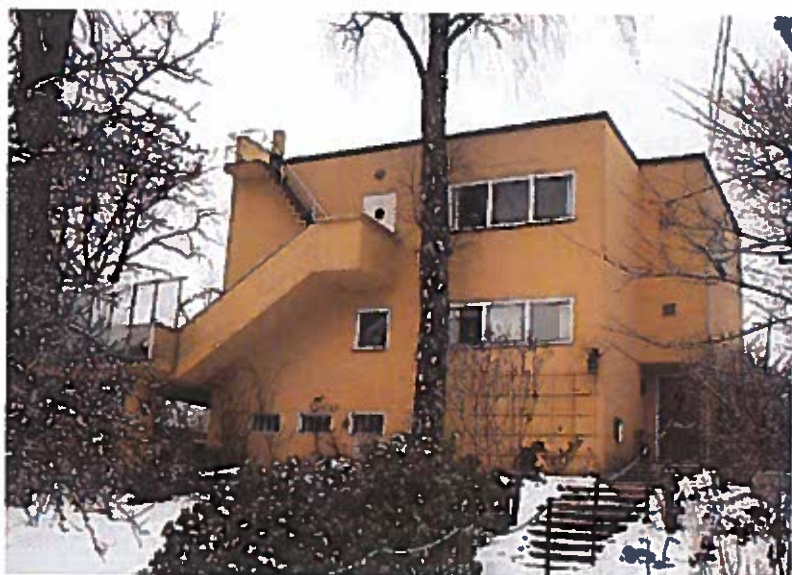
FIGUR 1. Utendørs trapp. Flatt tak, vindusbånd. Taket brukt som terrasse. Havna allé nr. 9, Villa Bryn, Oslo. Aasland/Korsmo. FOTO: NIKU/AC Flyen, 2017.
