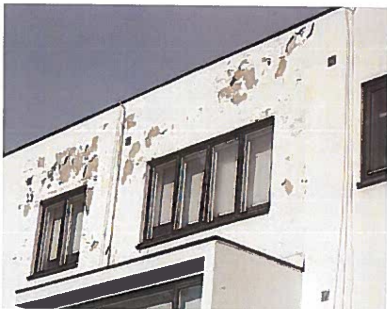
FIGUR 8. Vann fra flate tak trenger inn i veggkonstruksjonen og fører til stor påkjenning på mur og puss og dessuten på avflassing av maling. Vinduene har minimalt med beskyttelse ettersom de står langt ute i vegglivet og det heller ikke er overdekning fra noe takutspring. FOTO: NIKU/A.C. Flyen, 2013.
